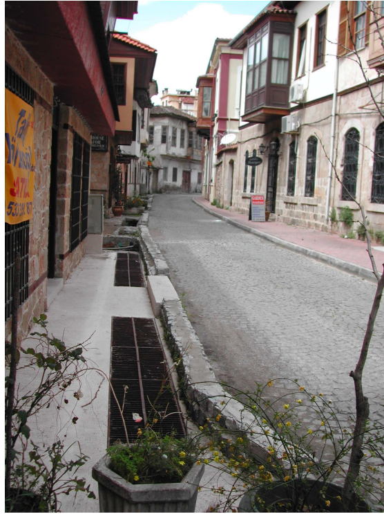
Şekil 3.56 Kaleiçi Sokaklarında, Evlere Su Sağlayan Kanallar (Nisan 2007) Fotoğraf:Selin Doğu
