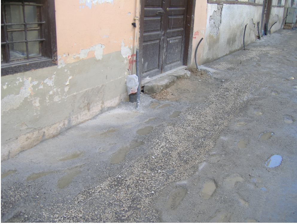
Şekil 3.61 Kaleiçi Sokaklarındaki Kanalların Üzeri Kapatılmış Görüntüsü (Aralık 2007) Fotoğraf:Selin Doğu
