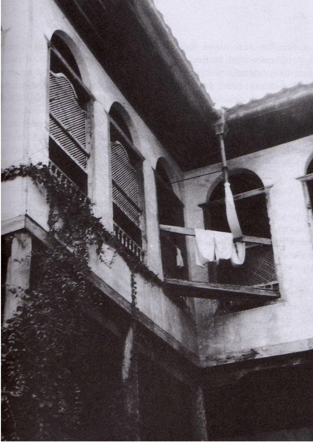
Şekil 3.68 Kaleiçi Evlerindeki Yağmur İniş Borusu (Bektaş, 2004, s:13)
