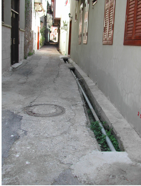
Şekil 3.58 Kaleiçi Sokaklarında, Evlere Su Sağlayan Kanallar (Nisan 2007) Fotoğraf:Selin Doğu
