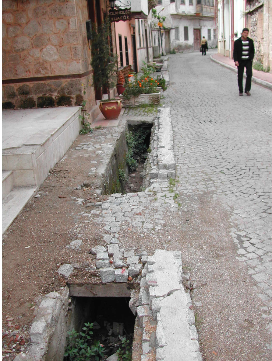
Şekil 3.54 Kaleiçi Sokaklarında, Evlere Su Sağlayan Kanallar (Nisan 2007) Fotoğraf:Selin Doğu
