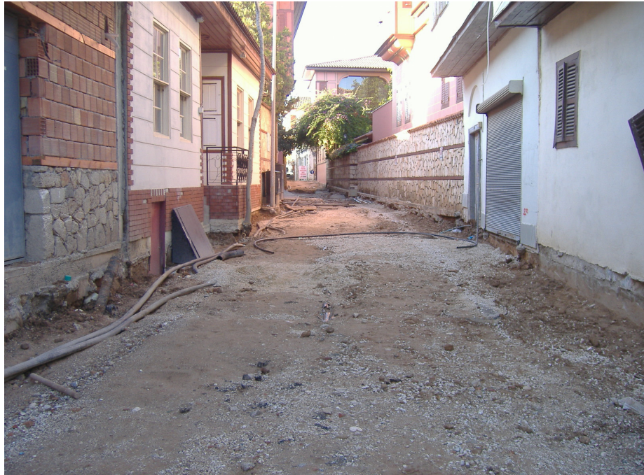
Şekil 3.62 Kaleiçi Sokaklarındaki Kanalların Üzeri Kapatılmış Görüntüsü (Aralık 2007) Fotoğraf:Selin Doğu
