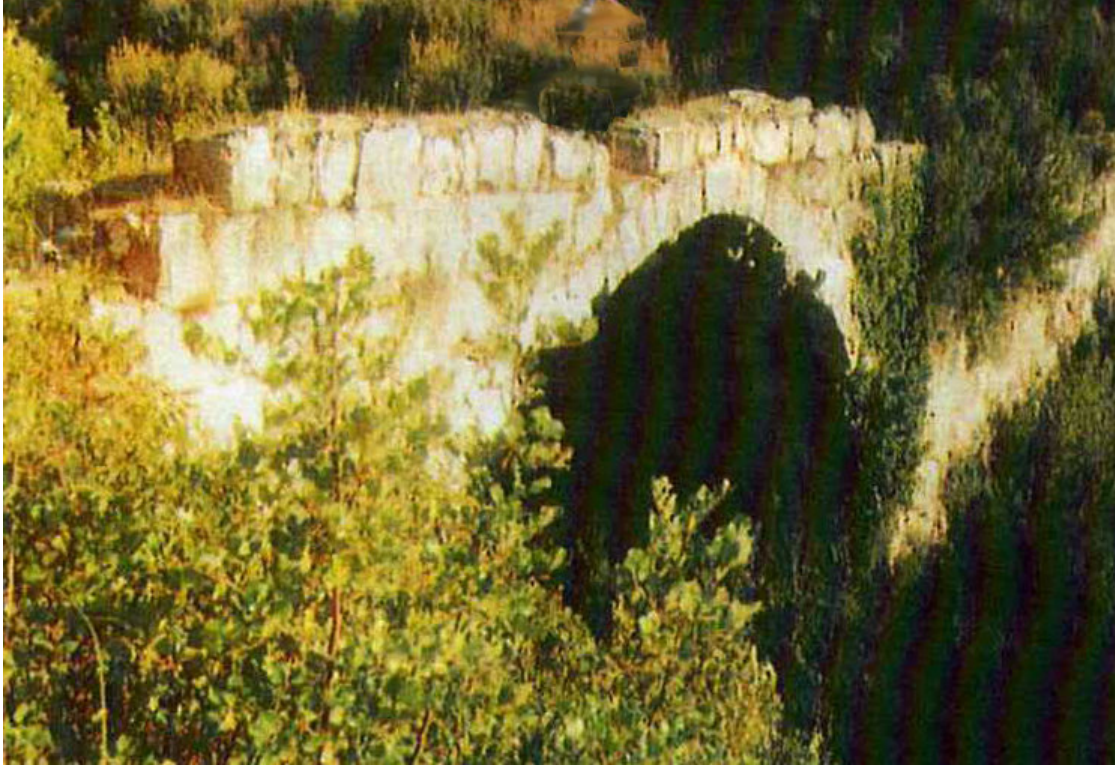
Şekil 3.23 Eğridere Su Köprüsü (Büyükyıldırım, 1994)
