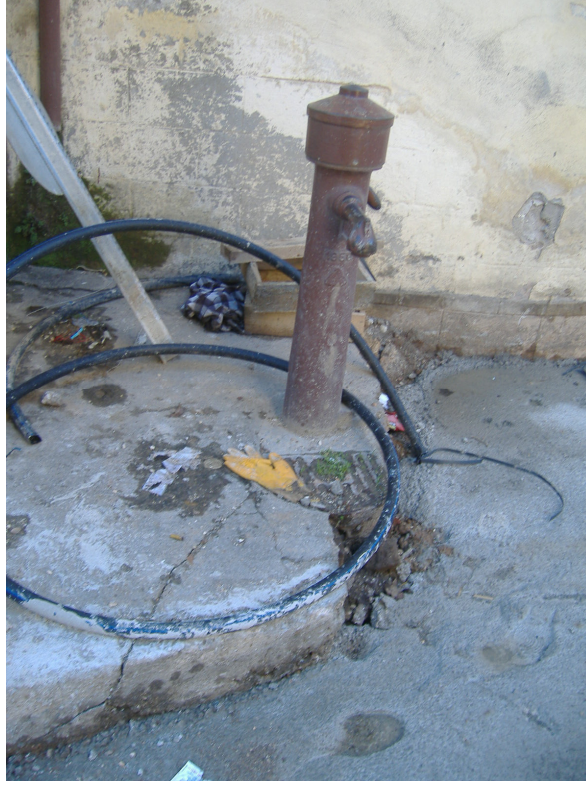
Şekil 3.63 Kanallar Kapatıldıktan Sonra Tulumbanın Görüntüsü (Aralık 2007) Fotoğraf:Selin Doğu
