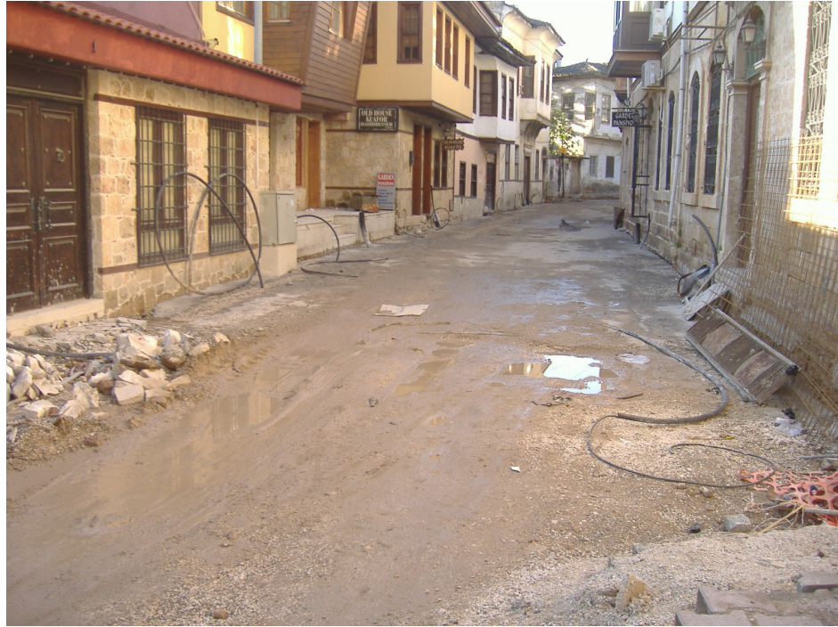
Şekil 3.60 Kaleiçi Sokaklarındaki Kanalların Üzeri Kapatılmış Görüntüsü (Aralık 2007) Fotoğraf:Selin Doğu
