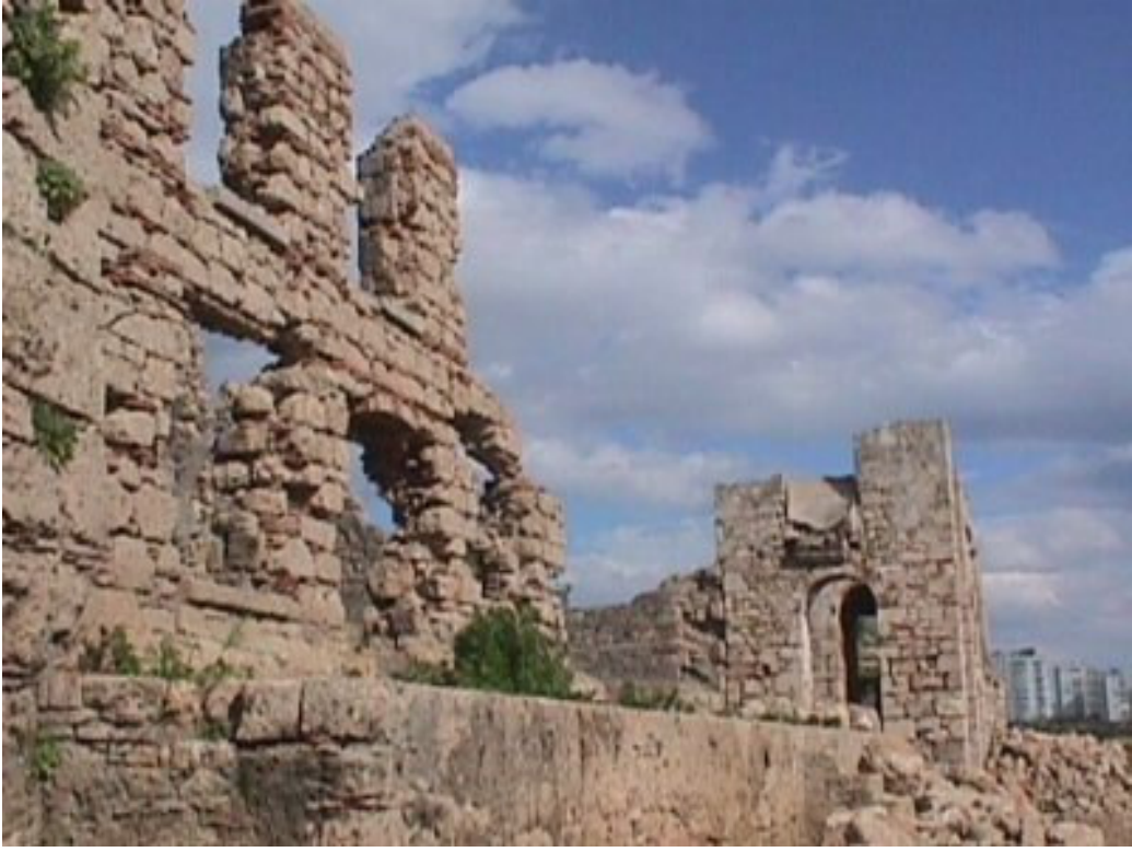
Şekil 3.65 Düden Nehri'nden Gelen Suyla Çalışan Değirmen ve Un Fabrikasının Kalıntıları (Hüseyin Çimrin)
