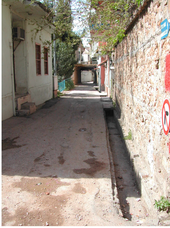
Şekil 3.57 Kaleiçi Sokaklarında, Evlere Su Sağlayan Kanallar (Nisan 2007) Fotoğraf:Selin Doğu
