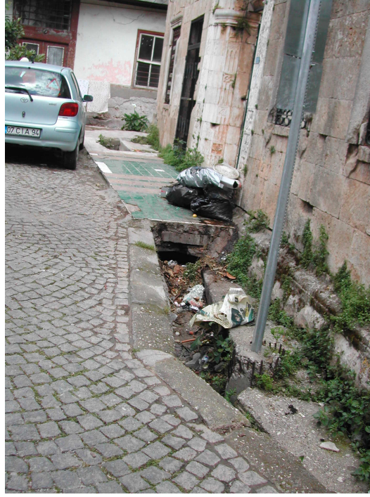
Şekil 3.55 Kaleiçi Sokaklarında, Evlere Su Sağlayan Kanallar (Nisan 2007) Fotoğraf:Selin Doğu
