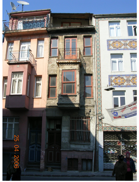
Şekil 5.39 Tek katlı cumba örneği, 2307 ada
