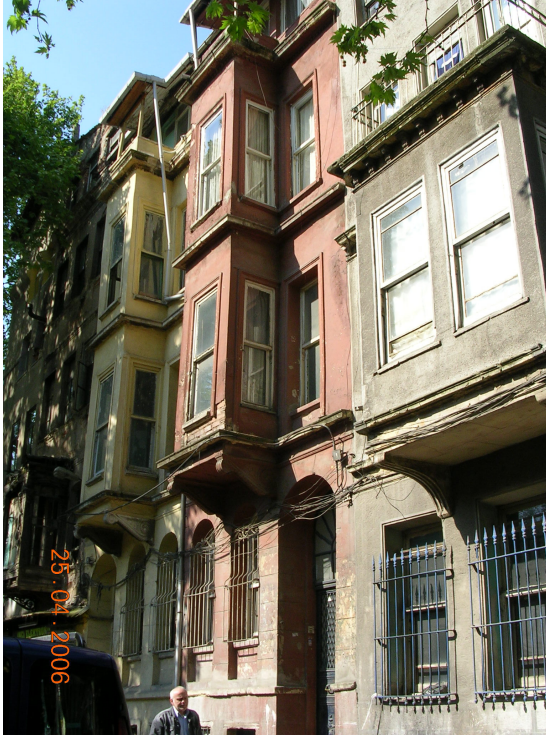
Şekil 5.38 İki katlı cumba örneği, 2307 ada
