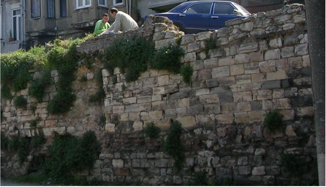
Şekil 6.13 Fener’de geleneksel malzeme örnekleri, taş duvar
