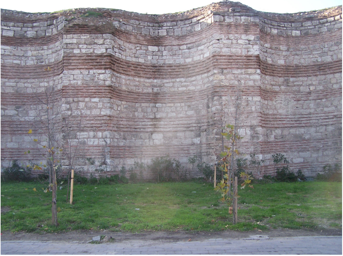
Şekil 4.59 Doğu duvarının dış cephesindeki 4.25 m açıklığındaki nişlerden 9. niş (2007)
