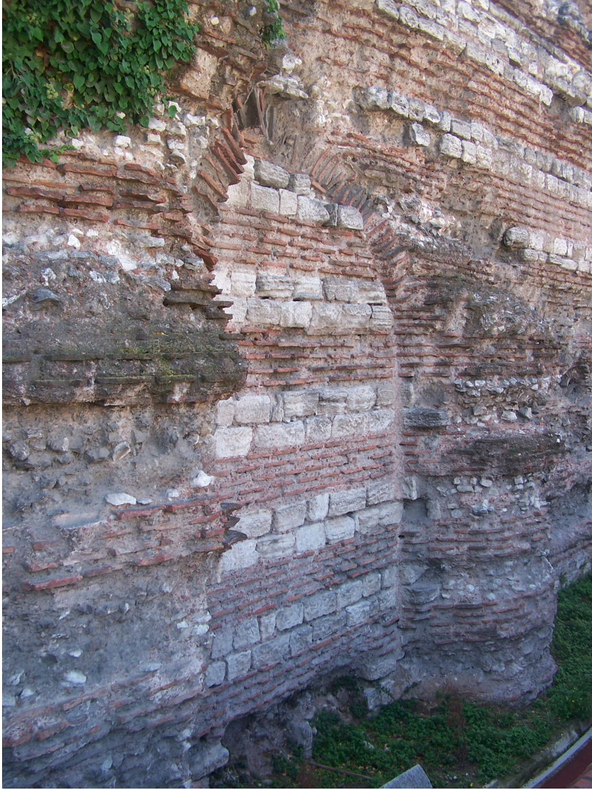
Şekil 4.84 Güney duvarının iç cephesindeki 2.-3. ayaklar arasındaki kemerin kalıntıları (2007)
