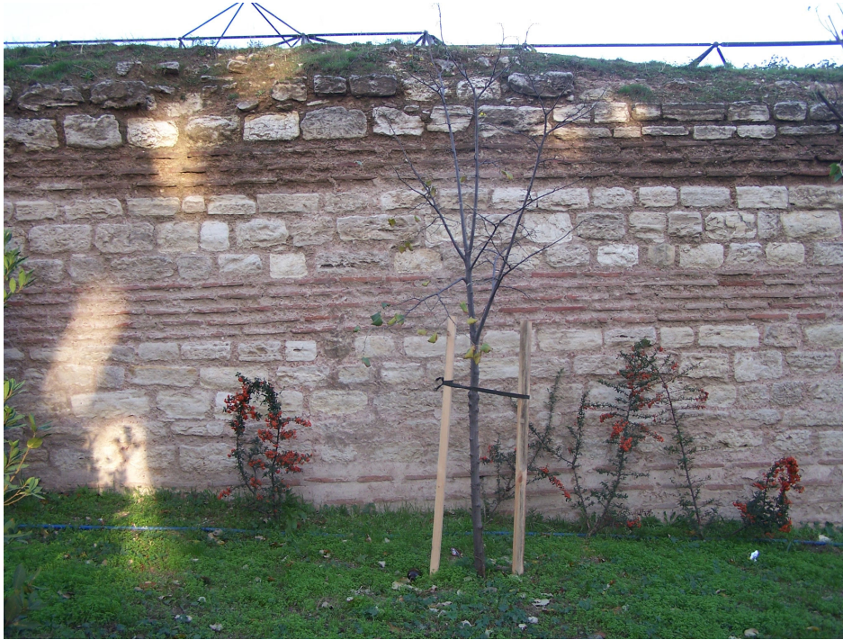
Şekil 5.11 Güney duvarının dış cephesi (2007)
