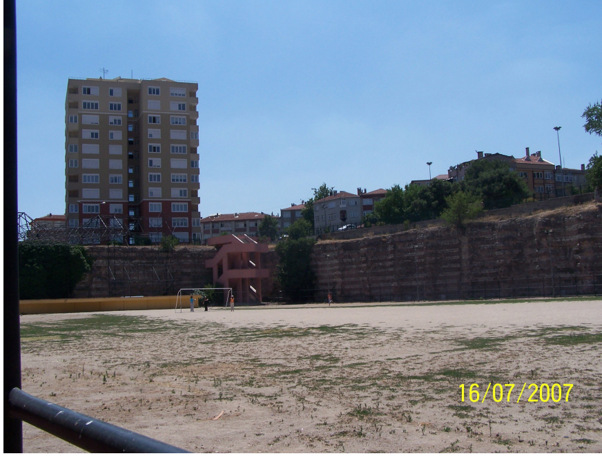
Şekil 4.11 Sarmıcın iç kısmında kuzeyden güneye doğru bir görünüş (2007)
