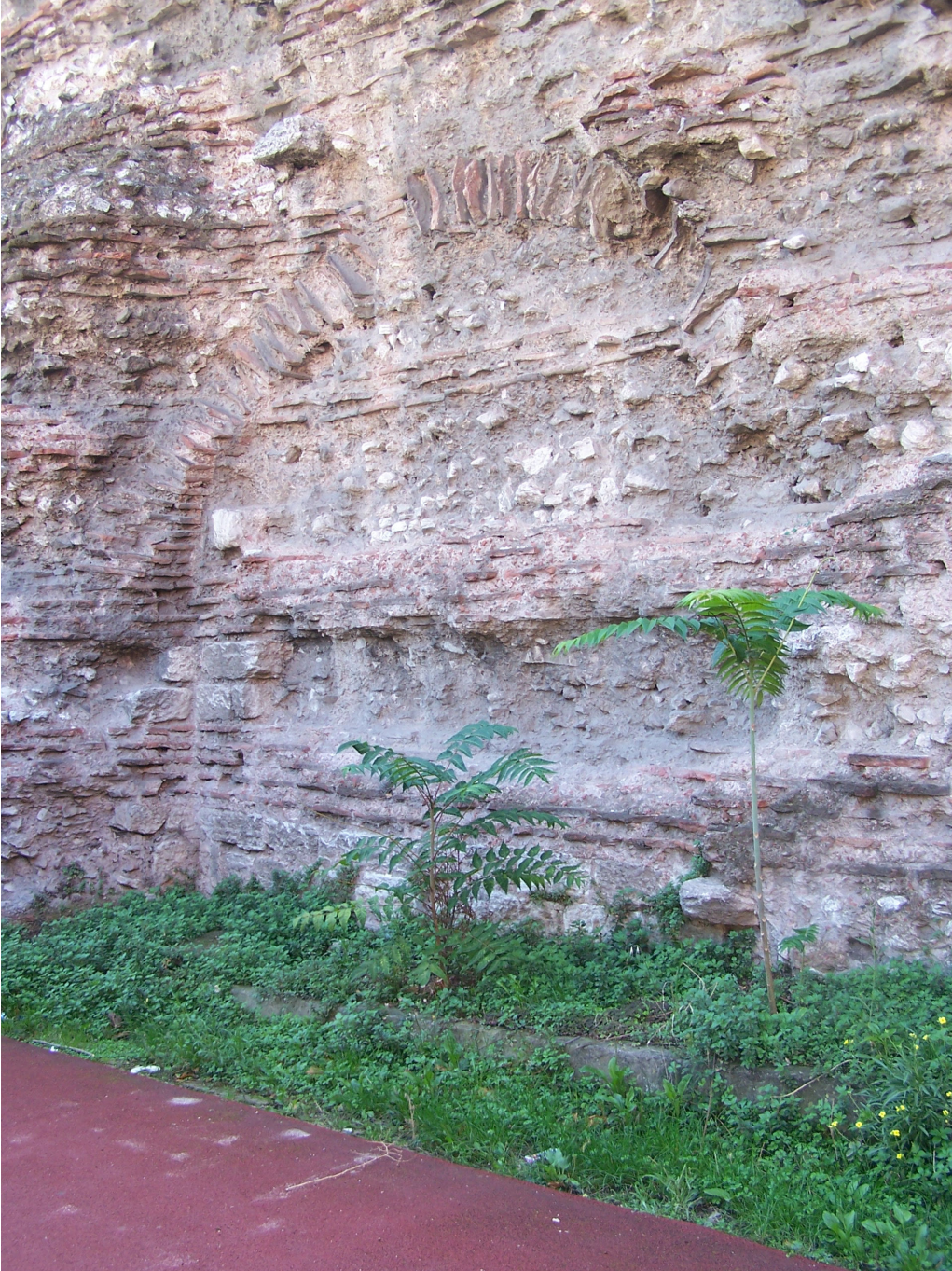
Şekil 4.83 Güney duvarının iç cephesindeki 1.-2. ayaklar arasındaki kemerin kalıntıları (2007)
