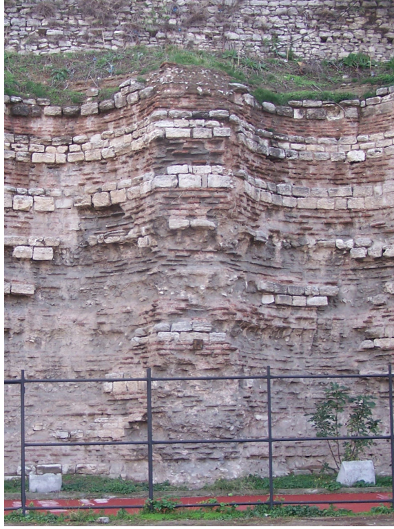
Şekil 4.105 Kalınlığı 1.90 m olan niş duvarlarından kuzey köşeden itibaren 7.-8. niş arasındaki duvar (2007)
