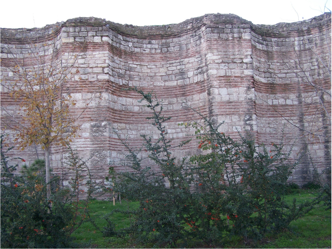
Şekil 4.62 Doğu duvarının dış cephesindeki 4.40 m açıklığındaki nişlerden 18. niş (2007)
