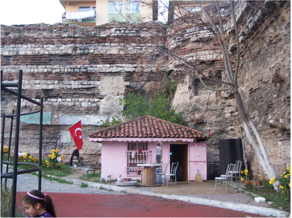
Şekil 4.30 Kuzey ve doğu duvarının birleştiği köşedeki destek duvarı (2007)
