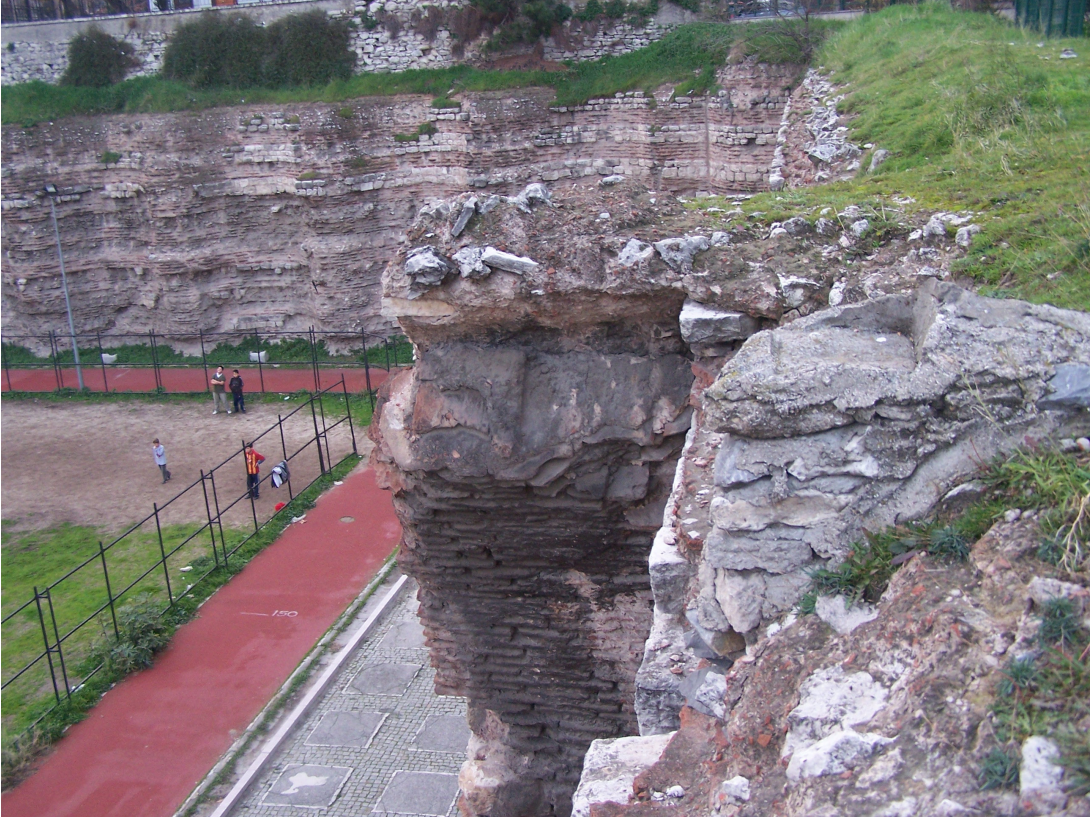
Şekil 4.119 Kuzey duvarının iç yüzeyinde yer alan merdivene ait 3. kemerdeki 50x50x4,5 cm boyutundaki tuğlalar (2007)
