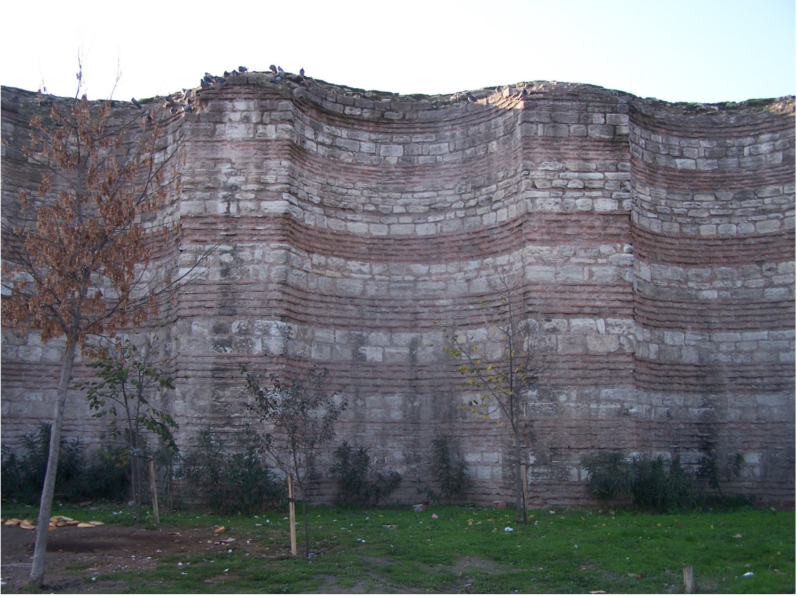
Şekil 4.72 14. nişte 5'ten 6'lıya çıkan taş sırası (2007)
