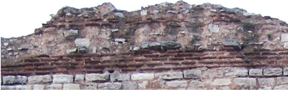
Şekil 4.42 Kuzey duvarında tespit edilen 3 sıralı tuğla hatıl (2007)
