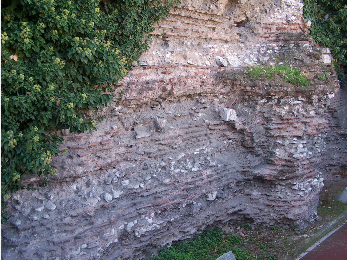
Şekil 4.87 Güney duvarının iç cephesindeki 5.-6. ayaklar arasındaki kemerin kalıntıları (2007)
