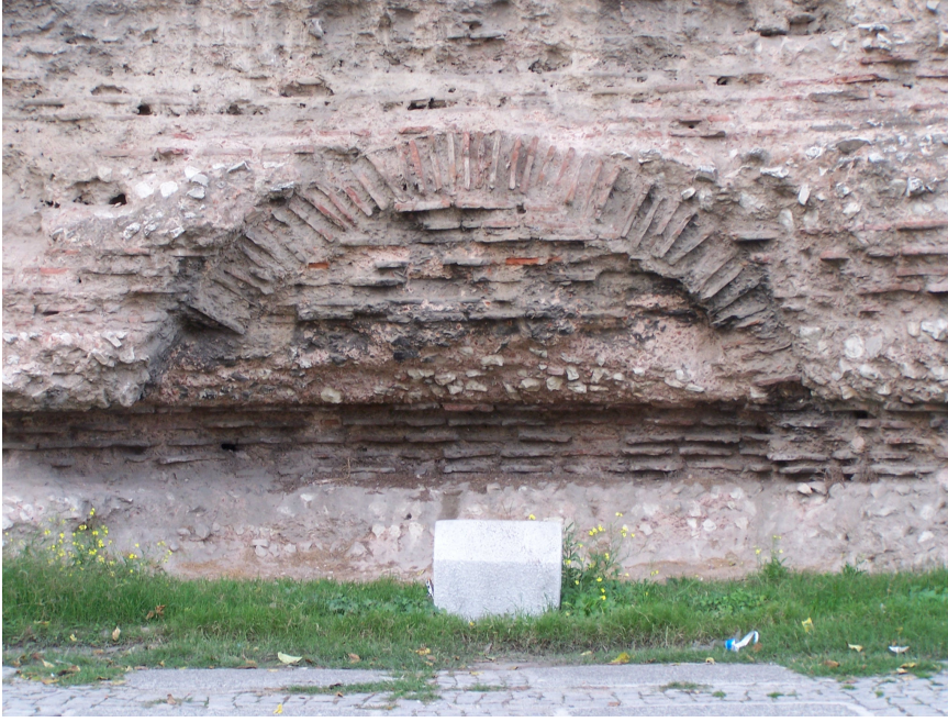
Şekil 4.32 Kuzey duvarının iç cephesindeki 1.-2. ayaklar arasındaki kemerin kalıntıları (2007)
