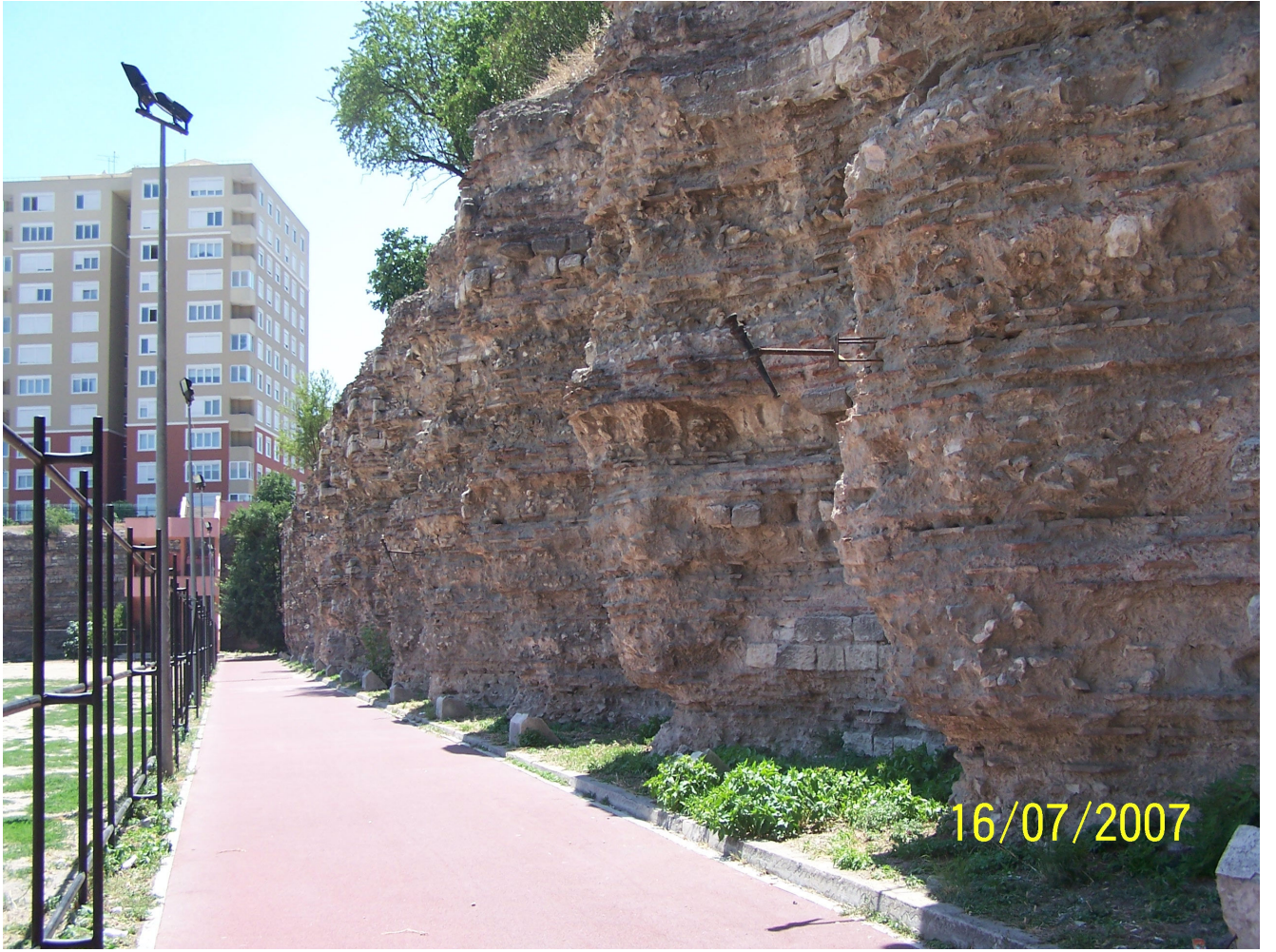
Şekil 4.24 Batı duvarının iç cephesindeki yarım daire planlı nişlerin genel görünüşü (2007)
