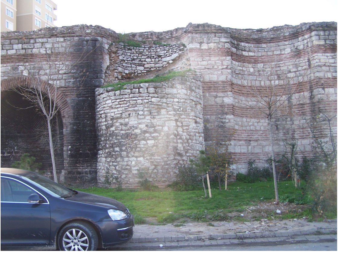
Şekil 4.64 Doğu duvarının dış cephesindeki dairesel planlı merdiven yapısı (2007)
