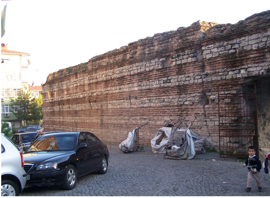
Şekil 5.10 Kuzey duvarının dış cephesi (2007)
