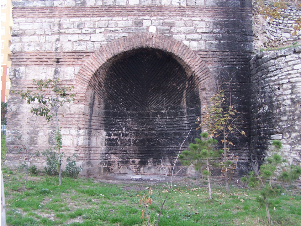
Şekil 4.67 Doğu duvarının dış cephesindeki 21. niş (2007)
