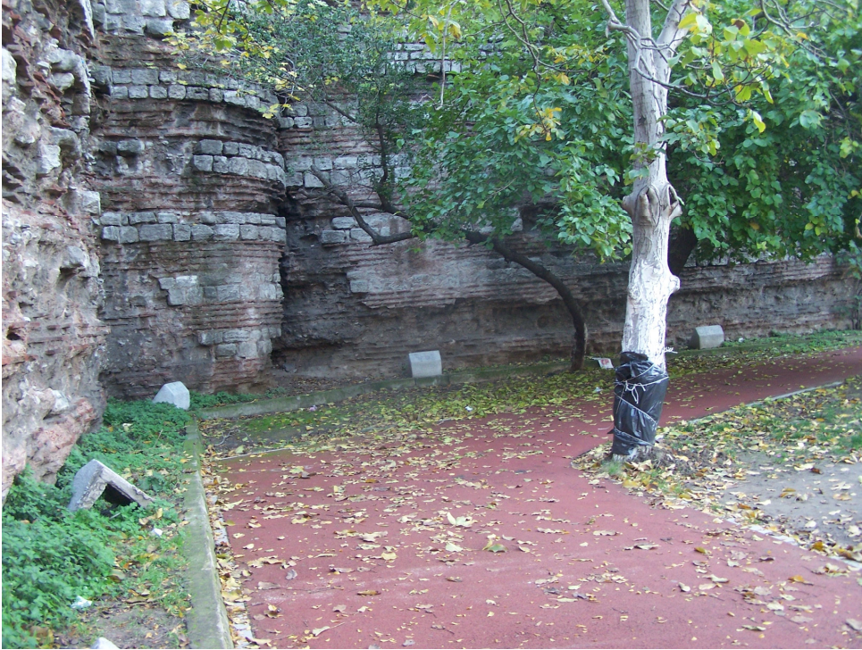
Şekil 4.52 Güney ve doğu duvarının birleştiği köşedeki destek duvarı (2007)
