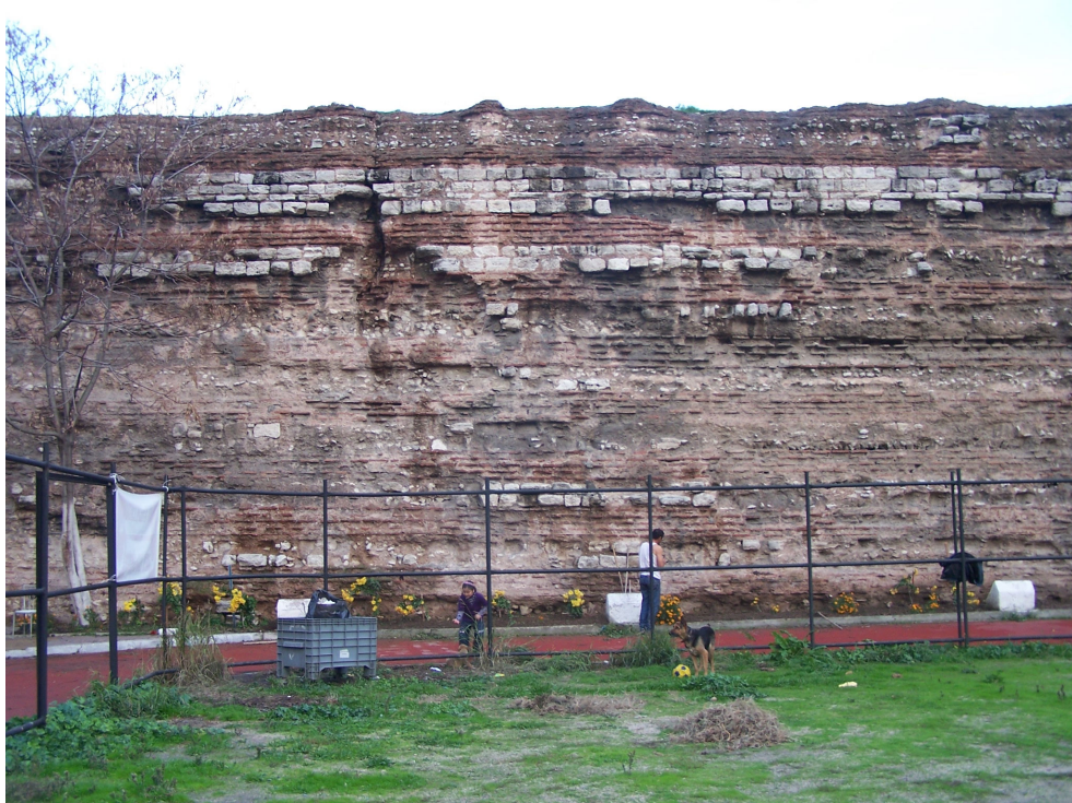
Şekil 5.9 Doğu duvarının iç cephesinde 5-45 cm arasında değişen yüzey kayıpları (2007)
