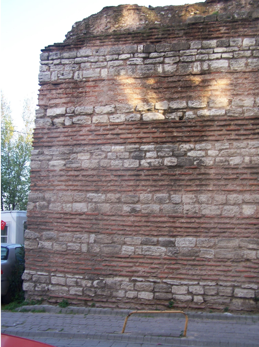
Şekil 4.43 Kuzey duvarının dış cephesindeki taş ve tuđla almasıık örgü (2007)
