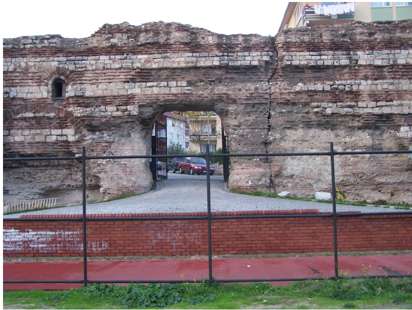
Şekil 4.40 Kuzey duvarının iç cephesinin önünde bulunan rampa (2007)
