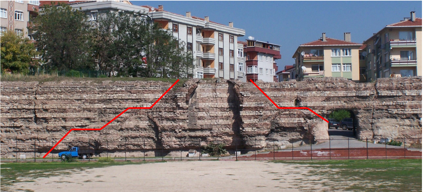
Şekil 4.37 Kuzey duvarı iç cephesinin önündeki merdivene ait kalıntılar (2007)
