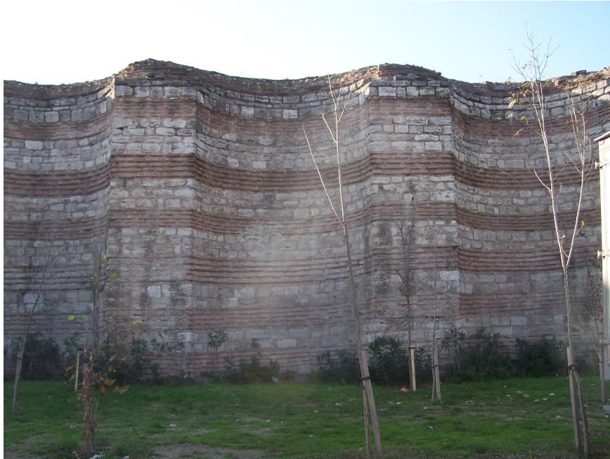
Şekil 4.58 Doğu duvarının dış cephesindeki 4.20 m açıklığındaki nişlerden 7. niş (2007)
