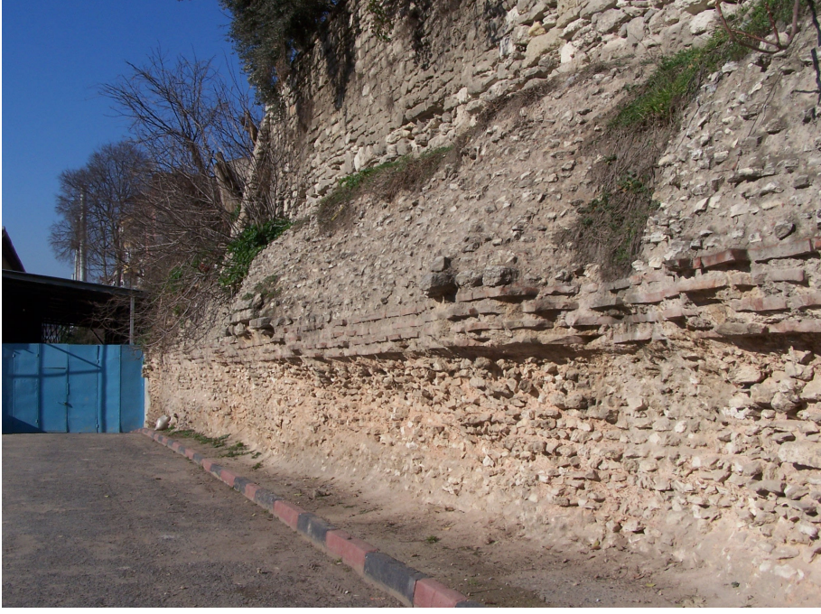
Şekil 3.9 Aetius Sarnıcı'nın almasıık duvar örgüsü (2007)
