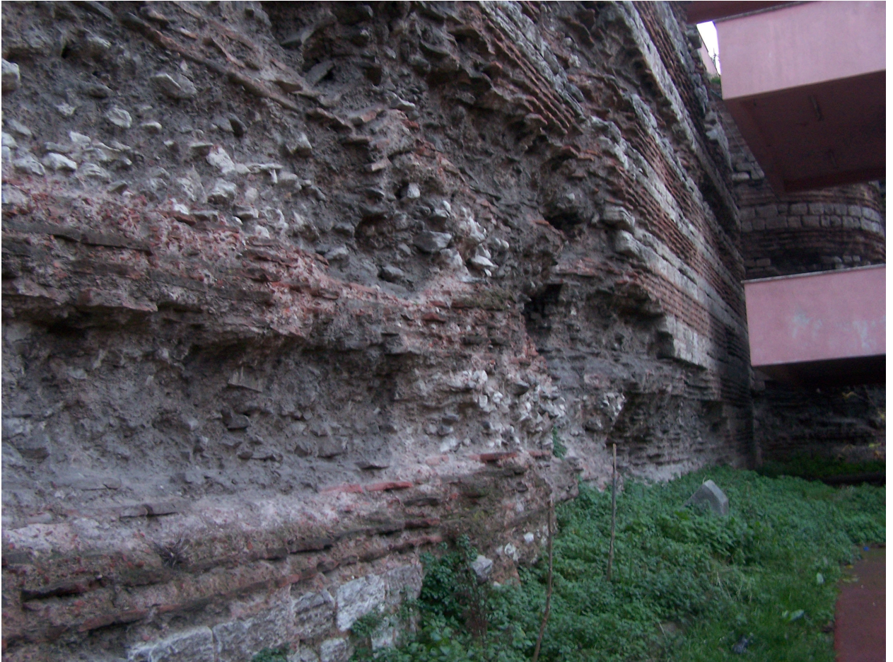
Şekil 4.82 Güney duvarının iç cephesindeki 1. ayağın kalıntıları (2007)
