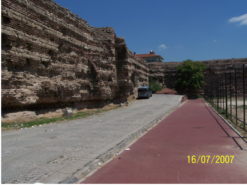
Şekil 4.20 Kuzey duvarının iç yüzündeki tuğla kemerli kargir ayak kalıntıları (2007)
