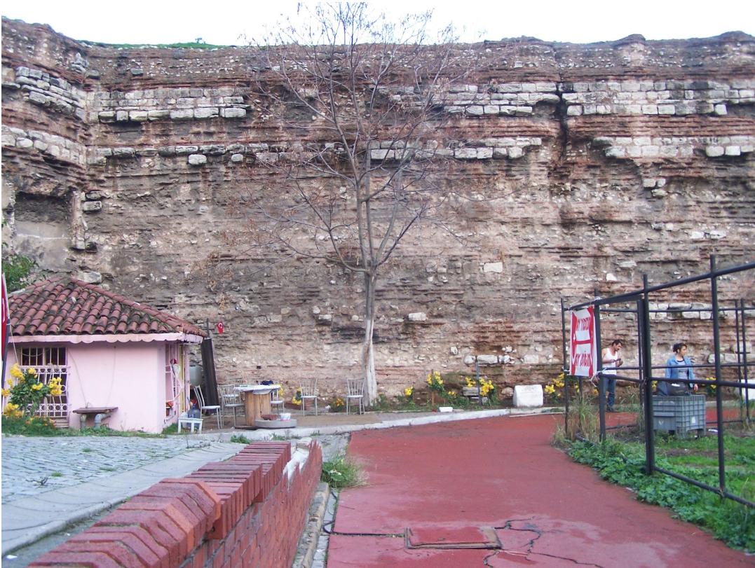
Şekil 4.55 Doğu duvarının iç cephesinin kuzey köşesindeki taş ve tuğla sıraları (2007)
