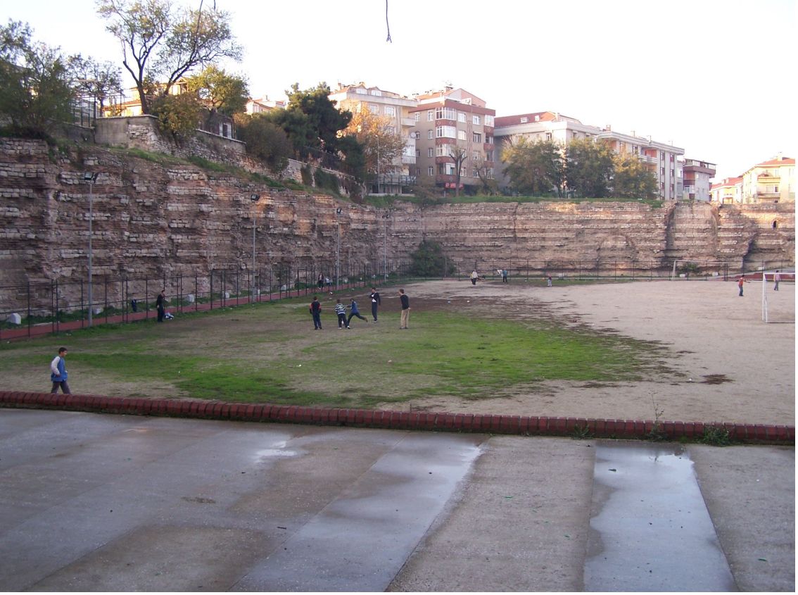
Şekil 5.26 Batı duvarının dayandığı zemin üzerinde bulunan yapılar (2007)
