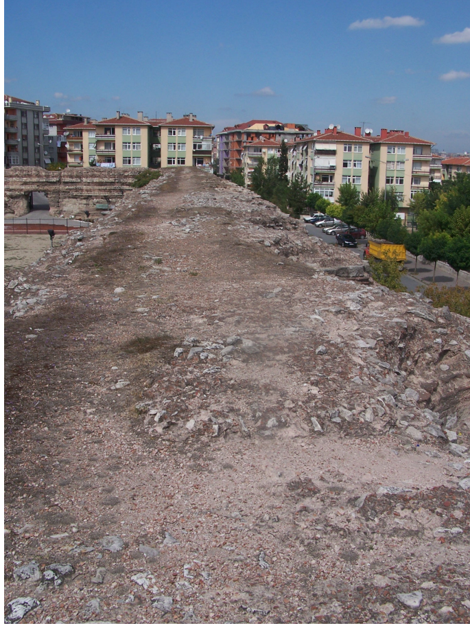
Şekil 4.16 Sarıncın 7.00 m kalınlığındaki doğu duvarından genel bir görünüş (2007)
