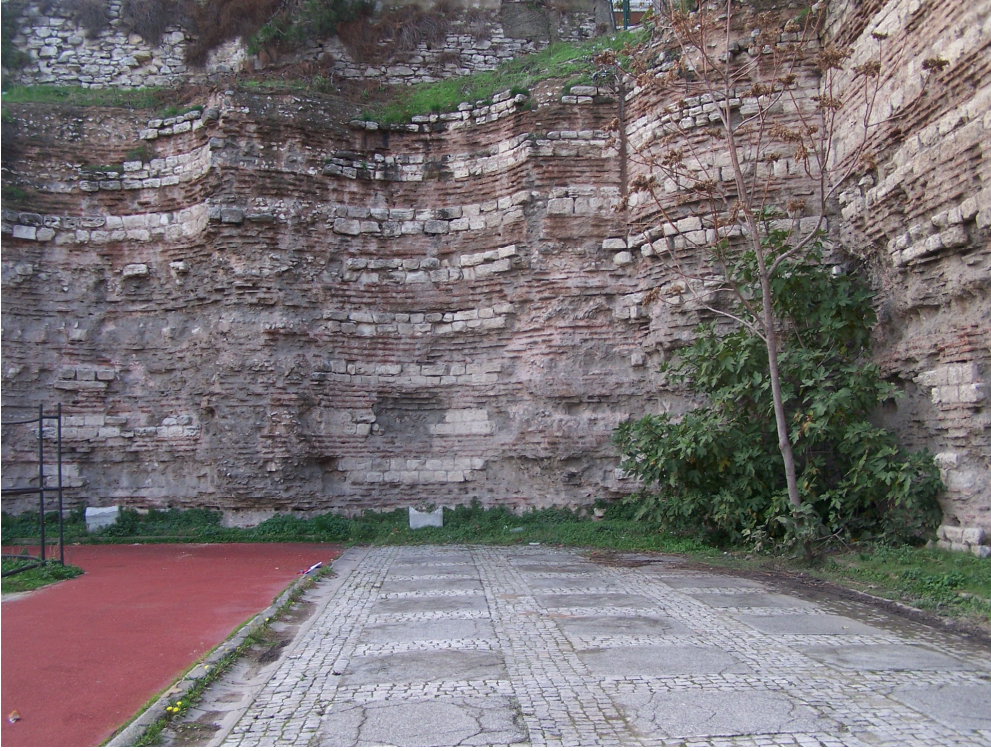
Şekil 4.108 Batı duvarının iç cephesindeki taş ve tuğla hatıl sıraları (2007)
