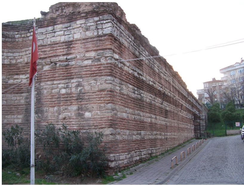
Şekil 4.29 Kuzey duvarının dış cephesinin genel görünüşü (2007)
