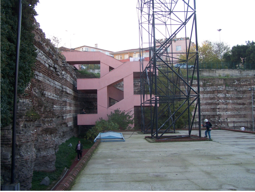
Şekil 5.24 Sarnıcın güney batı köşesinde bulunan betonarme merdiven (2007)
