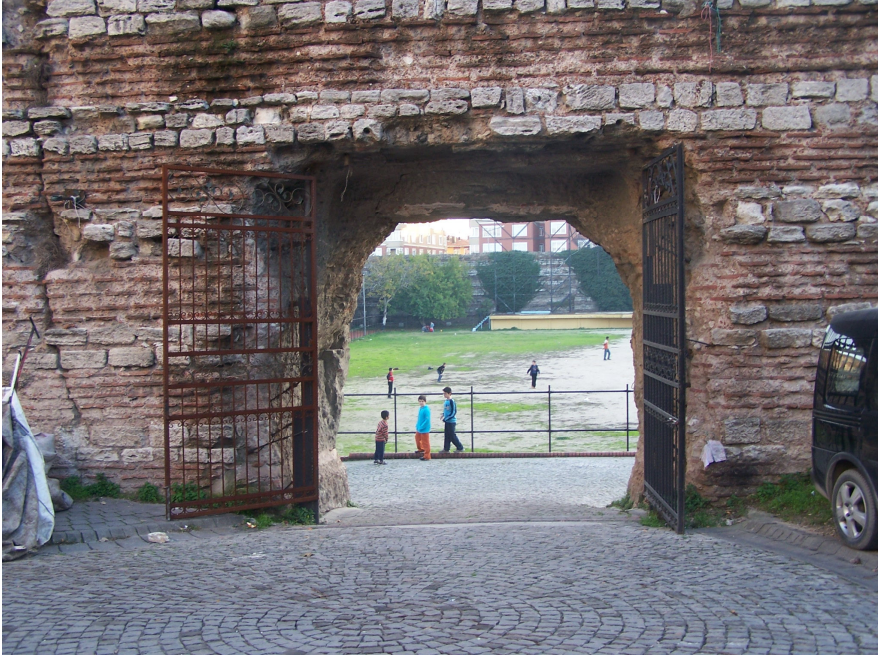
Şekil 4.39 Kuzey duvarında sonradan açılmış kapı boşluğu (2007)
