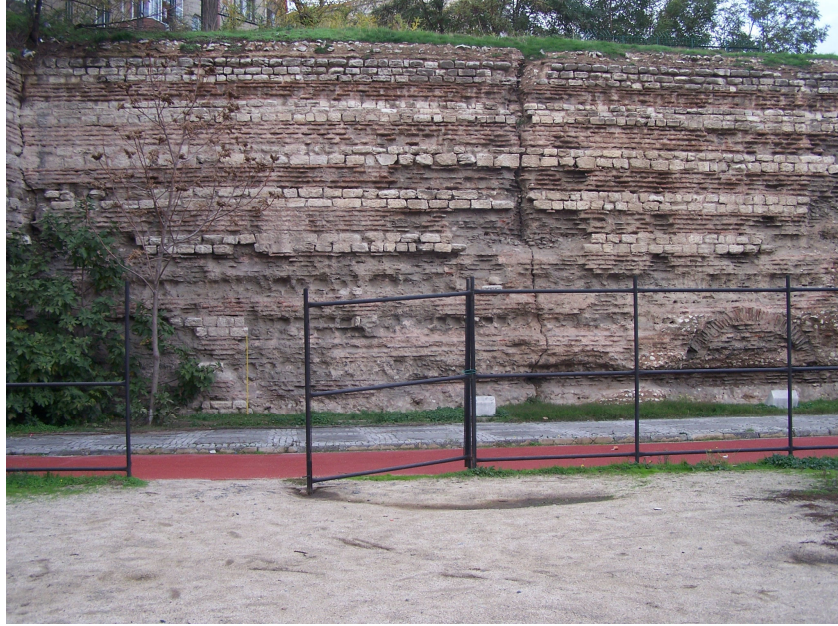
Şekil 4.41 Kuzey duvarının iç cephesindeki taş ve tuğla dizileri (2007)
