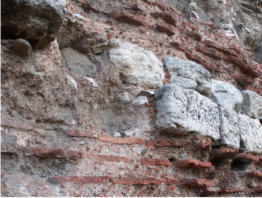
Şekil 4.115 Taş sıraları ve tuğla hatıllar arasındaki horasan harcı (2007)
