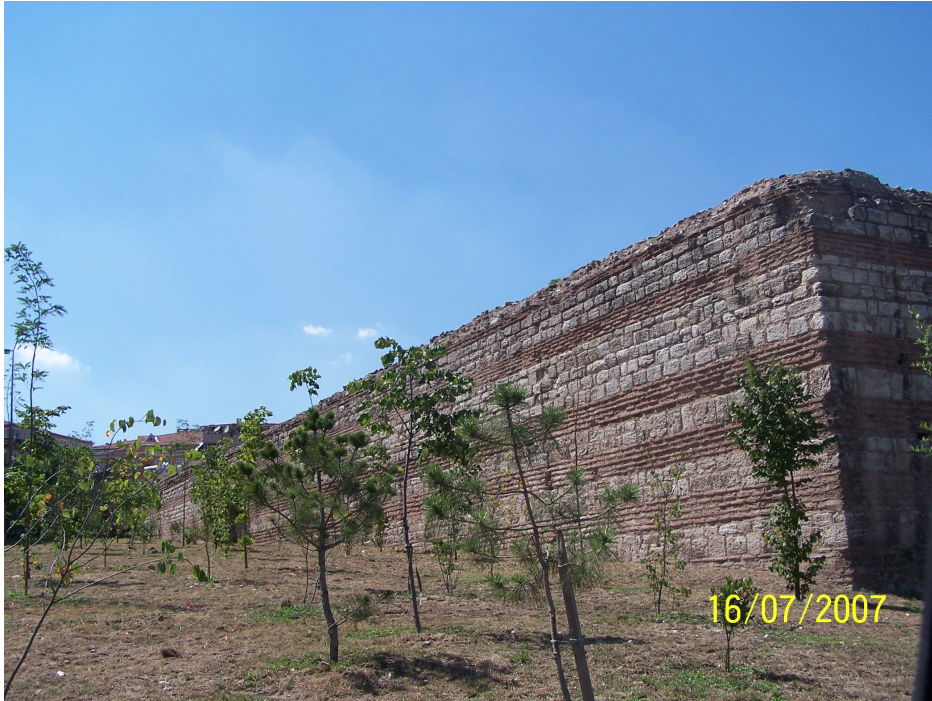
Şekil 4.81 Güney duvarının dış cephesinin genel görünüşü (2007)
