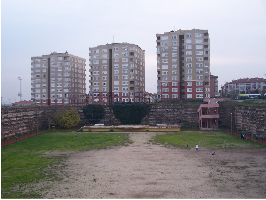
Şekil 4.80 Güney duvarının iç cephesinin genel görünüşü (2007)
