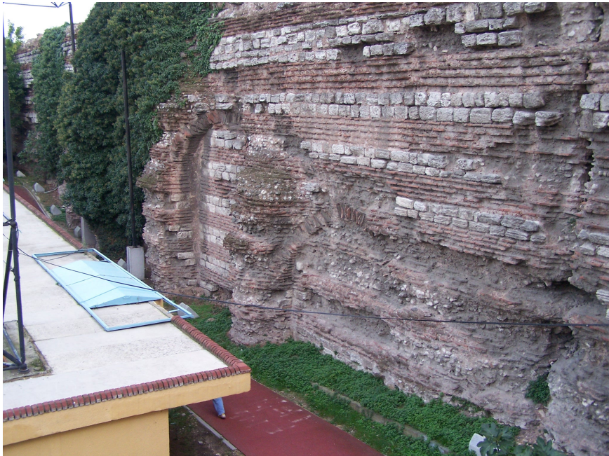
Şekil 4.21 Güney duvarının iç yüzündeki tuğla kemerli kargir ayak kalıntıları (2007)
