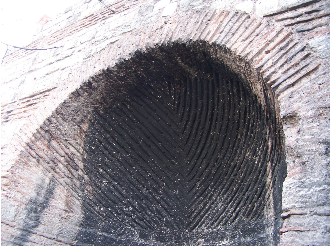
Şekil 4.120 Doğu cephesinde 21. nişindeki yarım kubbede kullanılan 50x50x4,5 cm tuğlaları (2007)
