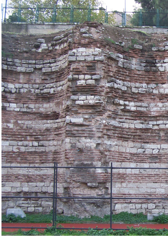
Şekil 4.106 Kalınlığı 1.70 m olan niş duvarlarından kuzey köşeden itibaren 15.-16. niş arasındaki duvar (2007)
