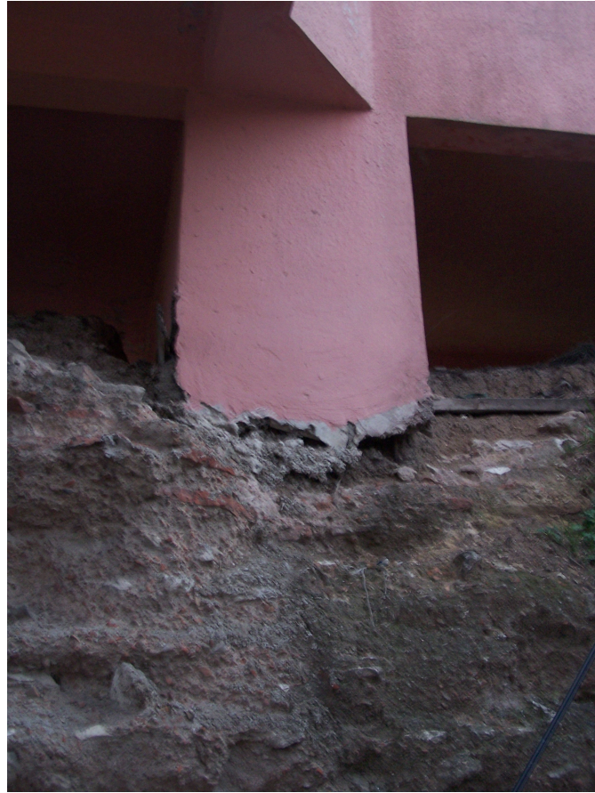
Şekil 5.25 Güney duvarının üzerine oturtulan betonarme merdivenin ayakları (2007)
