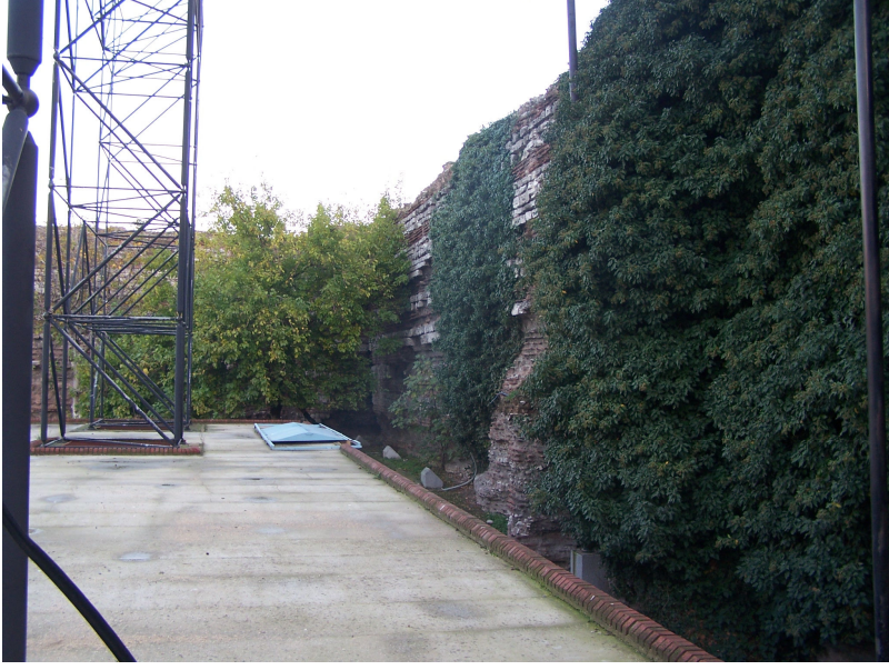
Şekil 4.85 Güney duvarının iç cephesindeki 3.-4. ayaklar arasındaki kemerin kalıntıları (2007)
