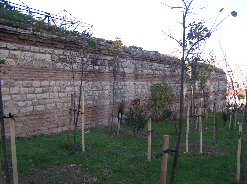
Şekil 4.13 Sarnıçın güney duvarının dıştan görünüşü (2007)
