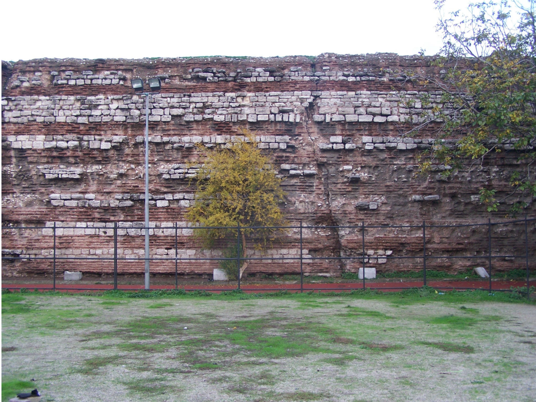
Şekil 4.57 Doğu duvarının iç cephesinin güney köşesindeki taş ve tuğla sıraları (2007)
