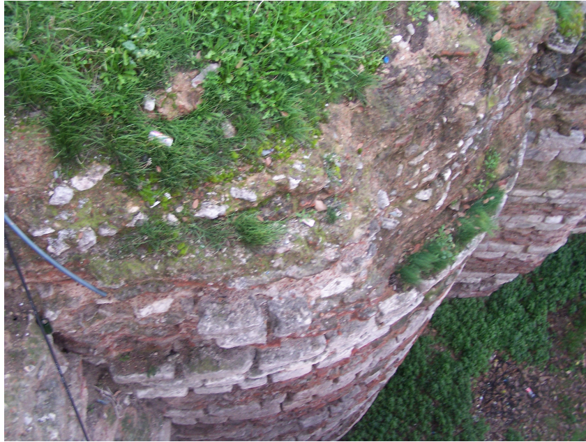
Şekil 4.19 Sarnıcın iç köşelerindeki çeyrek daire planlı destek duvarının üstten görünüşü (2007)
