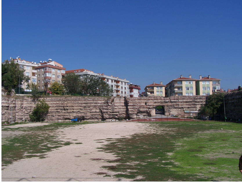
Şekil 4.28 Kuzey duvarının iç cephesinin genel görünüşü (2007)
