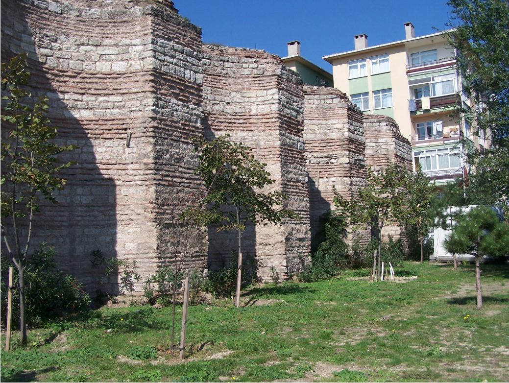
Şekil 4.14 Sarnıçın doğu duvarının dıştan görünüşü (2007)
