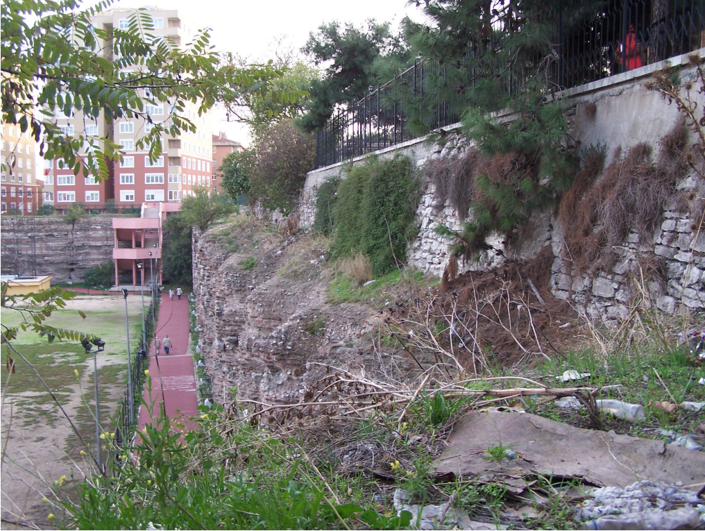
Şekil 4.17 Sarıncın dıştan toprak zeminle kapalı olan batı duvarı (2007)
