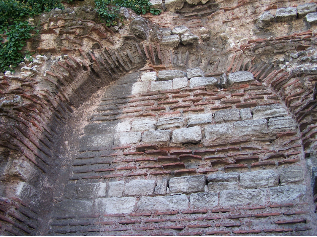
Şekil 4.124 Güney duvarının iç cephesinde yer alan 2. kemerin köşesinde görülen sıva kalıntısı (2007)
