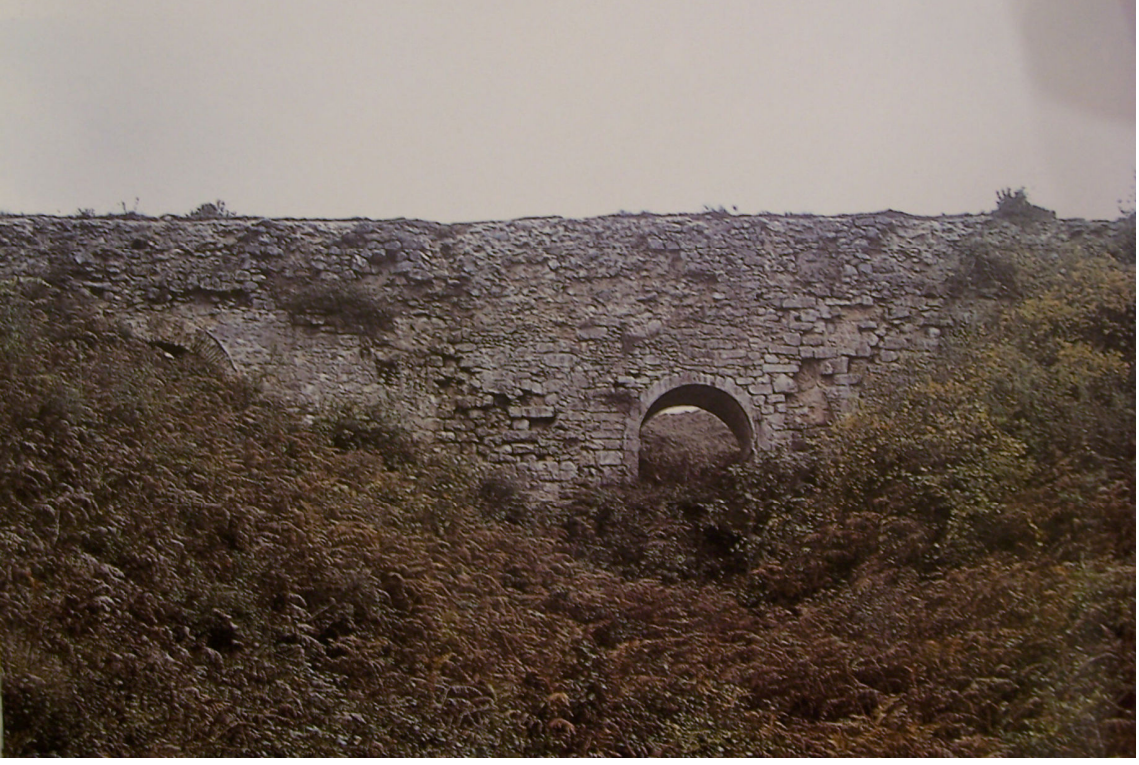
Şekil 2.2 Karakemer'in güney cephesi (Çeçen, 1999, s.32).
