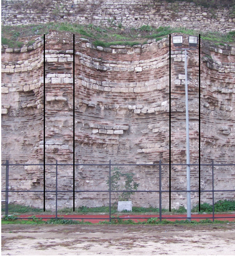
Şekil 4.100 Batı duvarının iç cephesindeki 7. niş (2007)
