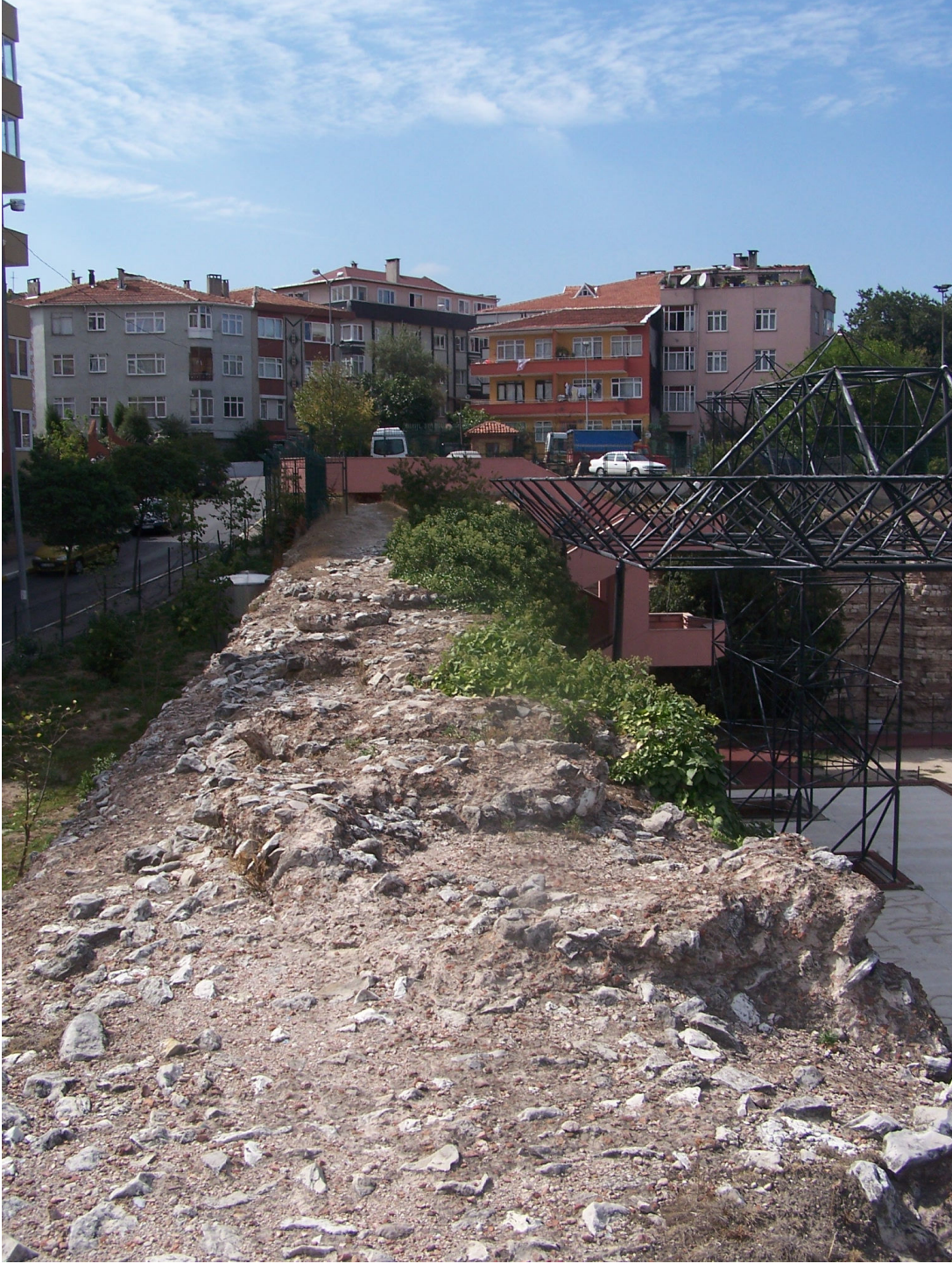
Şekil 4.15 Sarnıcın 4.10 m kalınlığındaki güney duvarından genel bir görünüş (2007)
