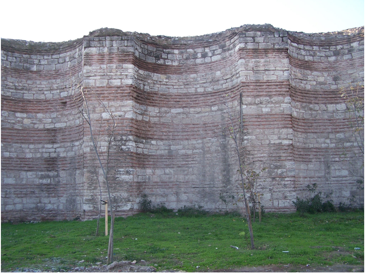
Şekil 4.63 Doğu duvarının dış cephesindeki 4.45 m açıklığındaki nişlerden 11. niş (2007)
