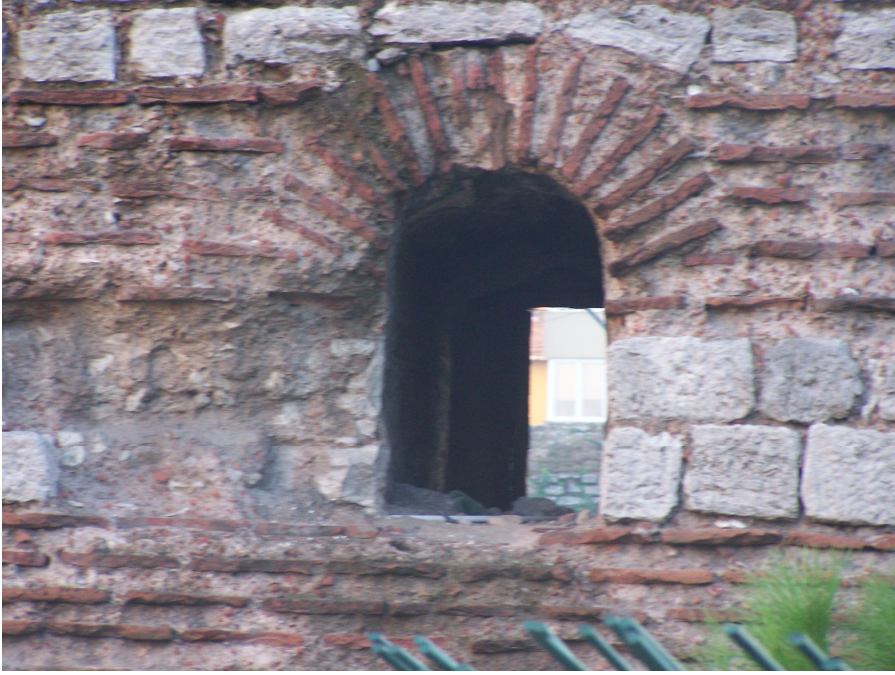
Şekil 4.22 Kuzey duvarındaki tuğla kemerli pencerenin dıştan görünüşü (2007)
