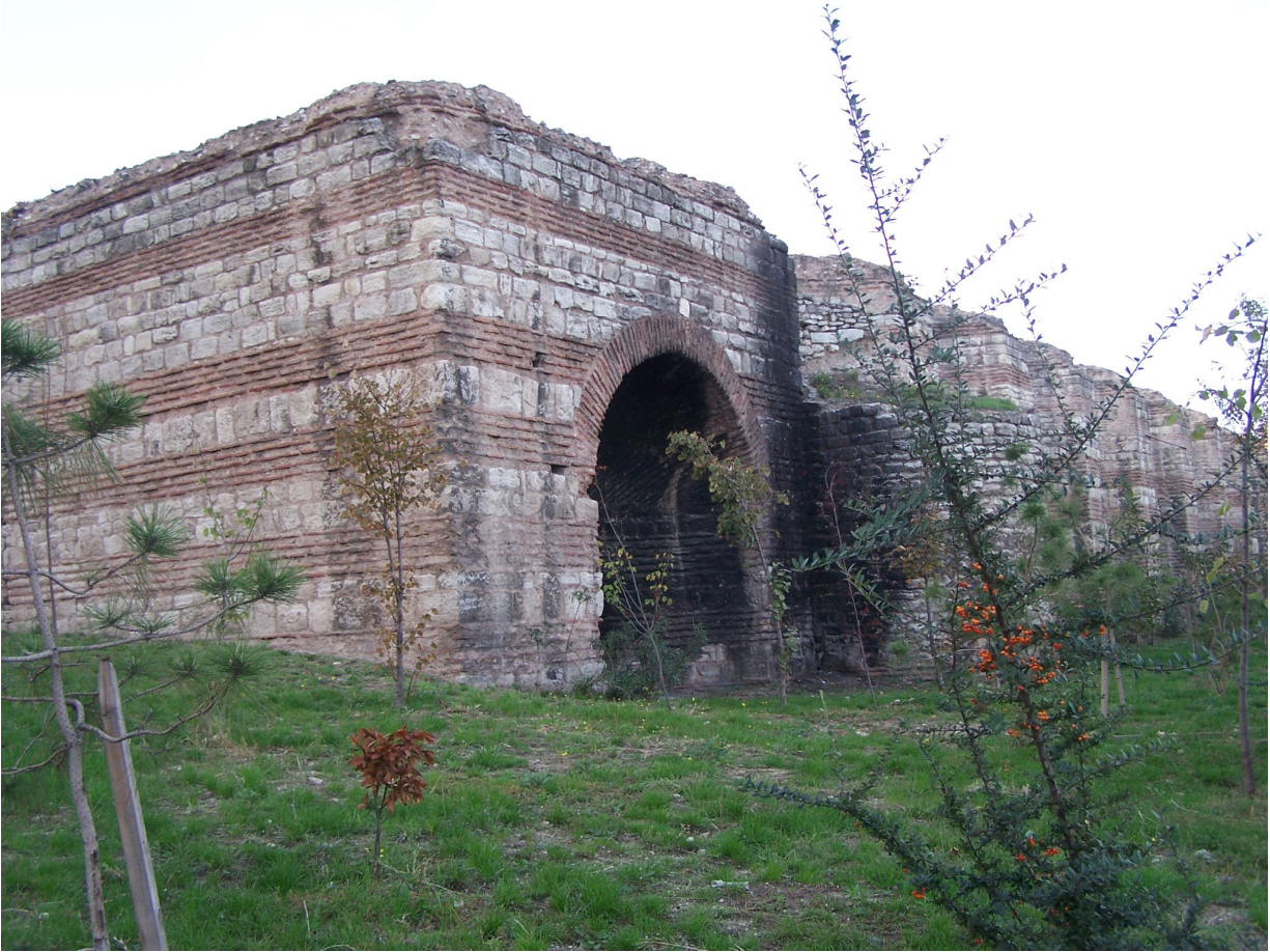
Şekil 4.25 Doğu duvarının dış cephesindeki yarım daire planlı 21. niş ve 20. nişte yer alan merdiven yapısı (2007)
