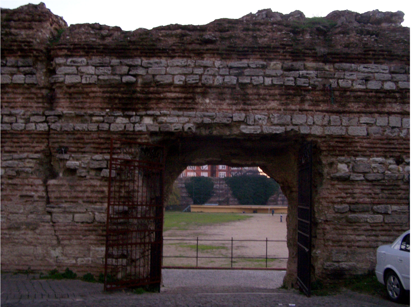
Şekil 4.44 Kuzey duvarının dış cephesindeki 2'li ve 3'lü taş sıraları (2007)
