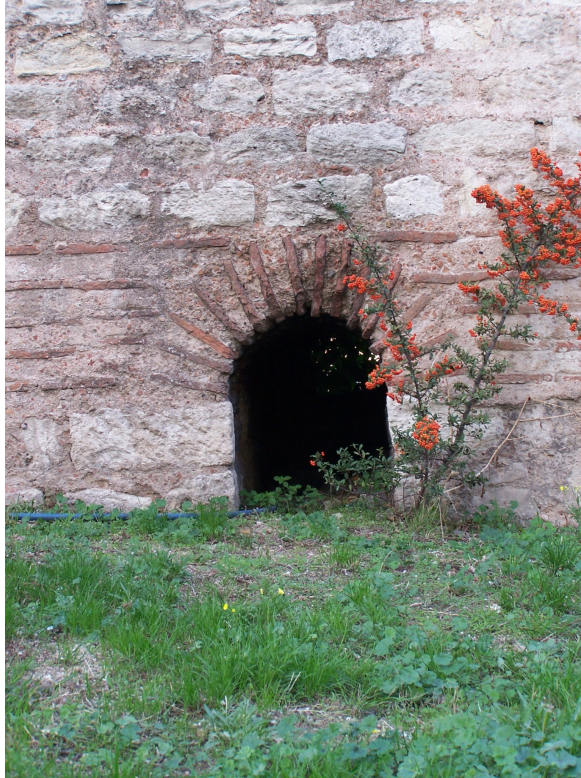
Şekil 4.23 Güney duvarındaki tuğla kemerli pencerenin dıştan görünüşü (2007)
