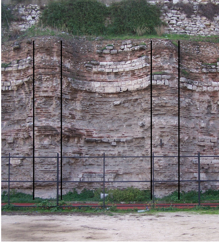
Şekil 4.99 Batı duvarının iç cephesindeki 3. niş (2007)
