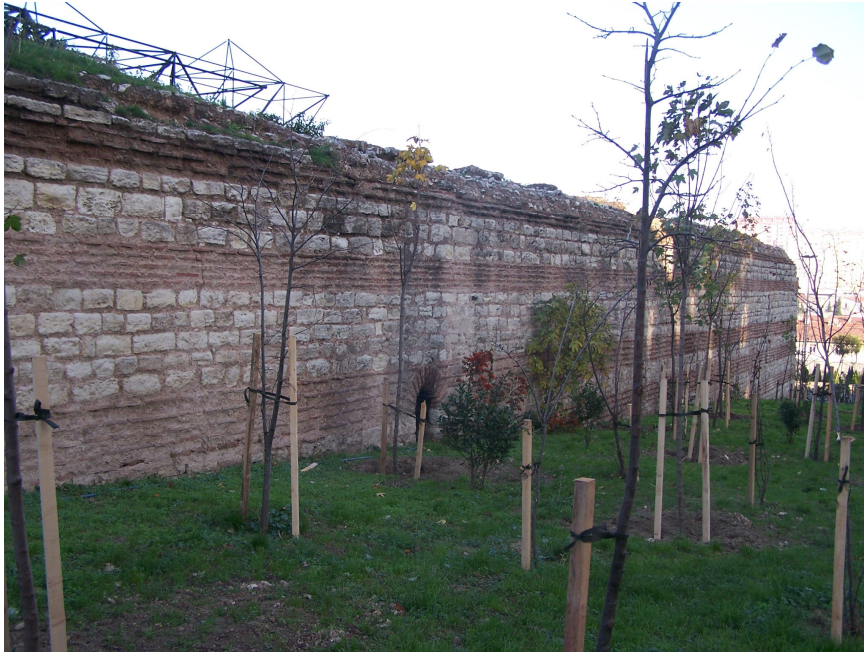
Şekil 4.114 Güney duvarının dış cephesi (2007)
