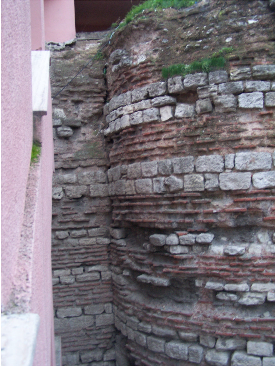
Şekil 5.12 Güney ve batı duvarlarının birleştiği iç köşedeki destek duvarında tespit edilen derz boşalmalarından kaynaklanan ayrılma (2007)
