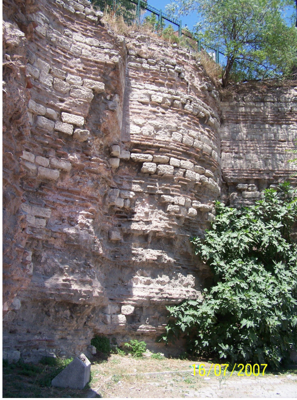
Şekil 4.18 Sarnıcın iç köşelerindeki çeyrek daire planlı destek duvarı (2007)
