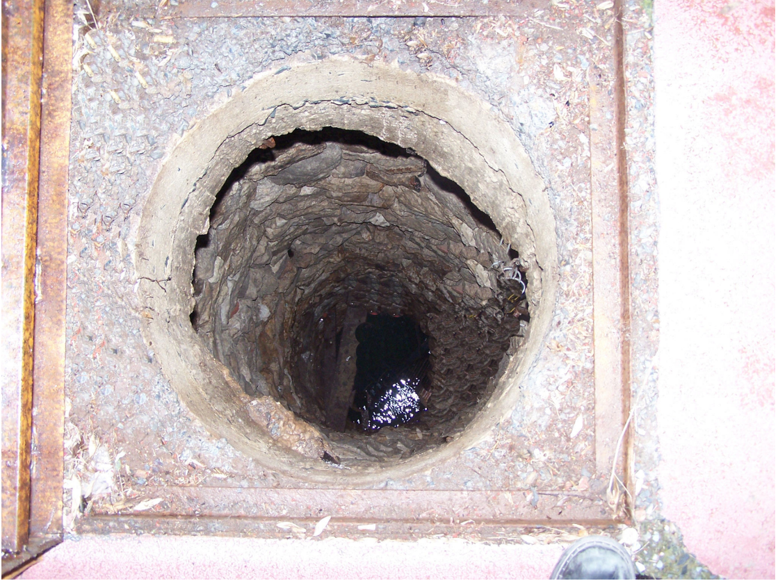
Şekil 4.27 Sarnıç içindeki sonradan açılan güneydoğu köşedeki su kuyusu (2007)
