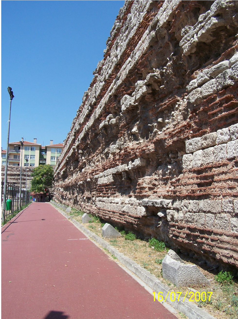
Şekil 4.50 Dođu duvarının iç cephesinden genel bir görünüş (2007)
