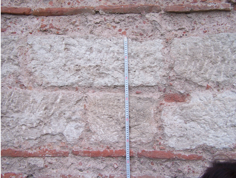
Şekil 4.122 Almaşık duvar örgüsünde farklı taş boyutları ve yatay derz kalınlığı (2007)
