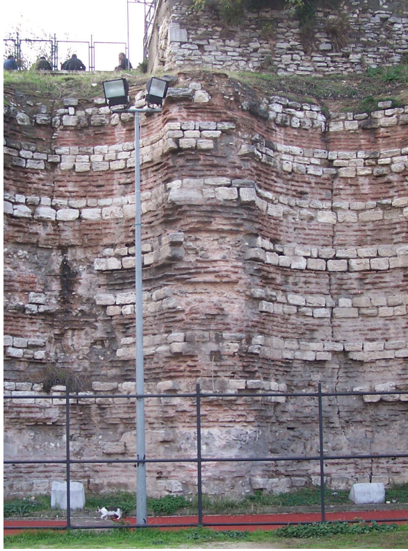
Şekil 4.107 Kalınlığı 1.60 m olan niş duvarlarından kuzey köşeden itibaren 10.-11. niş arasındaki duvar (2007)
