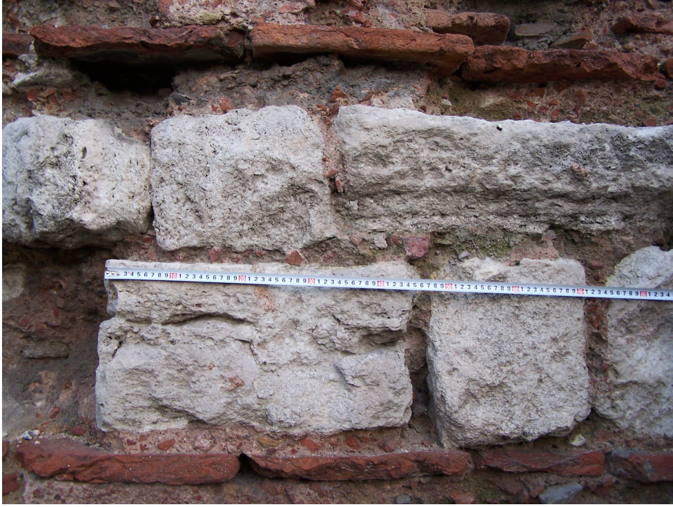
Şekil 4.121 Almaşık duvar örgüsünde taş-taş arasındaki yatay derz kalınlığı (2007)
