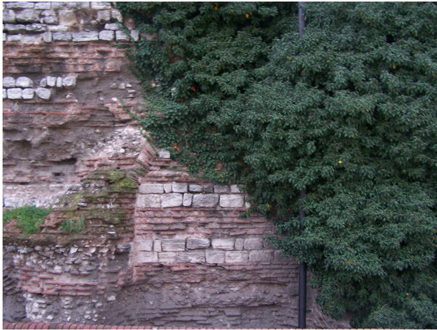
Şekil 4.86 Güney duvarının iç cephesindeki 4.-5. ayaklar arasındaki kemerin kalıntıları (2007)
