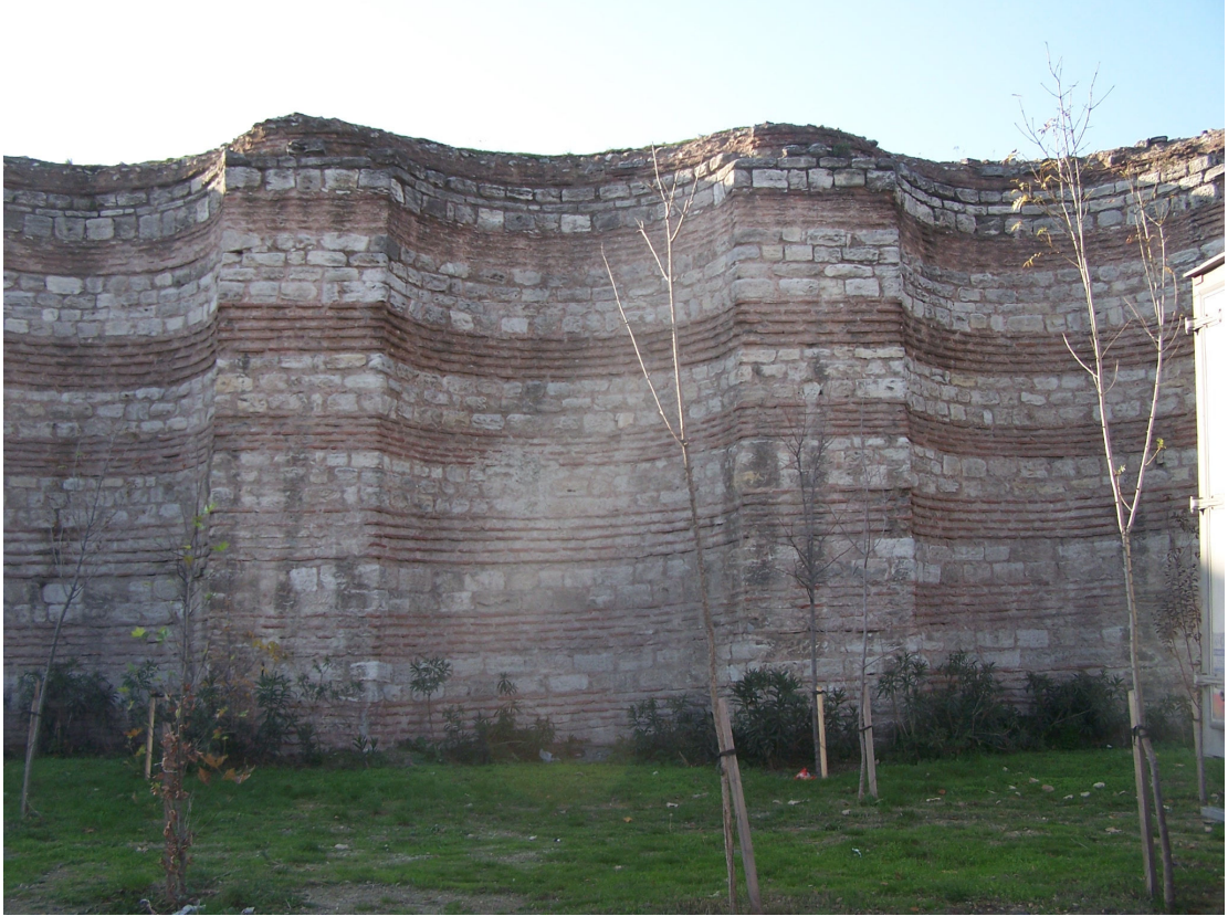
Şekil 4.60 Doğu duvarının dış cephesindeki 4.30 m açıklığındaki nişlerden 8. niş (2007)
