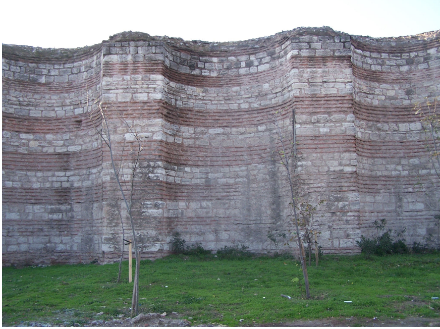
Şekil 4.113 Dođu duvarının dış cephesi (2007)
