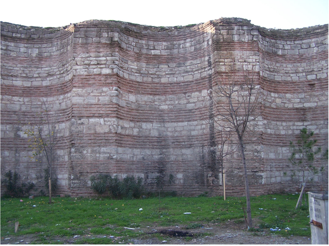
Şekil 4.61 Doğu duvarının dış cephesindeki 4.35 m açıklığındaki nişlerden 13. niş (2007)
