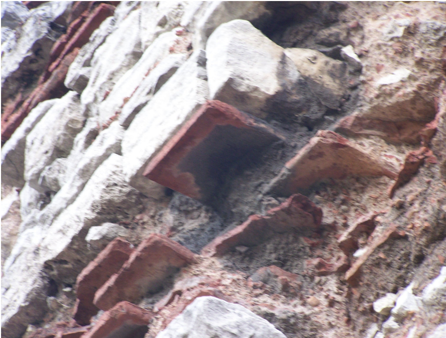
Şekil 4.116 Tuğla hatılda duvar kalınlığına uygulanan derz şaşırtması (2007)
