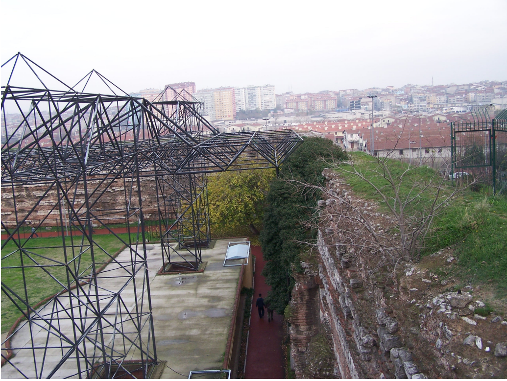
Şekil 5.5 Güney duvarının iç cephesinde ve duvar yüzeyindeki bitki oluşumları (2007)
