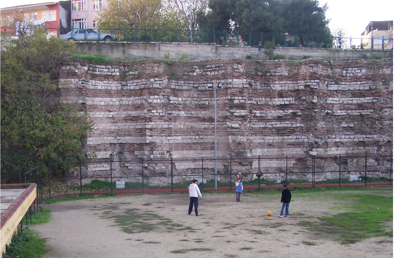
Şekil 4.98 Batı duvarının nişli iç cephesi (2007)
