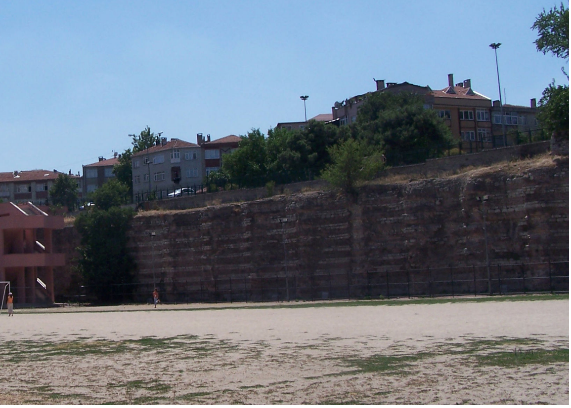
Şekil 4.96 Batı duvarının üzerine yapılmış olan otoparkın duvarı (2007)
