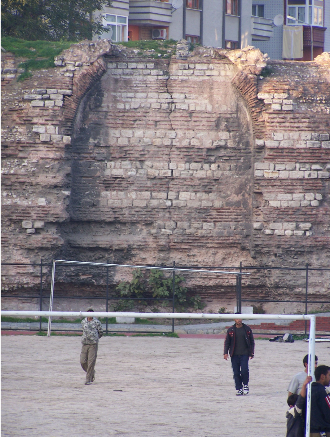
Şekil 4.34 Kuzey duvarının iç cephesindeki 3.-4. ayaklar arasındaki kemerin kalıntısı (2007)
