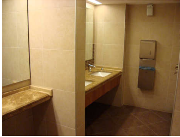
Şekil 6.96 Lobi katında bulunan wc
