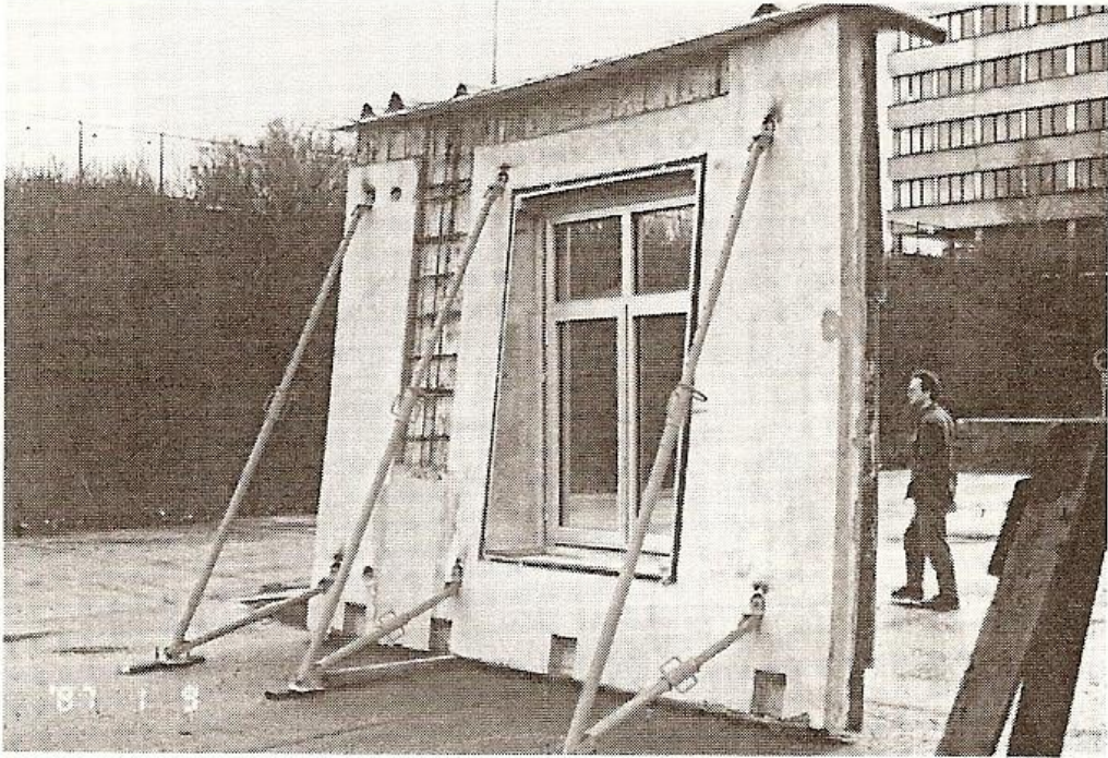
Şekil 5.15 Fred Kulesi Prekast Pencereleri Montaja Hazır Hali
