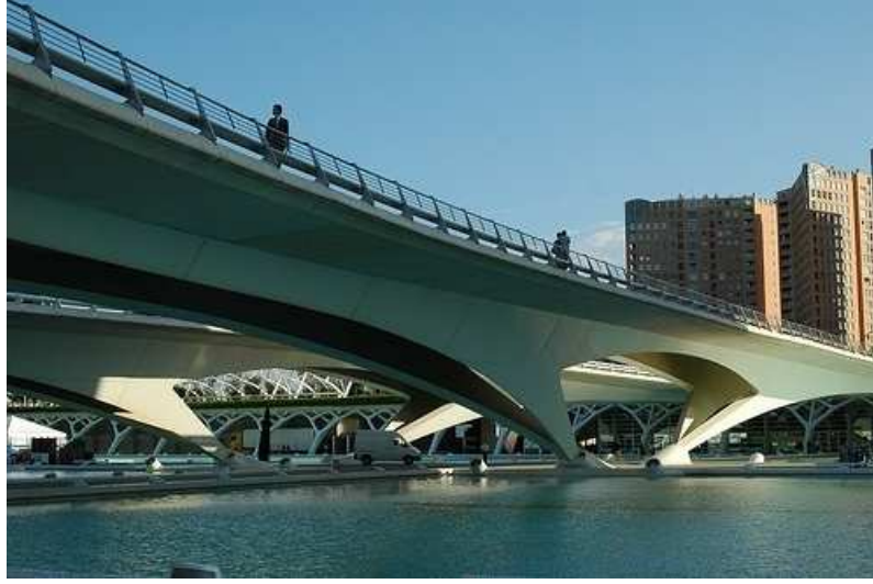
Şekil 3.83 Puente de Monteolivete, Valencia
