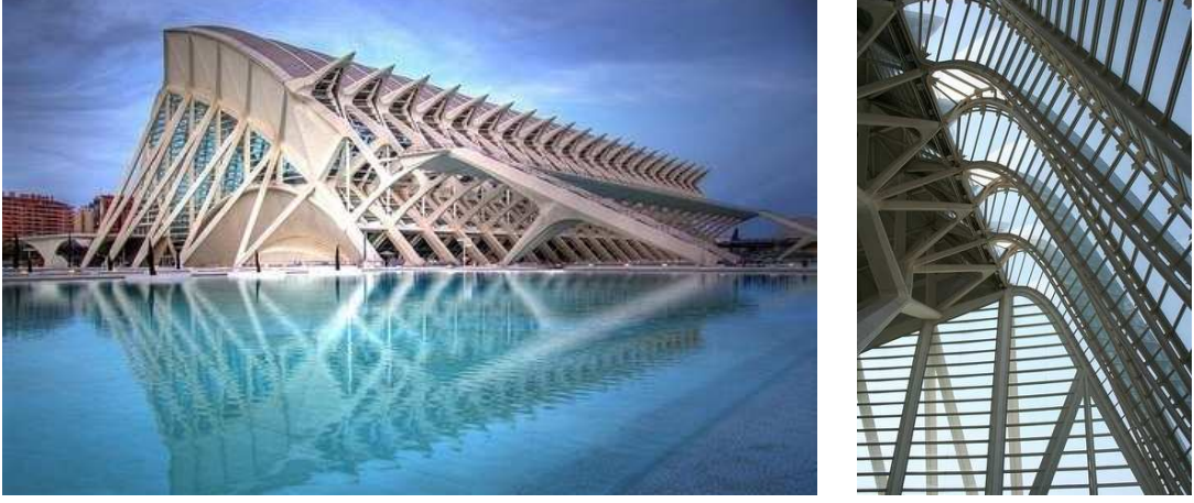
Şekil 3.81 Bilim Müzesi Görünüm ve İç Mekan
