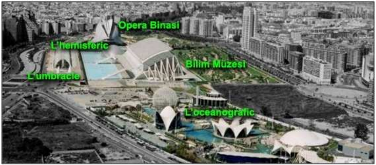
Şekil 3.78 Sanat ve Bilim Kompleksi Genel Görünüm
