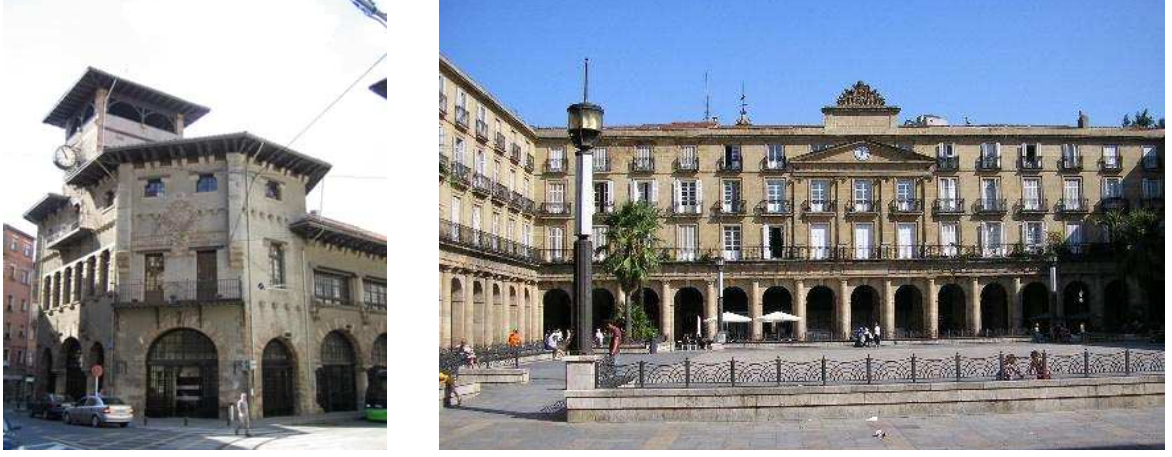
Şekil 3.12 Axturi İstasyonu ve Plaza Nueva [19]
