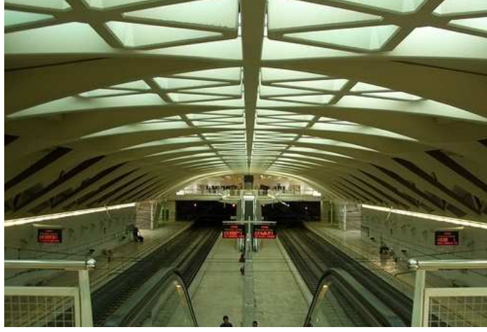
Şekil 3.71 Alameda Metro İstasyonu ve Alameda Köprüsü [54]
