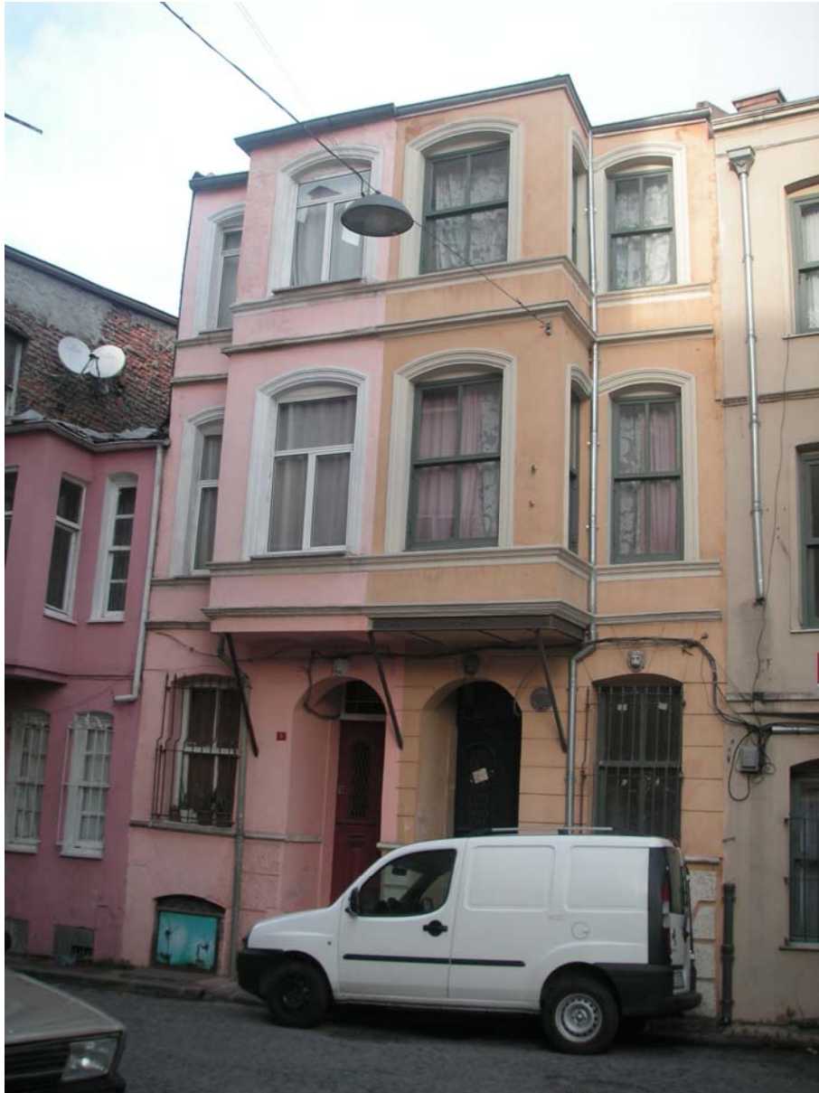
Şekil 4.1 Fener Yıldırım caddesi ikiz ev örneği, 2306 ada 54-55 parsel Yıldırım Caddesi
