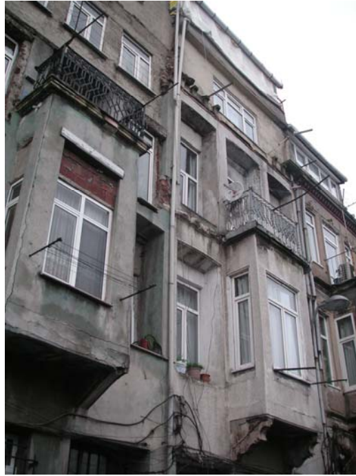
Şekil 6.55 Çalışma alanındaki binalara yapılan ek katlar 2308 ada
