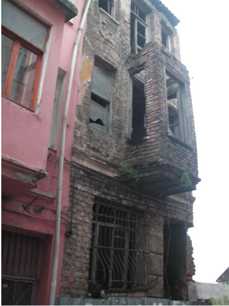
Şekil 3.22 Fener’de yığma tuğla duvar ve ahşap kirişleme örneği, Yıldırım Caddesi
