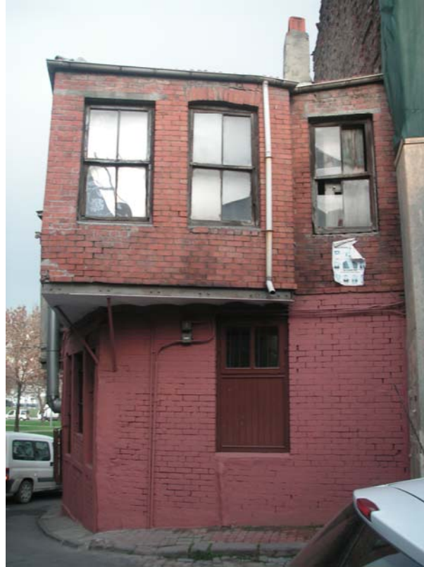
Şekil 3.25 Fener’de volta döşemeli yapı örneği, Yıldırım Caddesi
