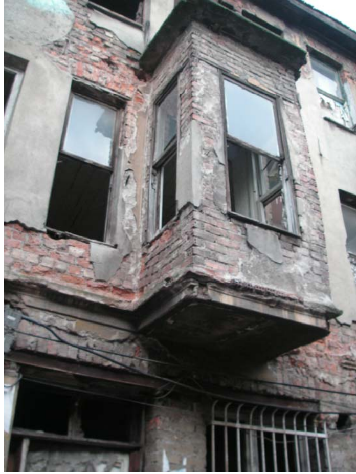
Şekil 3.21 Balat’da yığma tuğla duvar ve ahşap kirişleme örneği, Yıldırım Caddesi
