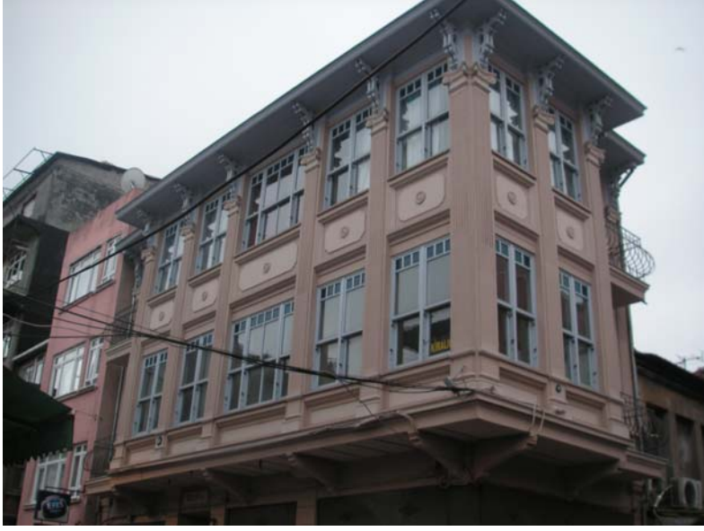
Şekil 4.11 Hızır Çavuş Köprüsü sokak Art Nouveau + Neoklasik cephe örneği, 2344 ada 15 parsel
