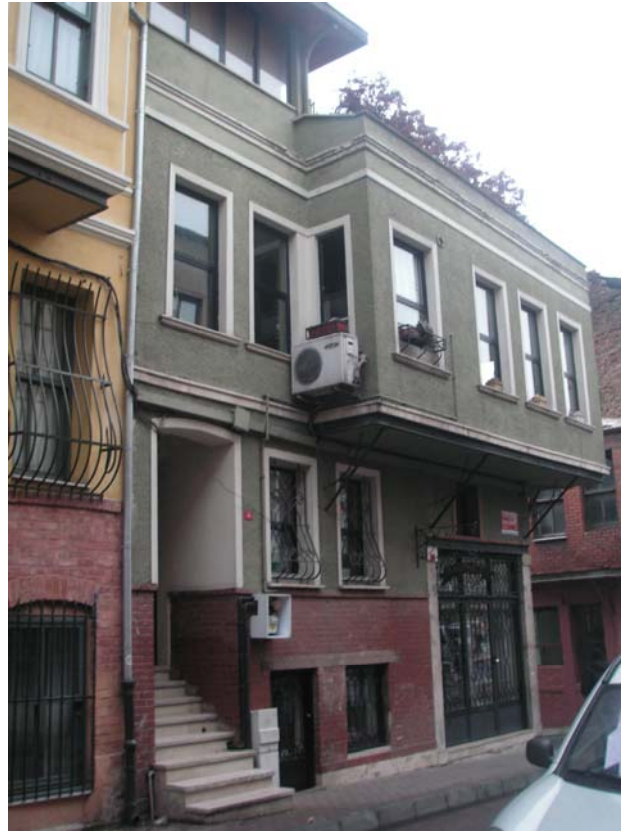
Şekil 4.8 Hızır Çavuş Köprüsü sokak neoklasik cephe örneği, 2859 ada 39 parsel
