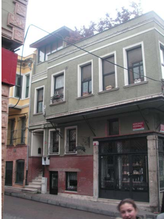
Şekil 6.44 Köşede bulunan cumba örneği 2859 ada
