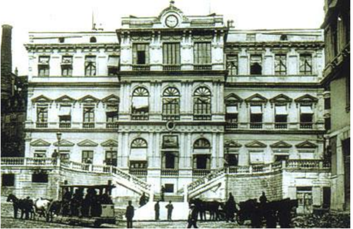
Şekil 4.18 Altıncı Beyoğlu binasının eski görünümü. Eklentisiz hali, [15]
