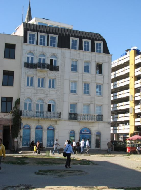
Çatı eklentisine ait görünüş, 2009
