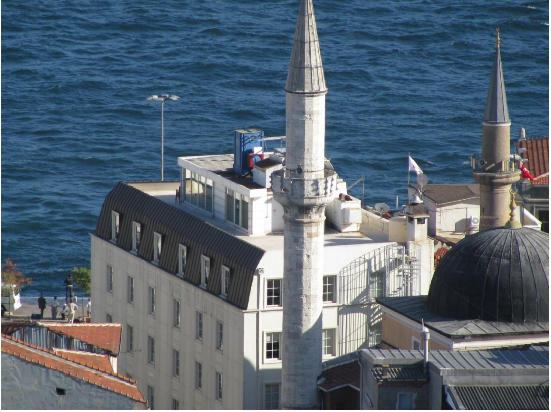
Çatı eklentisine ait görünüş, 2009
