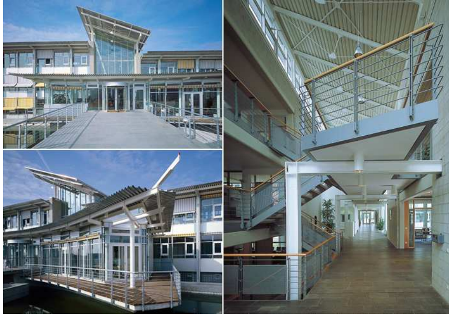
Şekil 6.8 Edding; tasarımında dış cephe ile iç mekan uyumuyla dikkat çekmiştir. Sirkülasyon alanlarında merdiven ve galeri boşluklarını aydınlatan doğal ışık tasarımının başarısını göstermektedir.
