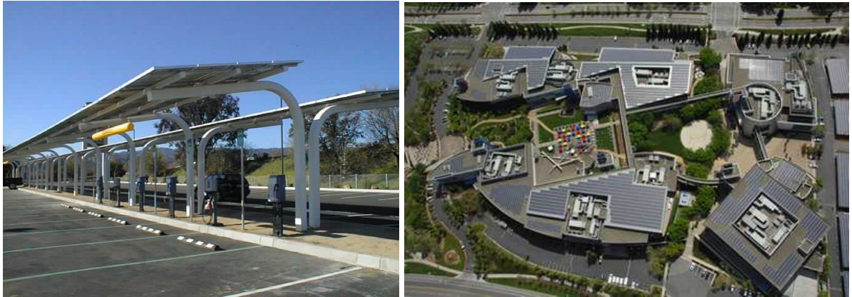
Şekil 6.51 Park yerlerinde gölge yaparak da işlev gören, ‘güneş ağacı’ olarak adlandırılan güneş panelleri ve vaziyet planından görünüşü[7]
