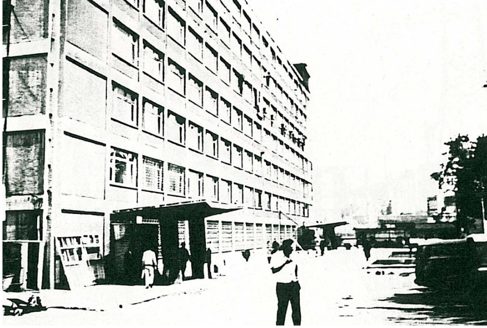
Şekil 10.11 Harika ve Kemali Söylemezoğlu'nun İETT Altın-tepe Tesis'i'nin hizmet binası cephesinden görünüşü (Alp, 1991)
