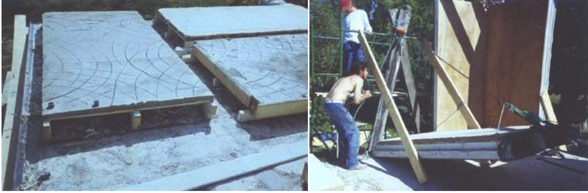
Şekil 3.102 Duvar Modülünün Hazırlanışı (Rosell, 2007)
