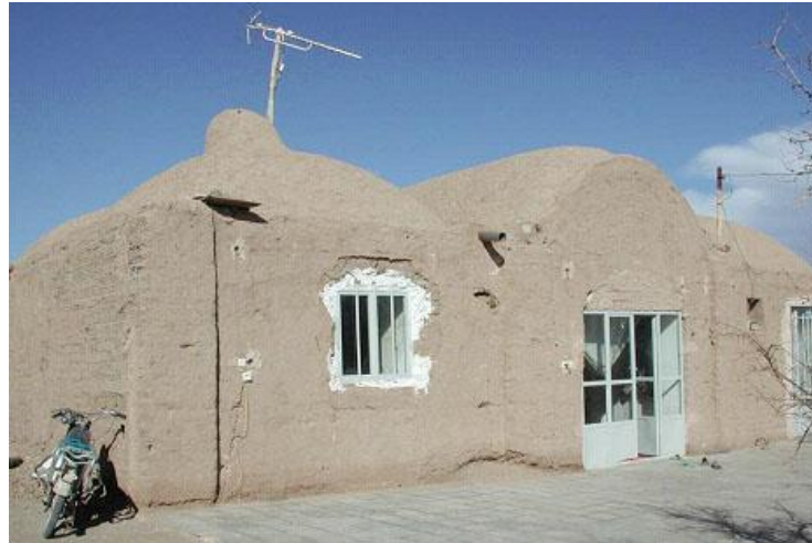
Şekil 3.79 İran'da Bir Kerpiç Ev Uygulaması [133]
