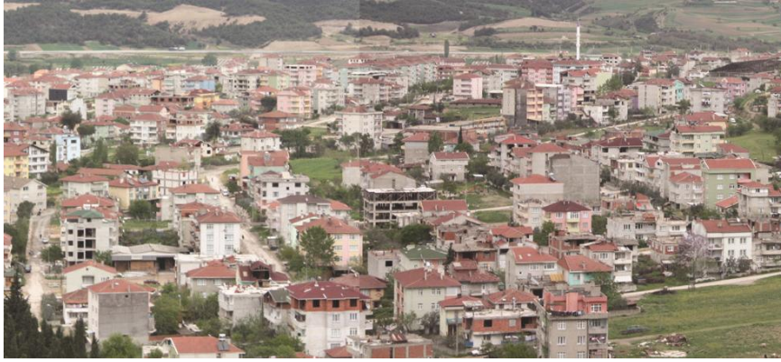
Şekil 5.17 Osmaneli 1950 Sonrası Gelişen Bölgelerin Görünüşü
