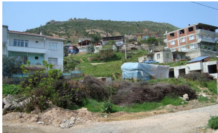
Şekil 5.32 Betonarme İmarsız Yapılan Yapılar
