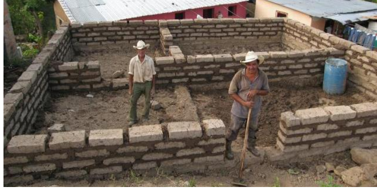
Şekil 3.77 Tuğla Kerpiçlerin Uygulaması [131]
