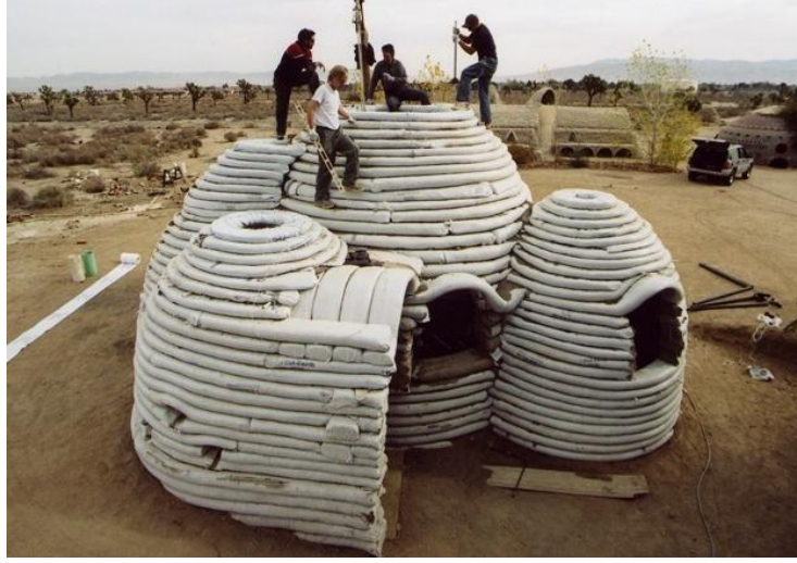
Şekil 3.92 Kum Torbaları ile Oluşturulan Strüktür [150]
