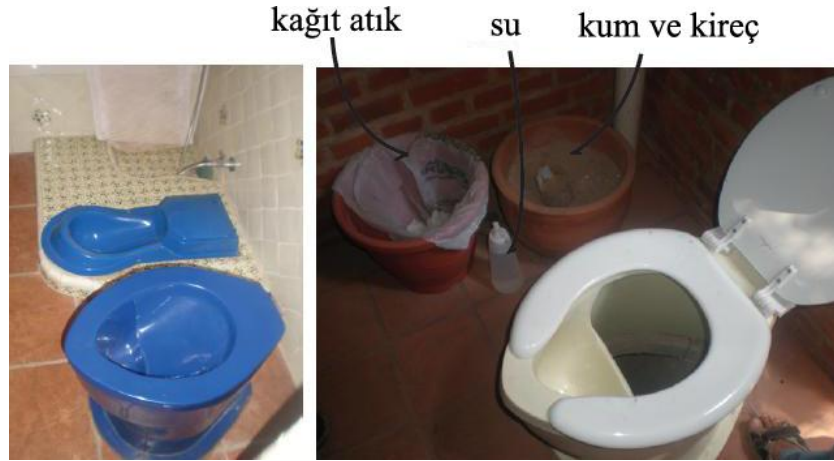
Şekil 3.108 Sistem İçin Gerekli Elemanlar (Bozza, 2009)
