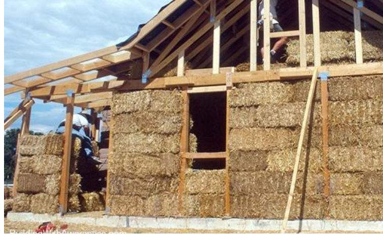
Şekil 3.69 Ahşap Konstrüksiyonla Birlikte Kullanımı [122]
