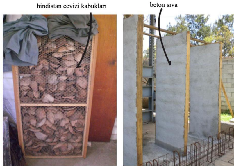
Şekil 3.105 Hindistan Cevizi Kabuğundan Hazırlanan Yalıtımlı Duvar (Bozza, 2009)
