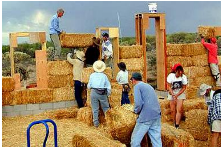
Şekil 3.70 Saman Balyalarının Yerleştirilmesi [123]
