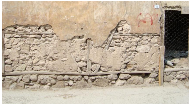
Şekil 5.16 Ahşap Karkas Arası Kerpiç Dolgu ve Üzeri Çamur Sıva
