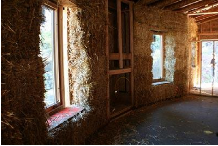
Şekil 3.72 İç Mekân Henüz Duvarları Sıvanmadan Önceki Durumu [125]
