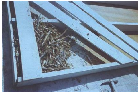
Şekil 3.100 Duvar Modüllerinin Hazırlanışı (Rosell, 2007)
