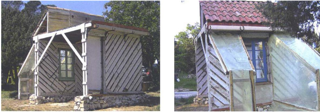
Şekil 3.99 Ahşap ve Samandan Oluşan Panel Duvarlar (Rosell, 2007)
