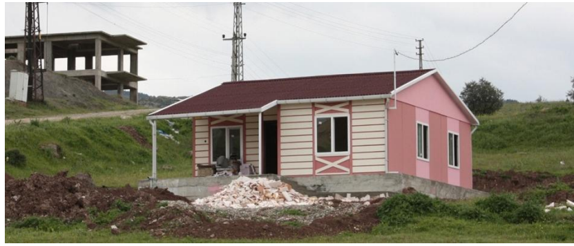
Şekil 5.19 Osmaniye’de Prefabrik Konut Uygulaması
