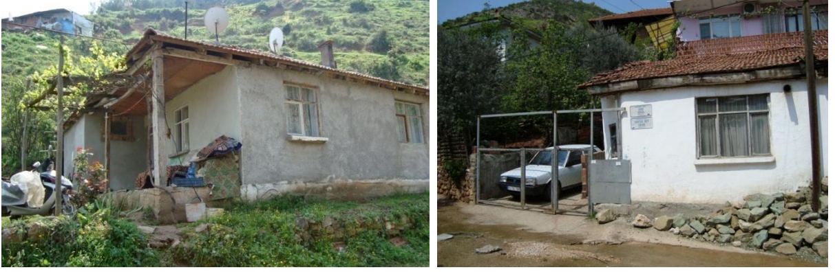
Şekil 5.33 Tamamlanmış Bir Kaçak Yapılar
