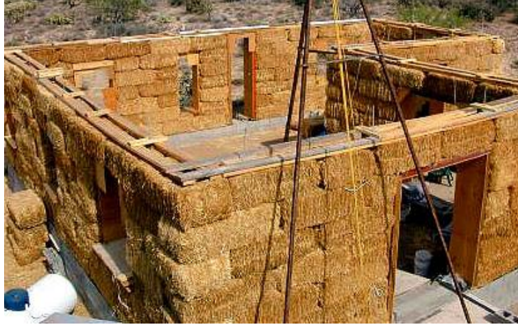
Şekil 3.71 Saman Balyasından Taşıyıcı Duvarların Oluşturulması [124]
