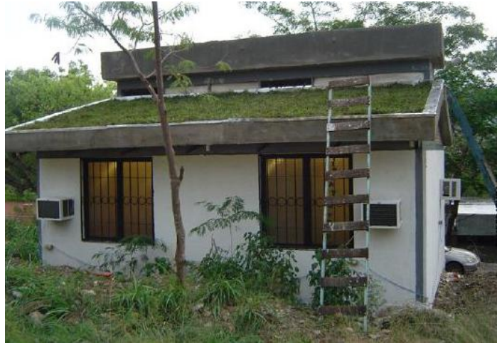
Şekil 3.98 Toprakla Örtülmüş Çatı (Bozza, 2009)
