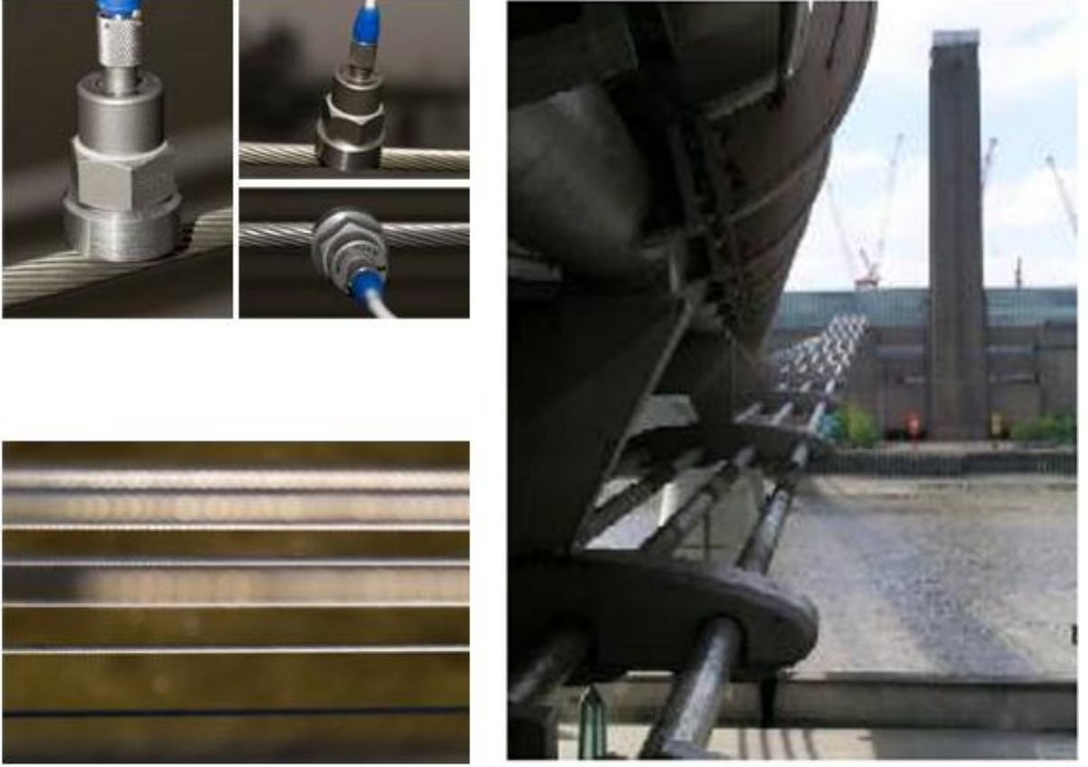
Şekil 3.8 Harmonic Bridge, çelik teller üzerindeki titreşim algılayıcılar ve Millenium Köprüsü [12]
