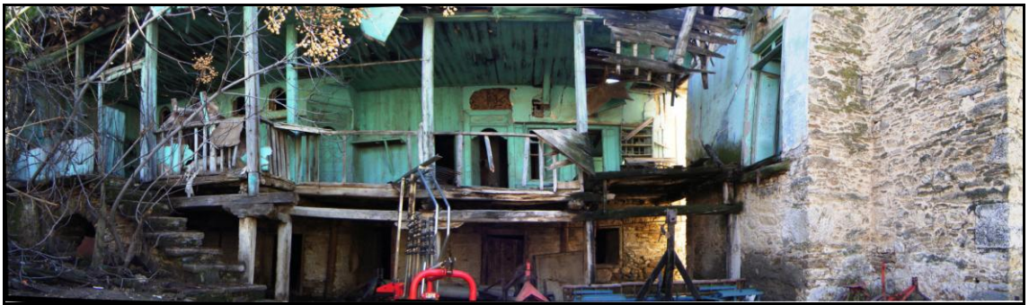
Şekil 2.27 Mehmet Bey Konağı, avludan hayat ve kule'nin görünüşü, Yazıkent, Aydın (Hürol, Şubat 2011)
