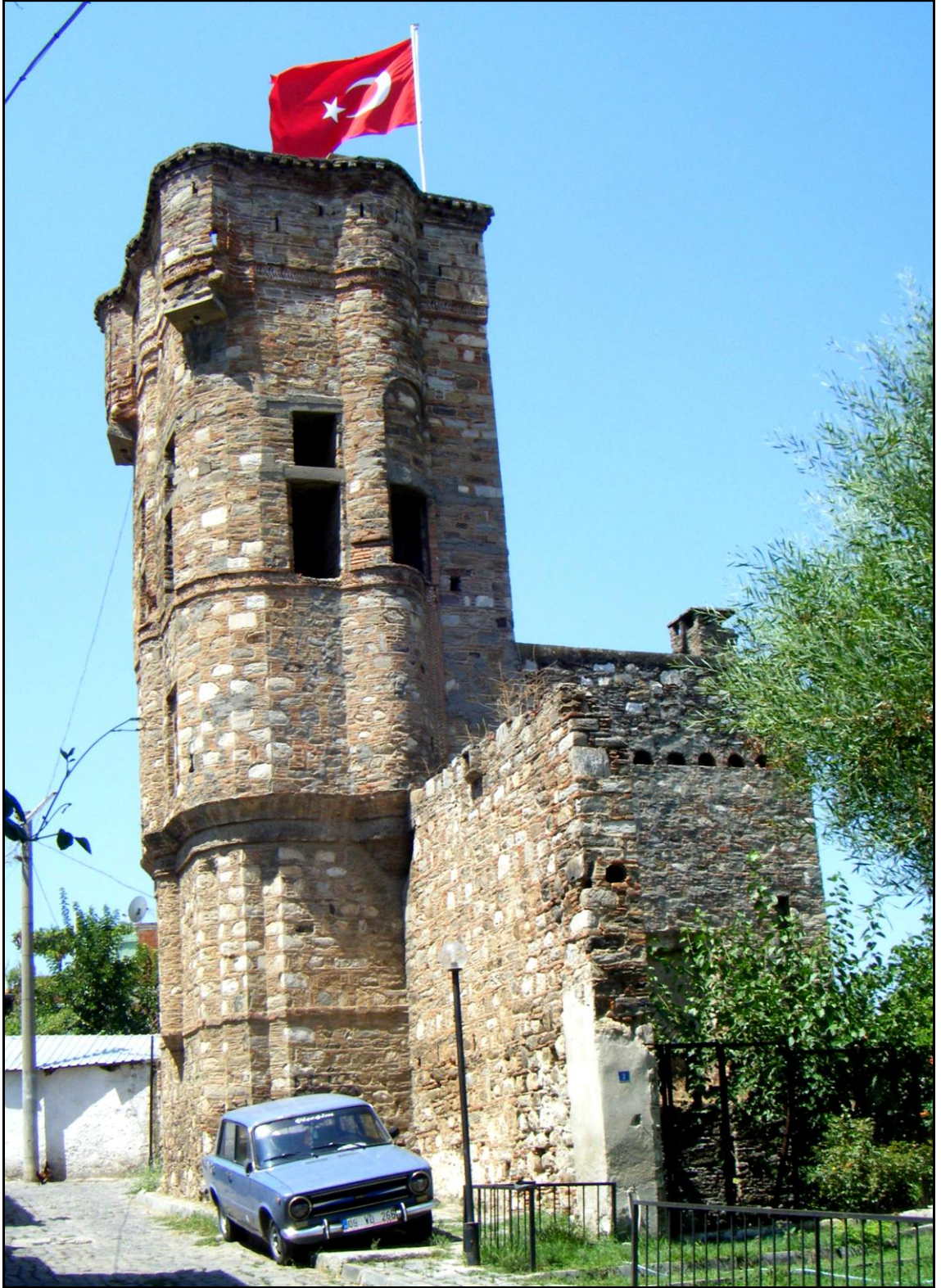
Şekil 2.13 Cihanoğlu Kulesi, Koçarlı Aydın (Hürol, Ağustos 2010)
