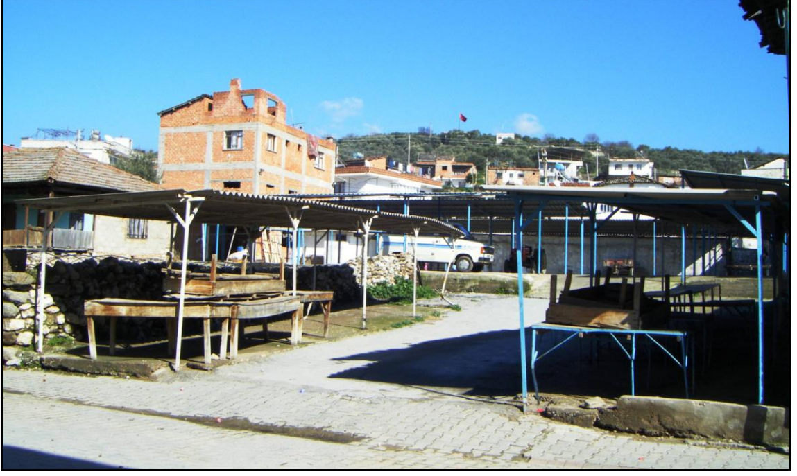
Şekil 2.40 Yıkılan İskender Bey Konağı ve Kulesi'nin bulunduğu pazar alanı, Yazıkent, Aydın (Hürol, Şubat 2011)
