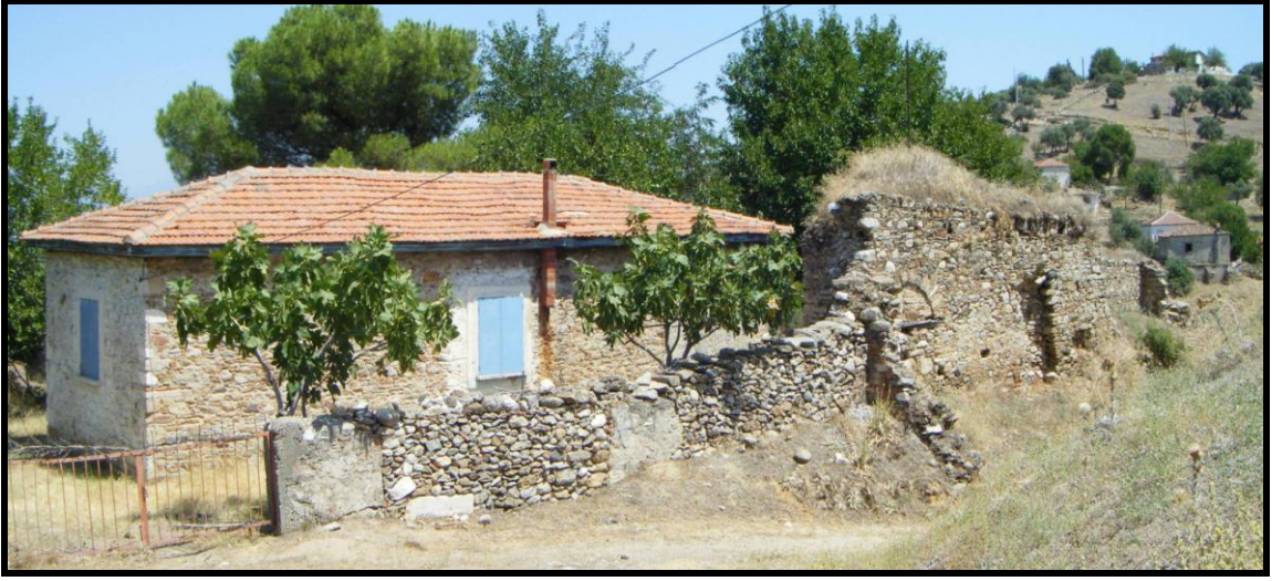
Şekil 2.9 Cincin Kulesi üzerinde yer alan konut yapısı (Hürol, Ağustos 2010)
