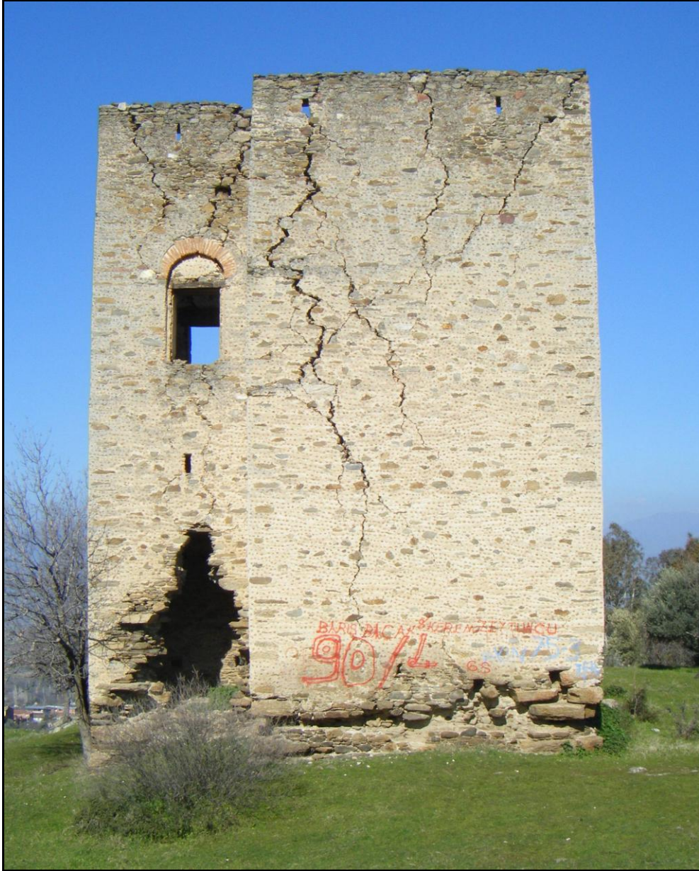
Şekil 2.44 Donduran Kulesi, güney cephesi, Yenipazar, Aydın (Hürol, Şubat 2011)
