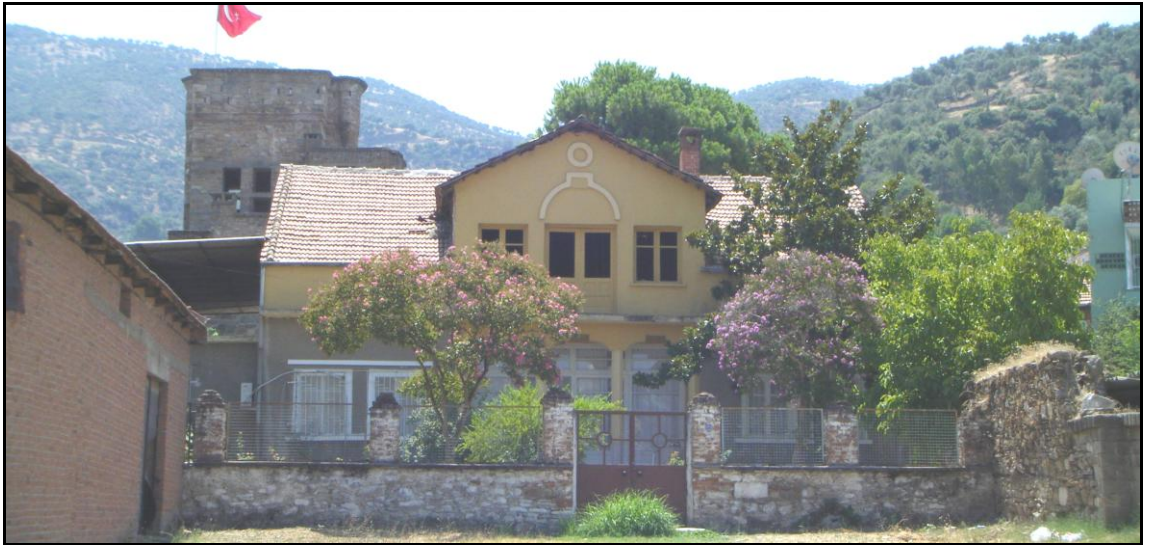
Şekil 2.15 Kulenin bahçesindeki yeni konak, Koçarlı, Aydın (Hürol, Ağustos 2010). Yapı Cihanoğlu Ailesi'nin gelini Vesile Cihanoğlu tarafından konut olarak kullanılmaktadır.
