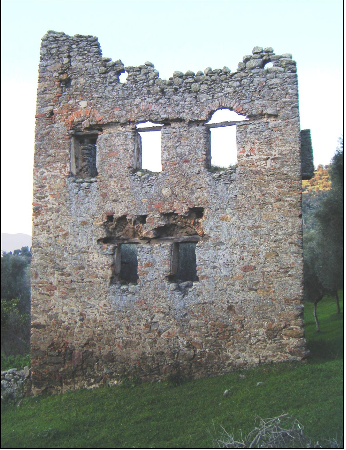
Şekil 2.66 Bölüntü Kulesi, doğu cephesi, Çine, Aydın (Hürol, Şubat 2011)
