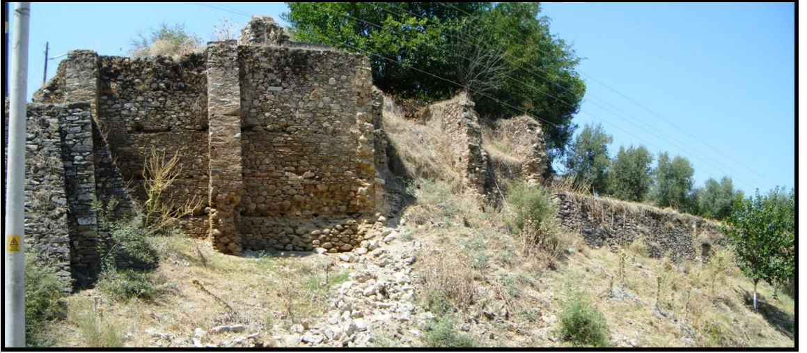
Şekil 2.6 Cincin Kulesi güney istinat duvarları (Hürol, Ağustos 2010)
