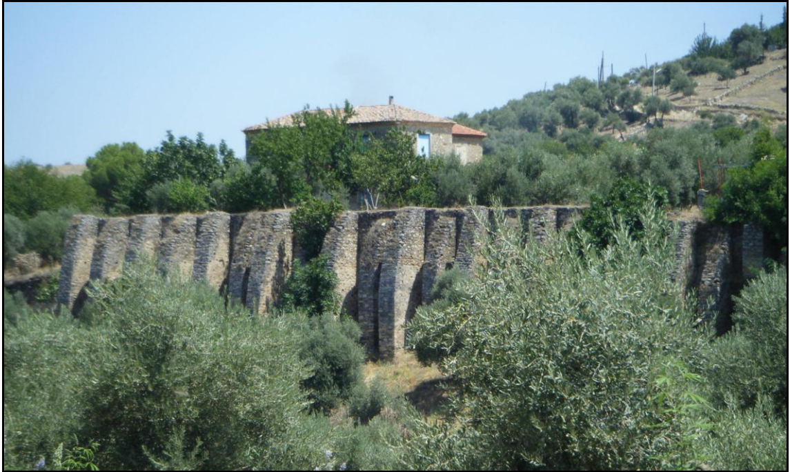
Şekil 2.1 Cincin Kulesi, Koçarlı, Aydın (Hürol, Ağustos 2010)
