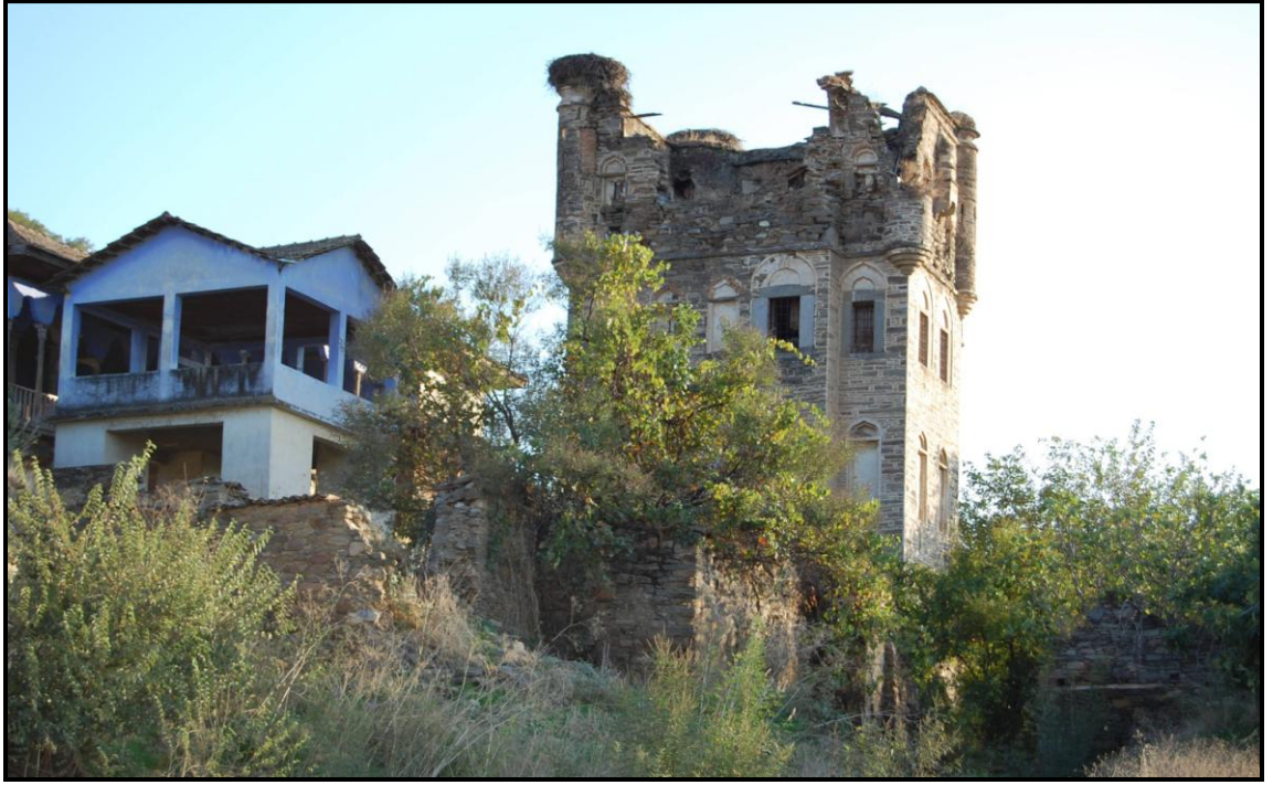
Şekil 2.76 Arpaz Kulesi, güneybatı cephesi, Nazilli, Aydın (Hürol, Ekim 2010)
