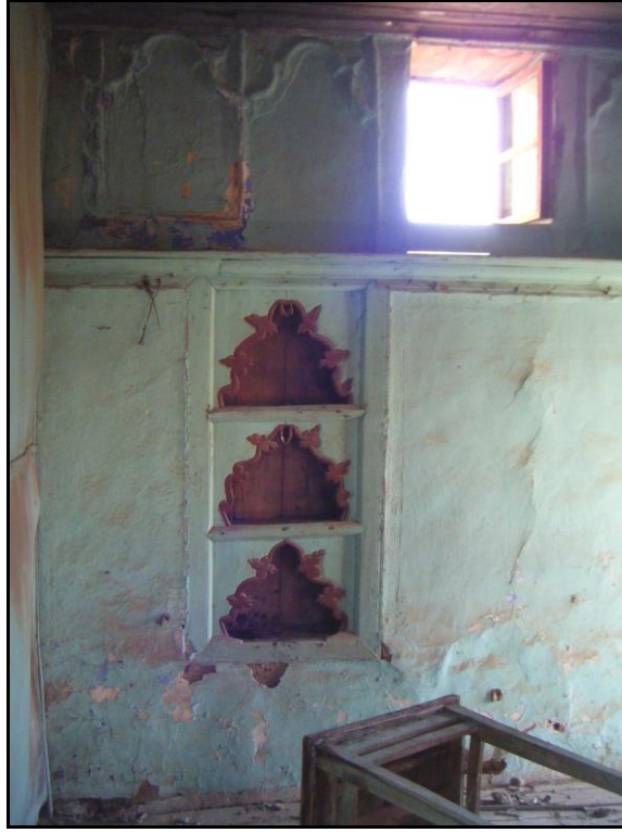
Şekil 2.36 Mehmet Bey Konağı birinci kat, başoda güney duvarı, Yazıkent, Aydın (Hürol, Şubat 2011)
