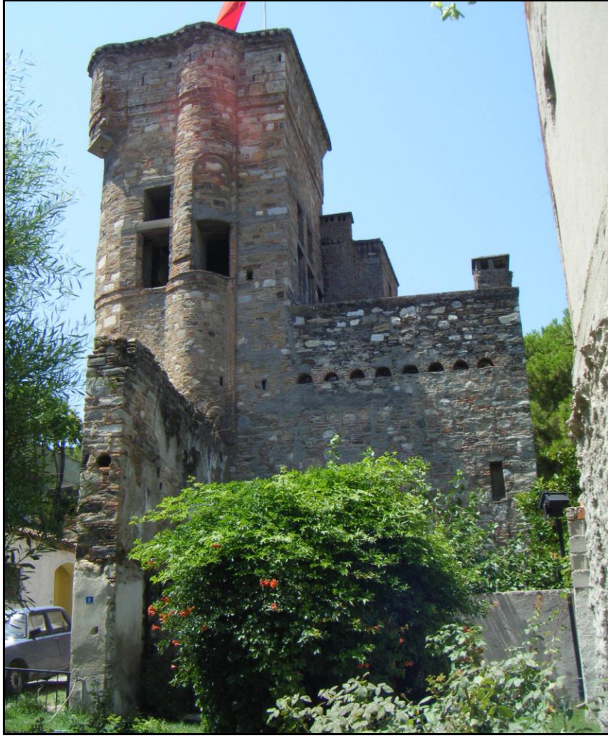
Şekil 2.14 Cihanoğlu Kulesi, Koçarlı, Aydın (Hürol, Ağustos 2010)
