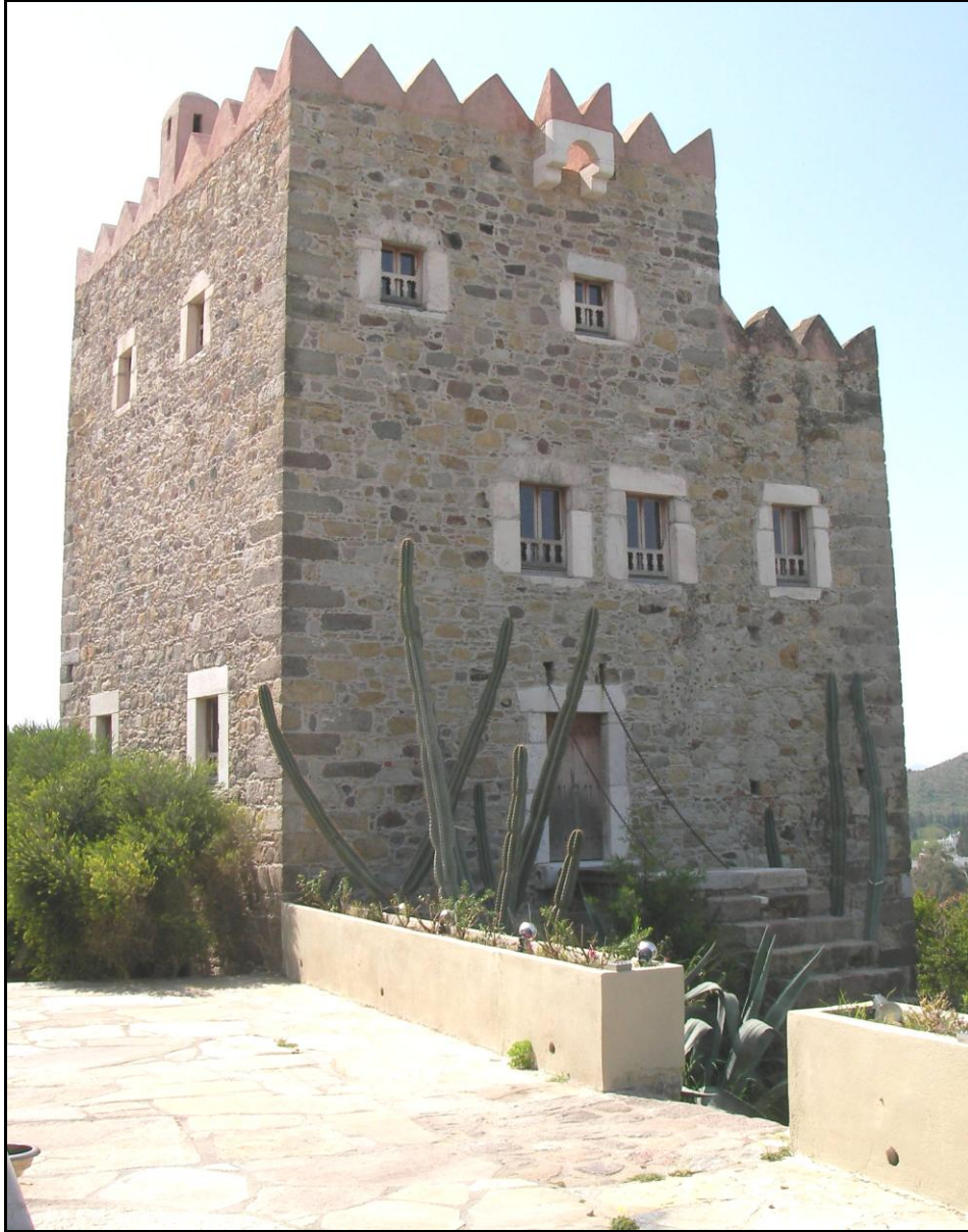
Şekil 2.52 Mustafa Paşa Kulesi, Ortakent (Müsgebi), Bodrum, MUĞLA (Hürol, Nisan 2010)
