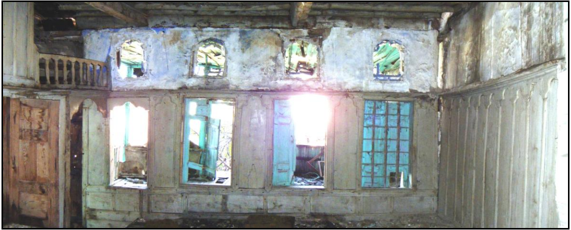
Şekil 2.33 Mehmet Bey Konağı birinci kat, odadan hayata bakış, Yazıkent, Aydın (Hürol, Şubat 2011)
