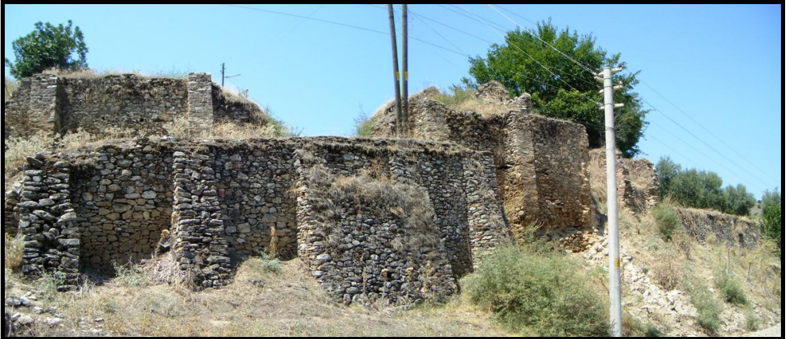
Şekil 2.7 Cincin Kulesi güney istinat duvarları (Hürol, Ağustos 2010)
