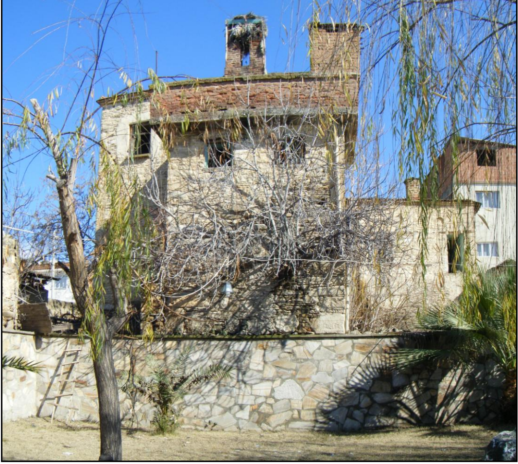
Şekil 2.38 Mehmet Bey Kulesi güneybatı cephesi, Yazıkent, Aydın (Hürol, Şubat 2011)
