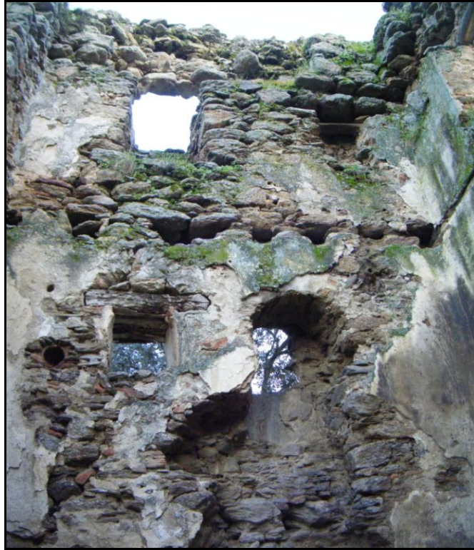
Şekil 2.71 Bölüntü Kulesi, kule içinden görünüş, Çine, Aydın (Hürol, Şubat 2011) Yıkılan ocağın izi ve ahşap döşeme kirişlerinin yuvaları görülebilmektedir.
