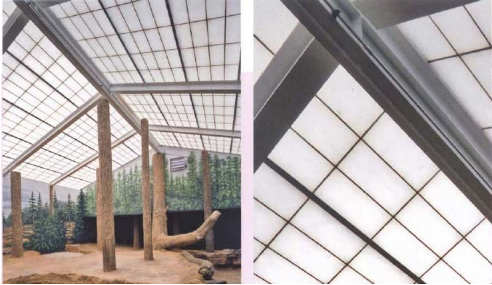
Şekil 3. 18 Şeffaf ısı yalıtım malzemesi: Aerogel – Floransa Hayvanat Bahçesi
