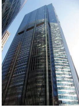
Şekil 2.3 111 South Wacker (208m.-51katlı) ,Chicago/ABD, Goettsch Partners [13].
