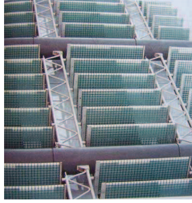
Şekil 4.20 Fotovoltaik cephe örneği [171], [172].
