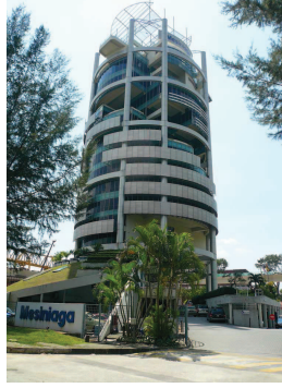
Şekil 2.17 Menara Mesiniaga, Kuala Lumpur [54].
