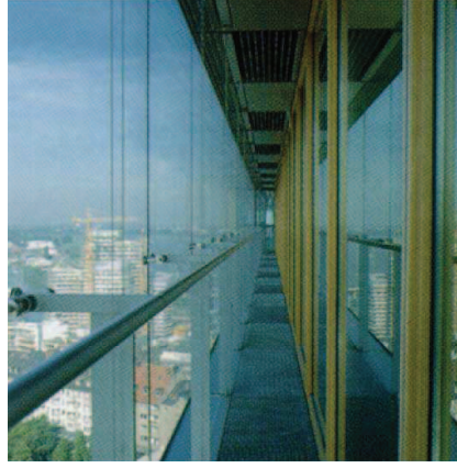
Şekil 4.19 Dış kabukta 12mm'lik temperli cam, iç kabukta low-e cam kullanılmış bina örneği Düsseldorf City Gate Binası, Almanya [167].
