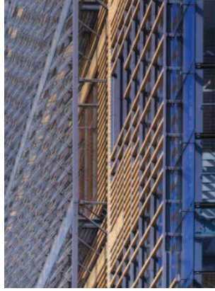
Şekil 4.36 Dış kabuğu oluşturan hareketli cam lamellerin ara boşluktan ve dıştan görünüşü (Debis Binası) ( Kristy Wung, Debis Tower, Berlin, Germany, Renzo Building Workshop)
