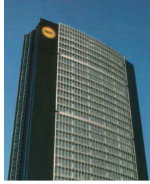
Şekil 4.47 Şaft tipi çift kabuklu cephe sisteminin uygulandığı Düsseldorf / ARAG binası [210].
