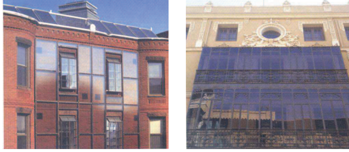
Şekil 4.62 Güneş duvarı-çok katlı konut, ABD, Toledo'dan bir güneş cephesi -İspanya [241].
