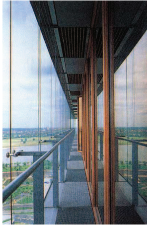
Şekil 4.34 Ara boşluğu kat yüksekliğinde sınırlandırılmış bir çift kabuklu cephe sisteminin yakın görünüşü (Düsseldorf Stadttor) [192].
