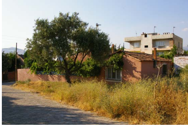
Şekil 5.57 1970 – 2010 dönemine ait yapının sokaktan görünüşü (f: Şakir Yelken)
