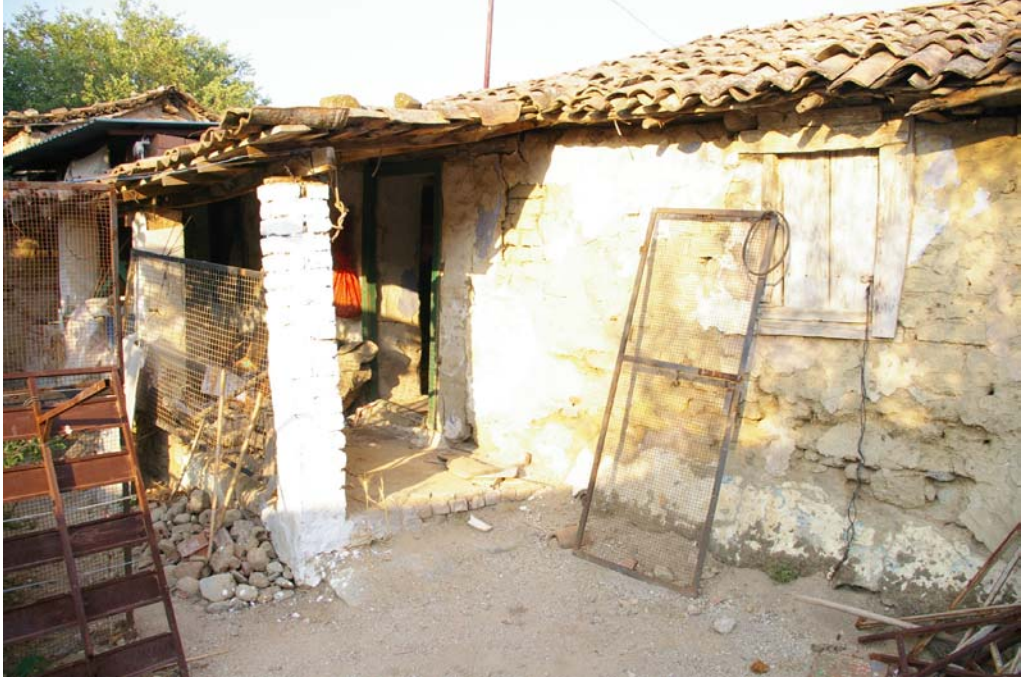
Şekil 5.37 Konutun hayat kısmının avludan görünüşü (f: Şakir Yelken)
