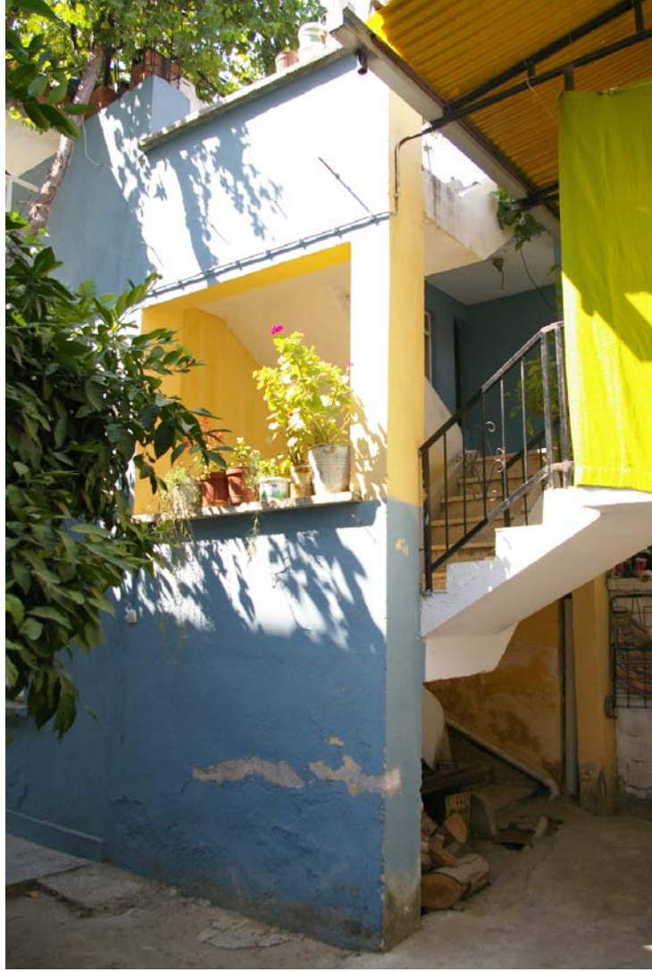
Şekil 5.91 Mehmet Altay Evi'nde ek yapıya ulaşımı sağlayan merdiven (f. Şakir Yelken)
