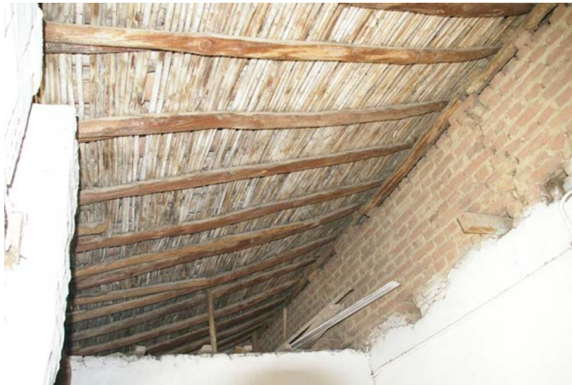
Şekil 5.66 Fatma Köle Evi çatı detayı (f: Şakir Yelken)
