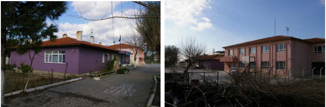
Şekil 4.14 Kardeşköy İlköğretim Okulu eski ve yeni binası (f: Şakir Yelken)
