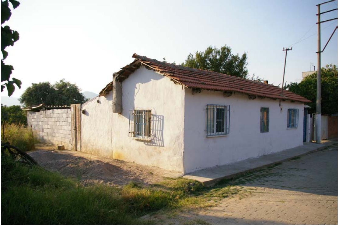
Őekil 5.47 AŐçı Ramiz Evi'nin sokaktan görünüşü (f: Őakir Yelken)
