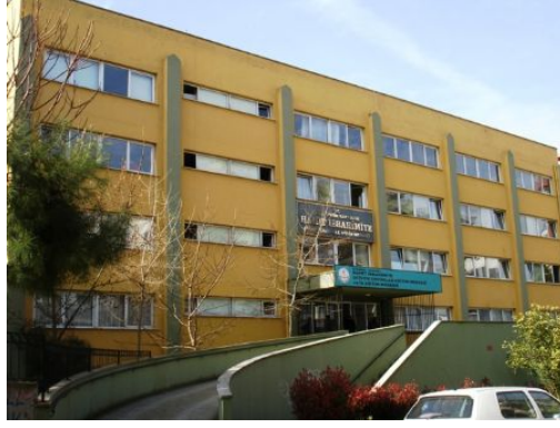
Şekil 3. 39 Bina giriş cephesi
