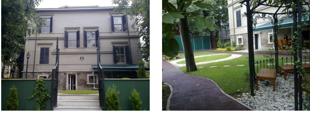
Şekil 3. 60 Arka cephe ve üst bahçe
