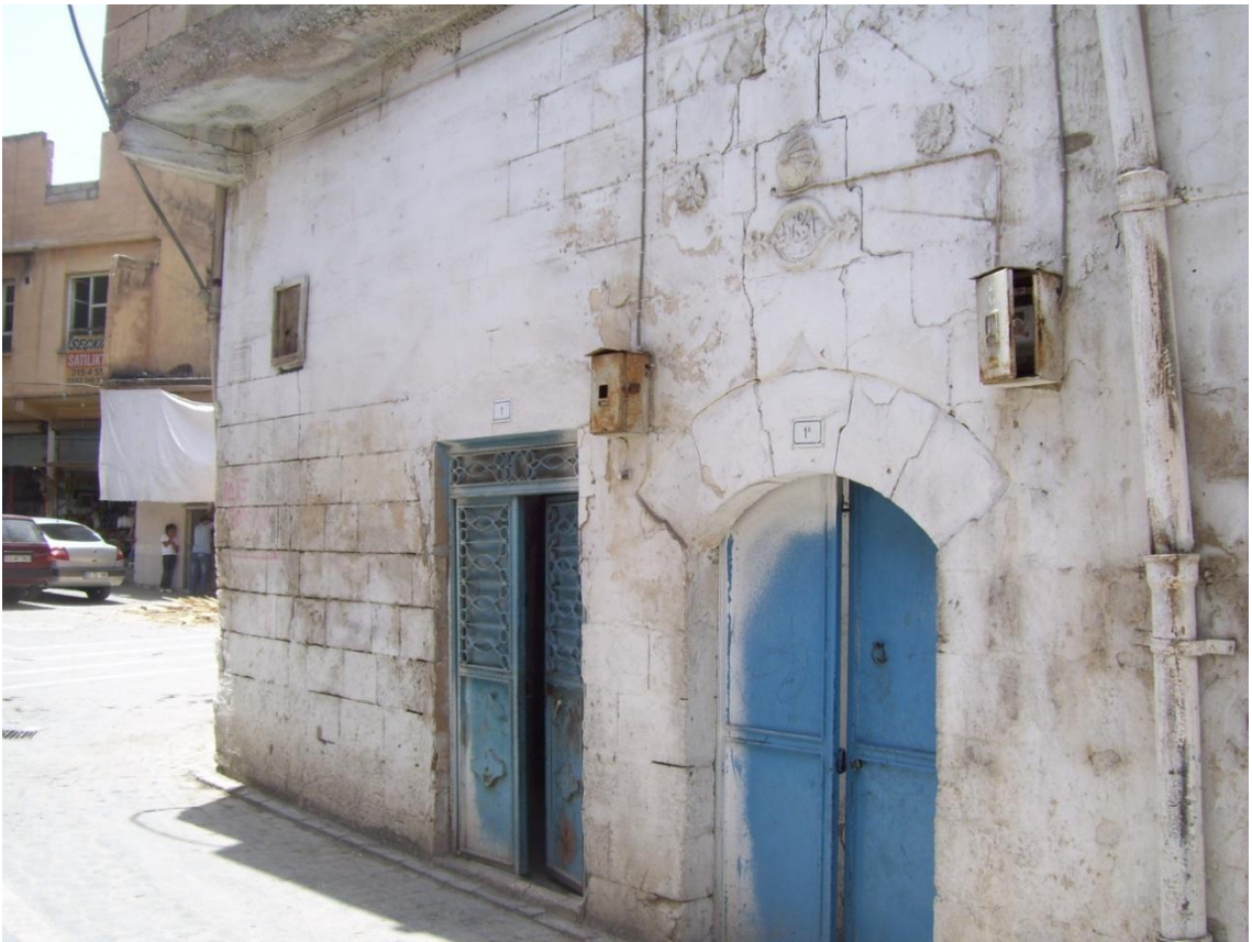
Şekil 4. 57 Yapıya girişi sağlayan doğu cephedeki kapılar, (Şanlıurfa, Nisan 2011)
