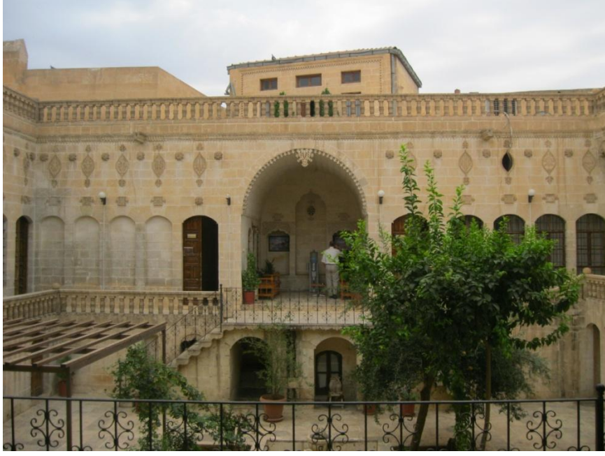
Şekil 5. 66 Şahap Bakır Evi, avludan çıkılan merdiven, gezenek, eyvan, gedemeç ve oda ilişkisi, (Şanlıurfa, Eylül 2011)
