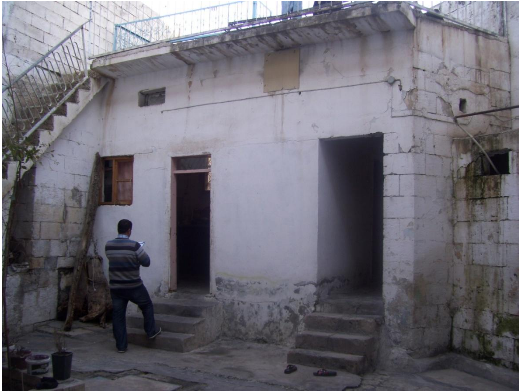
Şekil 4. 56 Yapının avlusu ve avluda sonradan yapılmış mekânlar, (Şanlıurfa, Nisan 2011)
