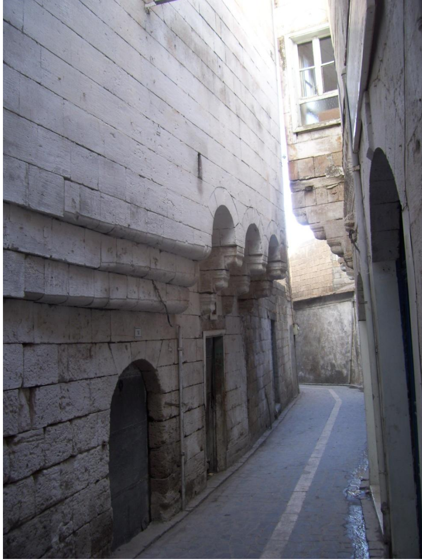
Şekil 5. 75 Yorgancı Sokak'tan taş konsol görünümüleri, (Şanlıurfa, Eylül 2010)
