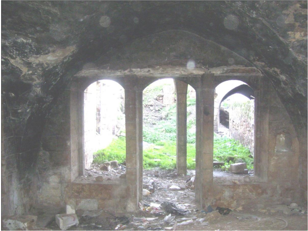
Şekil 6. 111 ZK-09 Nolu mekânda yer alan kapı ve pencerelerdeki ahşap hatıllar, (Şanlıurfa, Nisan 2009)
