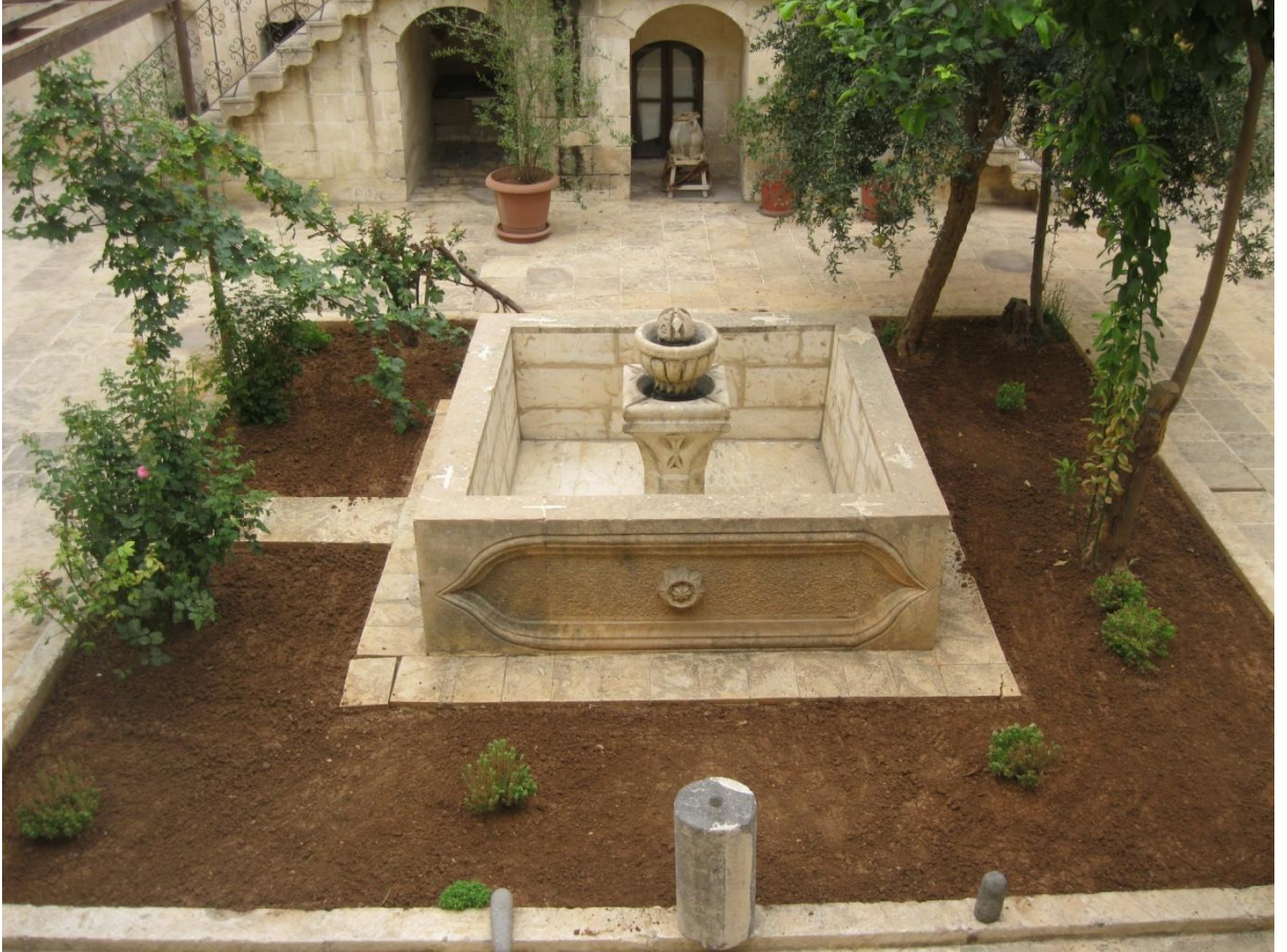
Şekil 5. 74 Şahap Bakır Evi, Avluda yer alan taş su havuzu, (Şanlıurfa, Eylül 2011)
