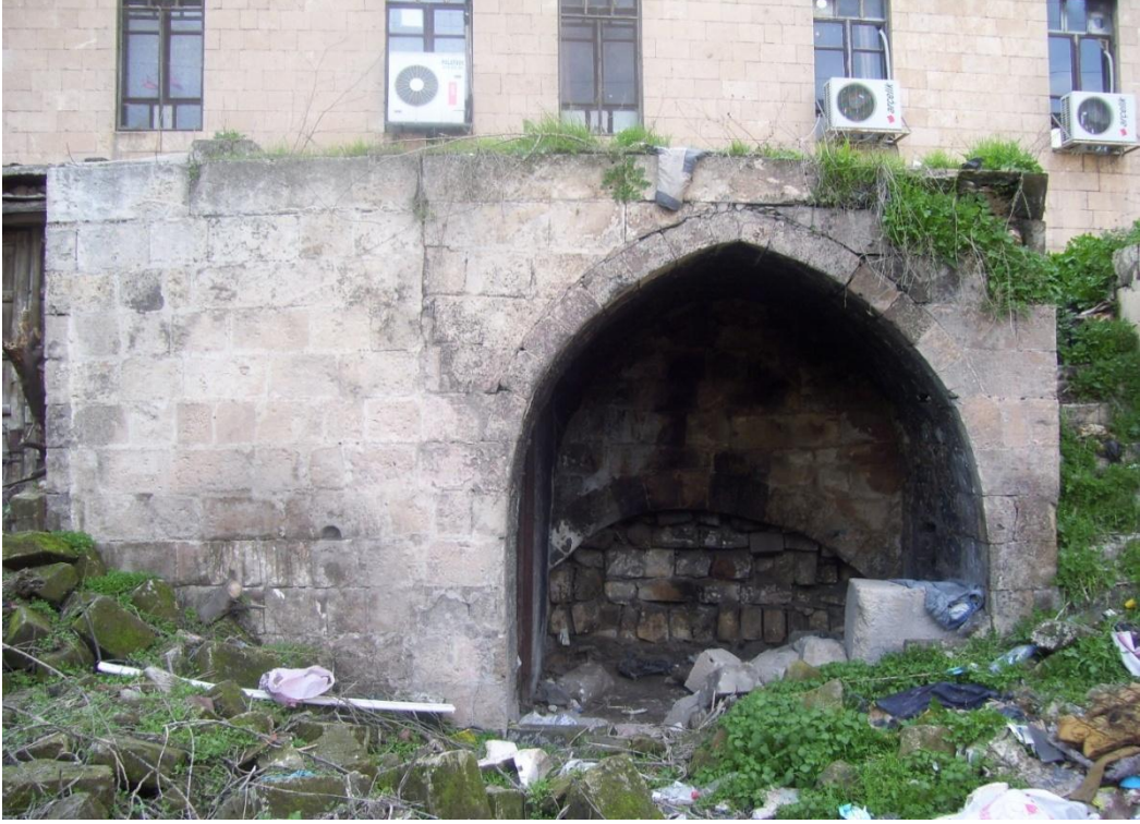
Şekil 6. 79 Mutfak mekânının avludan görünüşü, (Şanlıurfa, Nisan 2009)
