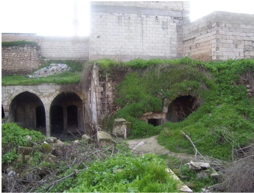
Şekil 6. 107 1K-06 Nolu dam, bitkilenmeler ve alttaki beden duvarlarındaki yıkıntılar, (Şanlıurfa, Nisan 2009)
