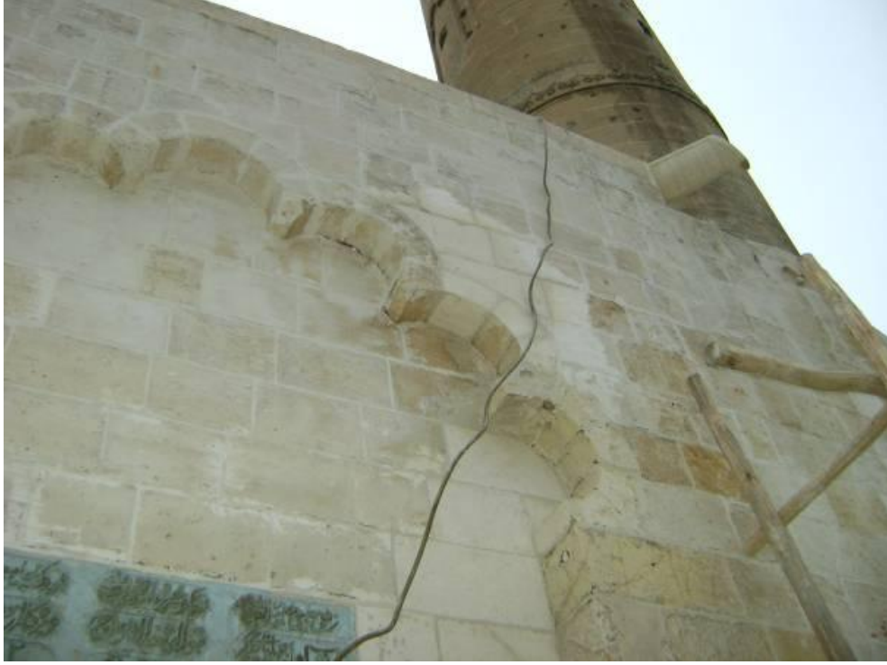
Şekil 8. 141 Hızanoğlu Camii, taş malzemede çürütme işlemi yapılması, (Şanlıurfa, Nisan 2011)
