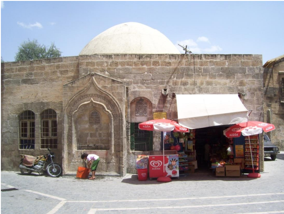
Şekil 4. 49 Şeyh Saffet Tekkesi, doğu cephesi, cephede yer alan bakkal ve çeşme, (Şanlıurfa, Nisan 2011)
