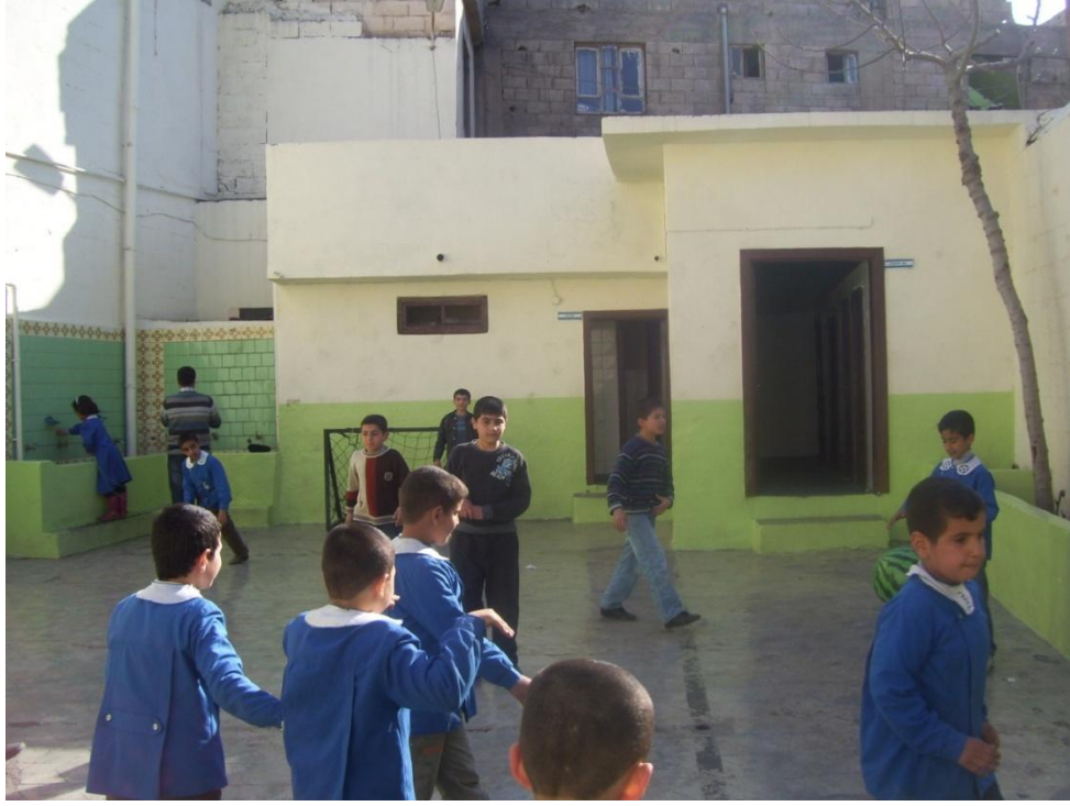
Şekil 4. 44 Kurtuluş İlköğretim Okulu bahçesi ve ilave edilen ıslak hacimler, (Şanlıurfa, Nisan 2011)
