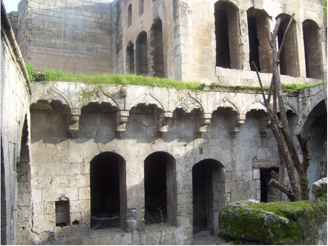
Şekil 6. 84 ZK-07 Nolu mekânın avludan görünümü ve taş konsollar, (Şanlıurfa, Nisan 2009)
