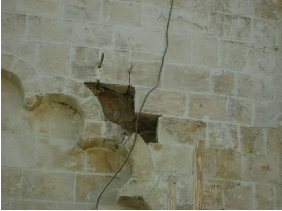
Şekil 8. 140 Hızanoğlu Camii, taş malzemede çürütme işlemi yapılması, (Şanlıurfa, Nisan 2011)
