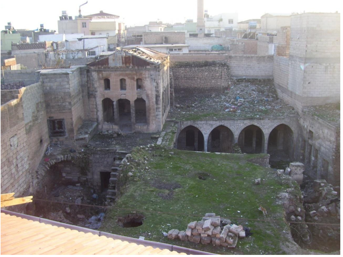
Şekil 6. 102 1K-03 Nolu terasın görünümü, solda taş merdiven ve merdiven çıkışında yer alan teras, (Şanlıurfa, Kasım 2010)
