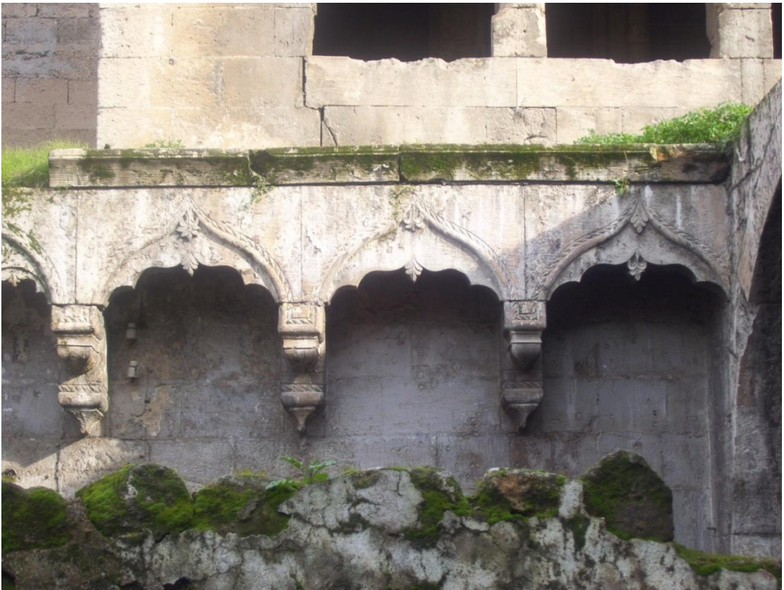
Şekil 6. 118 Konsollar; birbiri üzerindeki iki taş ve onların üzerinde yer alan süslemeli tek parça taş ve bitiş silmesi, (Şanlıurfa, Nisan 2009)
