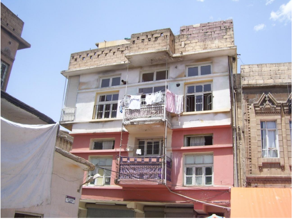
Şekil 4. 60 Yapının meydana bakan güney cephesi, (Şanlıurfa, Nisan 2011)
