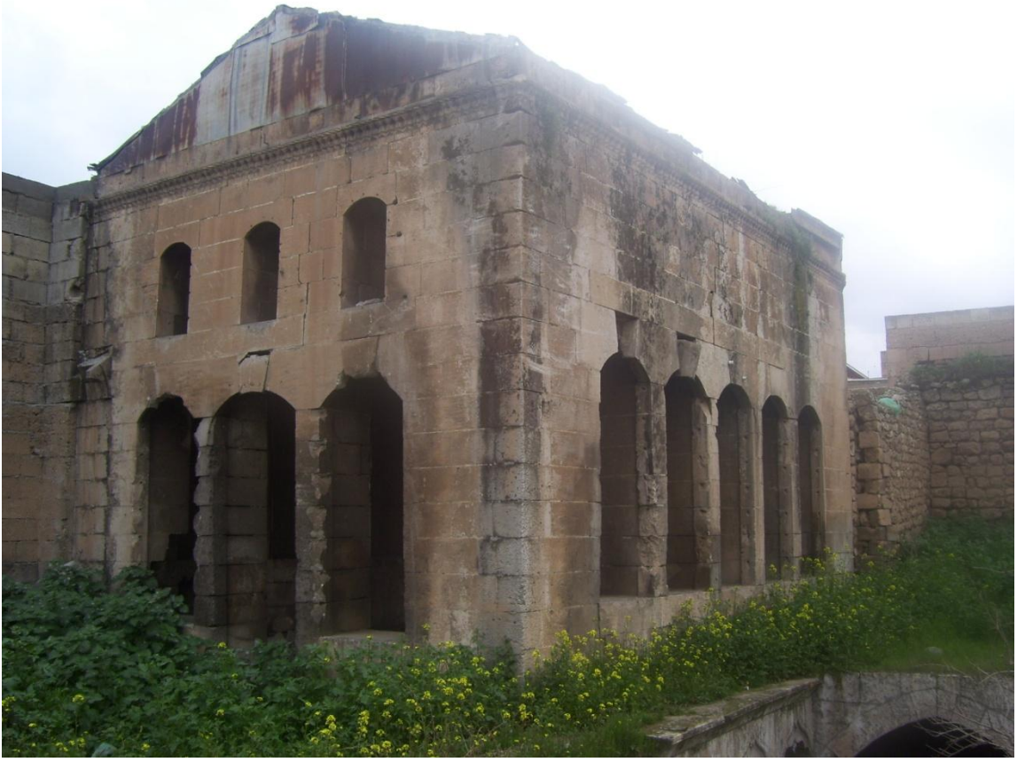
Şekil 6. 117 Köşk mekânında yer alan pencereler ve havalandırma takaları, (Şanlıurfa, Nisan 2009)
