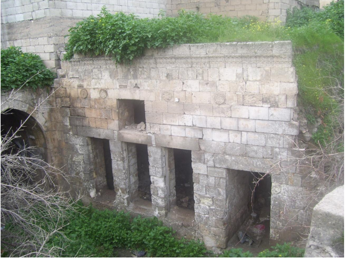
Şekil 6. 115 Düz taş lento ile oluşturulmuş kapı ve pencere boşlukları, (Şanlıurfa, Nisan 2009)
