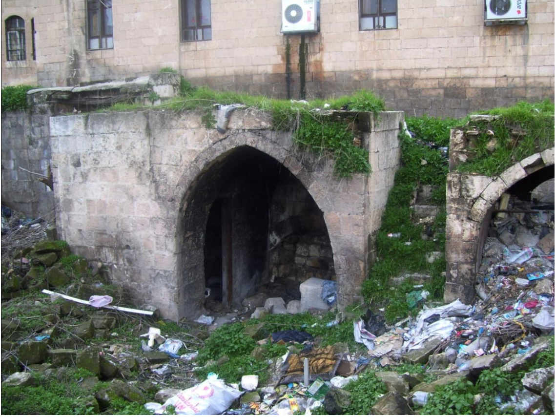
Şekil 6. 108 1K-07 Nolu dam, bitkilenmeler ve dama çıkan taş merdiven, (Şanlıurfa, Nisan 2009)
