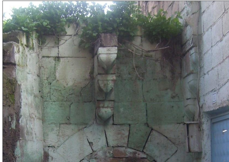
Şekil 6. 120 Batı cephede yer alan konsol, (Şanlıurfa, Nisan 2009)
