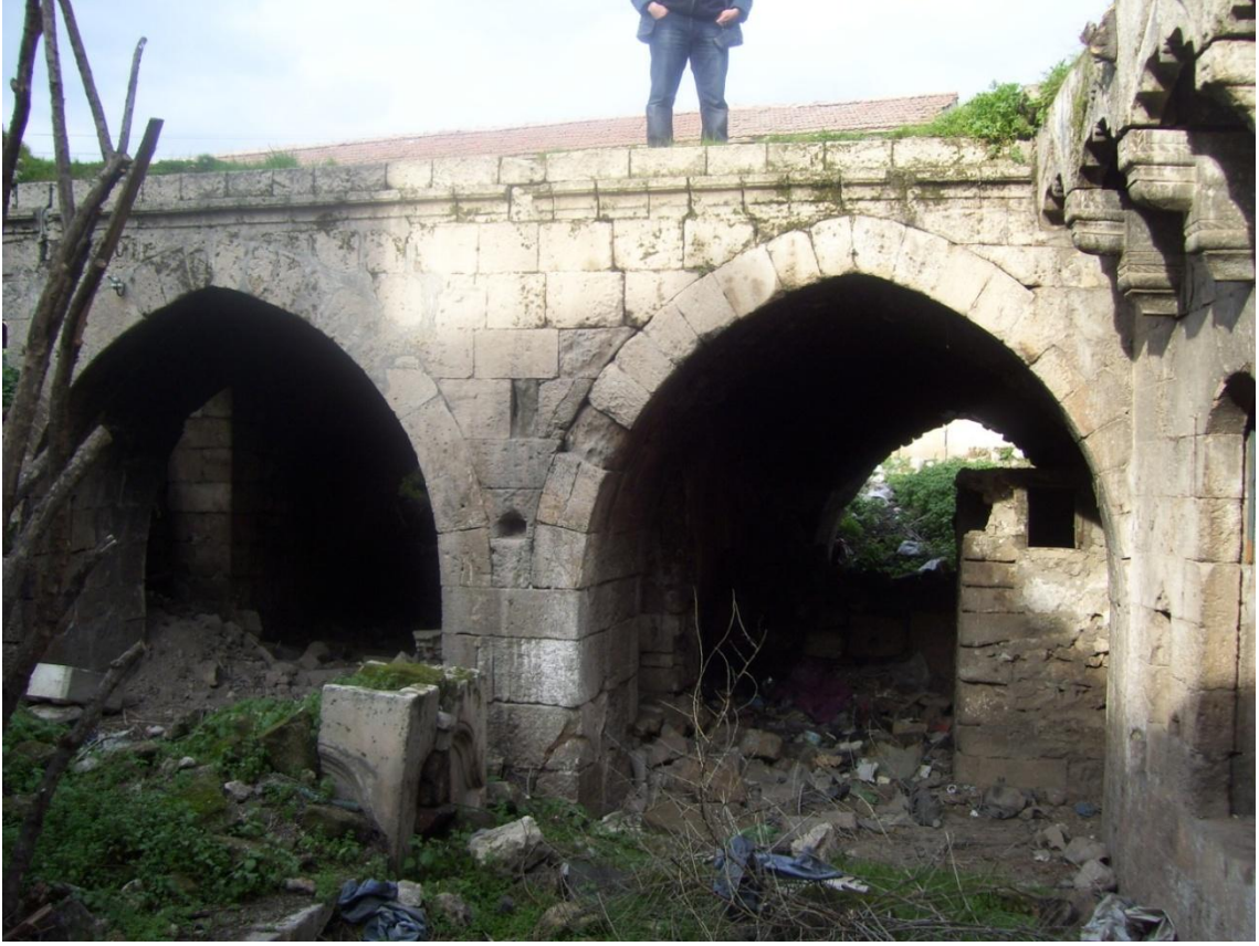
Şekil 6. 83 ZK-05 Nolu mekânın görünümü ve yapıya sonradan eklenen ZK-06 nolu banyo, (Şanlıurfa, Nisan 2009)
