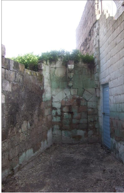
Şekil 6. 97 ZK-18 Nolu holün ve kapatılmış olan kapının dışarıdan görünümü ve taş konsollar ve izleri, (Şanlıurfa, Nisan 2009)
