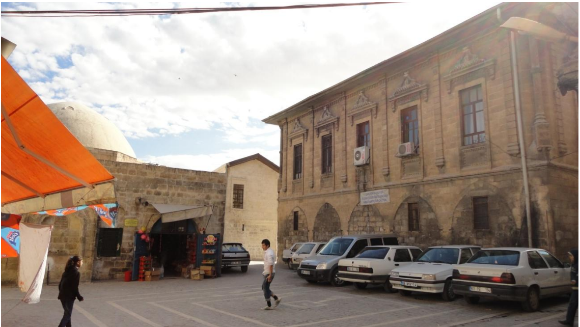
Şekil 8.142 Yapının zemin katında, tonozların içine örülmüş olan taşıyıcı olmayan duvarların kaldırılması ve duvarlar kaldırılarak meydanla bütünleşen bir kafeterya önerilmesi (Şanlıurfa, Ekim 2011)
