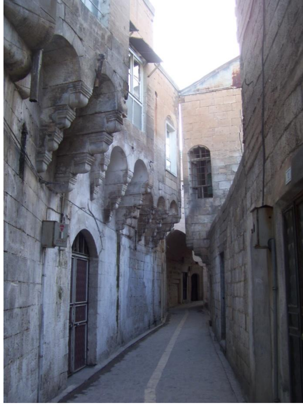
Şekil 5. 64 Yorgancı Sokaktan görünüm, taş duvarlar, süslemeli konsollar ve kabaltı, (Şanlıurfa, Nisan 2011)
