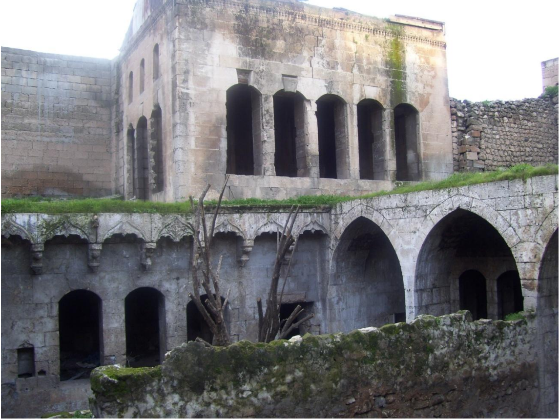
řekil 6. 92 ZK-14 Nolu avlu, avluya bakan pencereler ve niř. Pencerelerin üzerindeki tař konsollar, (řanlıurfa, Nisan 2009)
