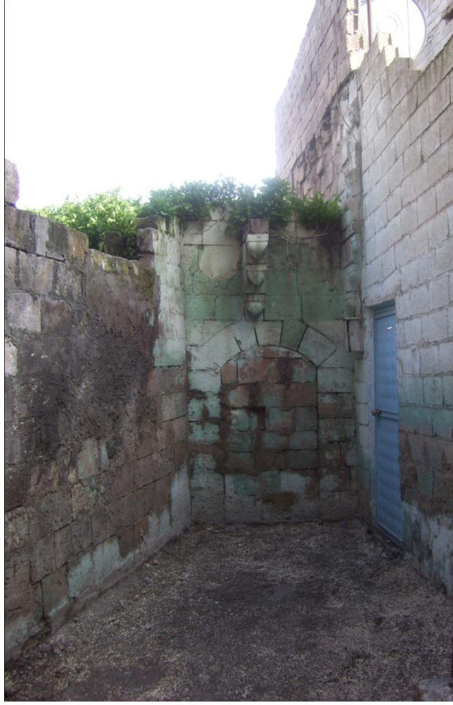
Şekil 6. 119 Batı cephede yer alan konsol izleri, (Şanlıurfa, Nisan 2009)
