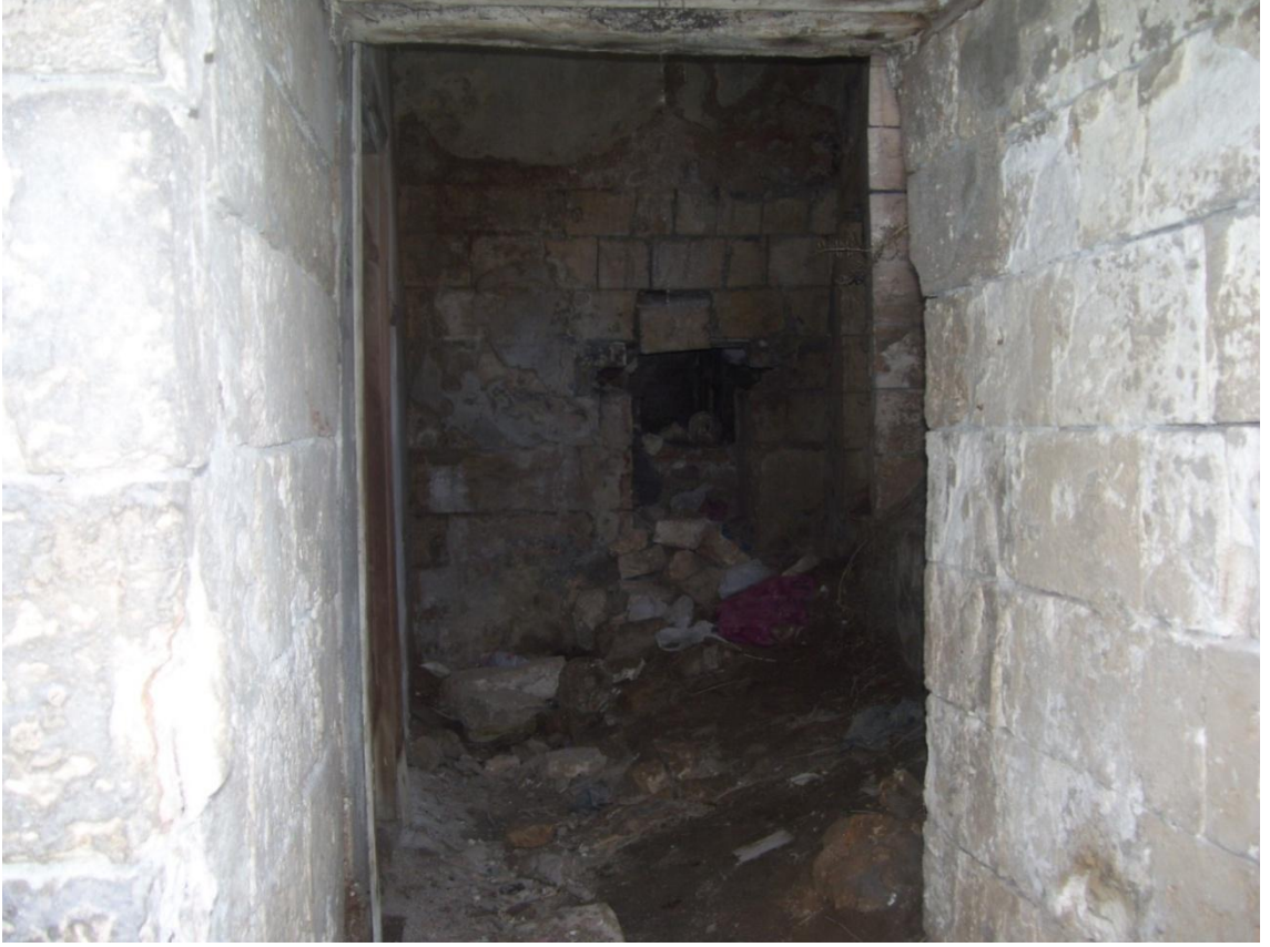
Şekil 6. 95 ZK-16 Nolu holün ve kısmen yıkılmış olan nişin görünümü, (Şanlıurfa, Nisan 2009)
