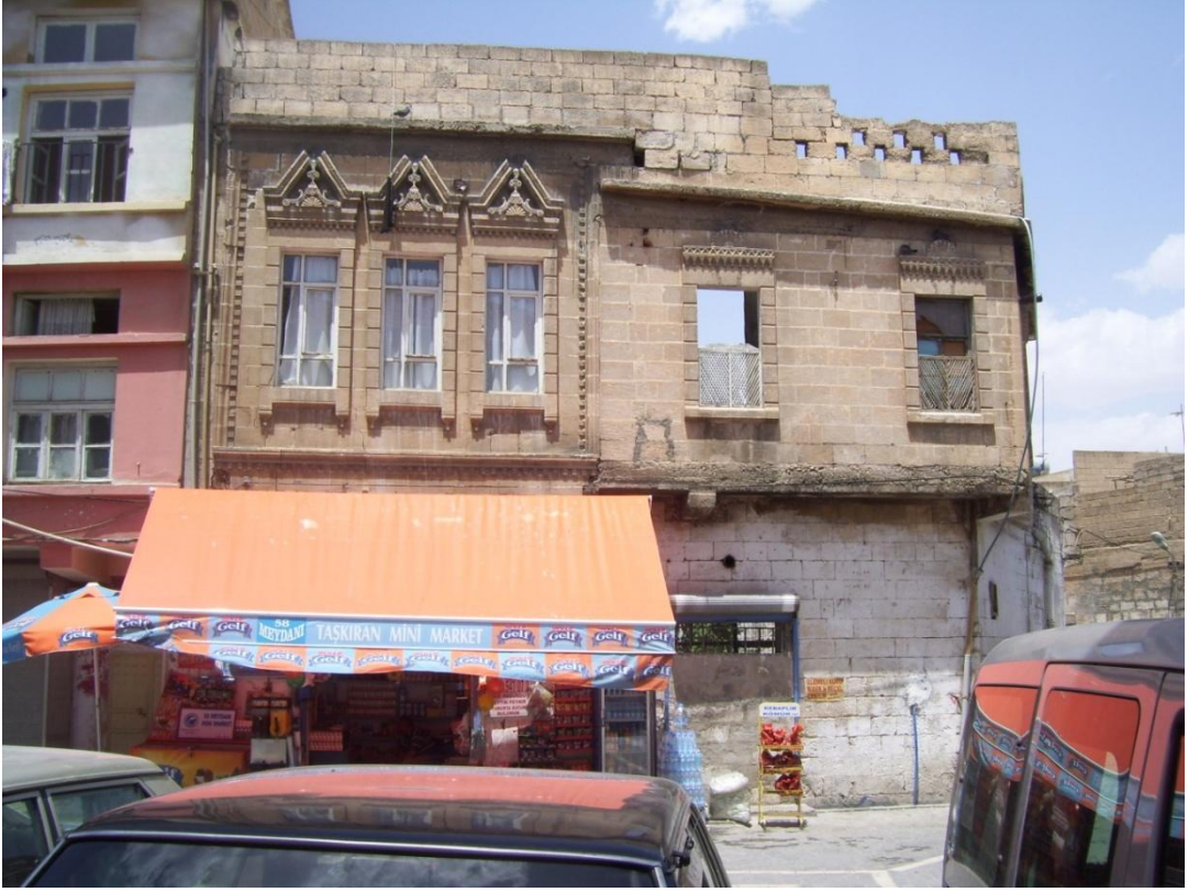
Şekil 4. 55 Yapının meydana bakan güney cephesi, (Şanlıurfa, Nisan 2011)
