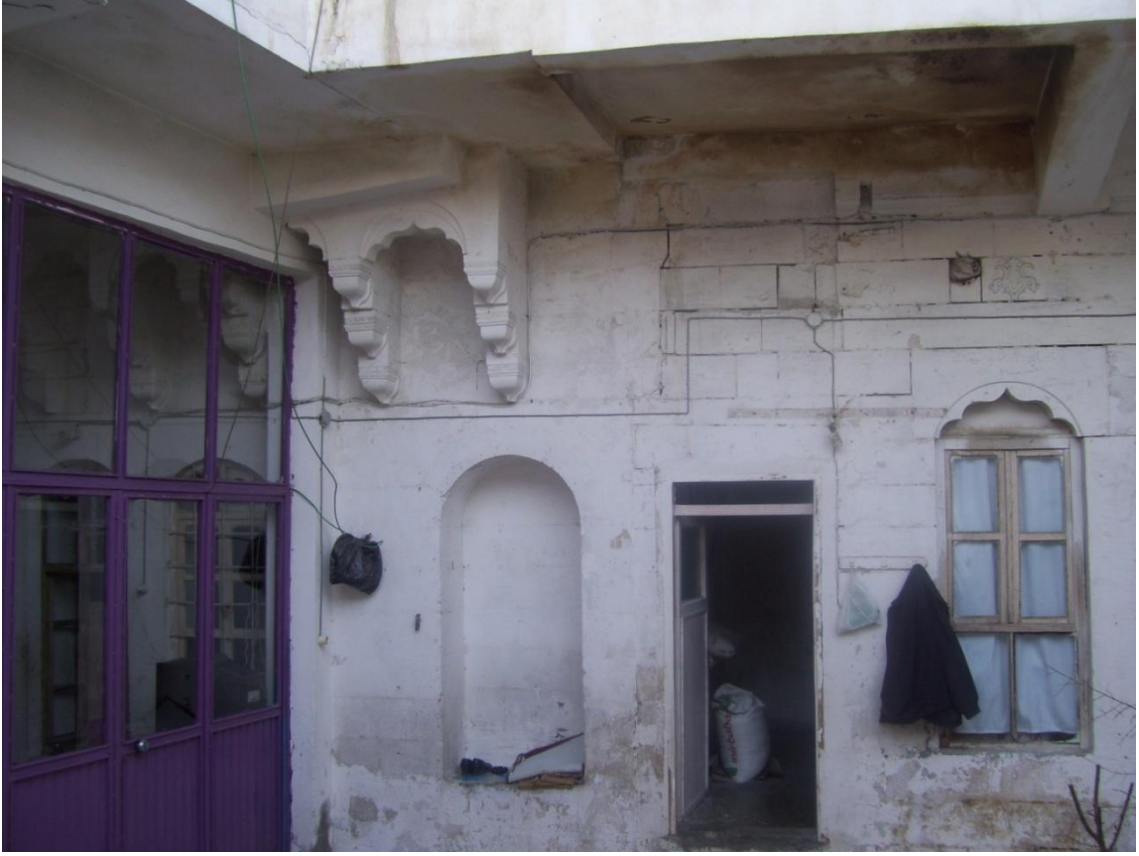
Şekil 4. 58 Yapının taş konsolları üzerine yapılan betonarme konsollar ve kirişler, (Şanlıurfa, Nisan 2011)
