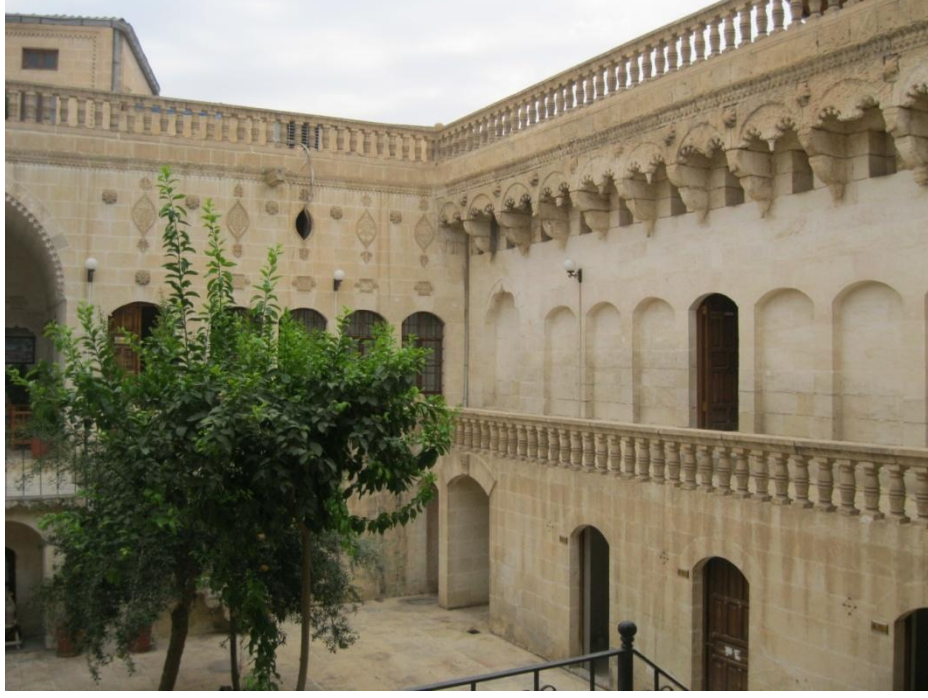
Şekil 5. 70 Şahap Bakır Evi, taş korkuluklar, konsollar, kuş takaları, ışık takası, kapı ve pencereleri ile avlu cephesi, (Şanlıurfa, Eylül 2011)
