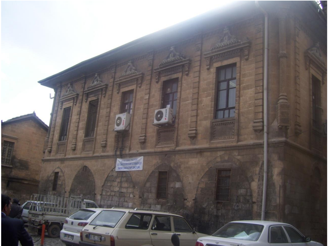
Şekil 4. 40 Ellisekiz Meydanı'ndan görünüm, Kurtuluş İlköğretim Okulu cephesi, taş işçiliği ve süslemeleri, (Şanlıurfa, Nisan 2011)
