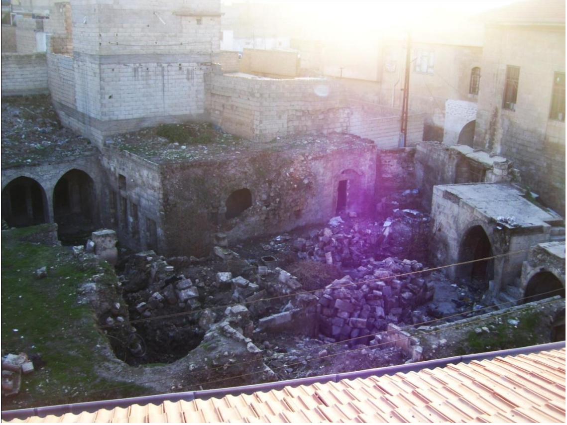
Şekil 6. 81 ZK-02 Nolu avlunun görünümü, (Şanlıurfa, Kasım 2010)
