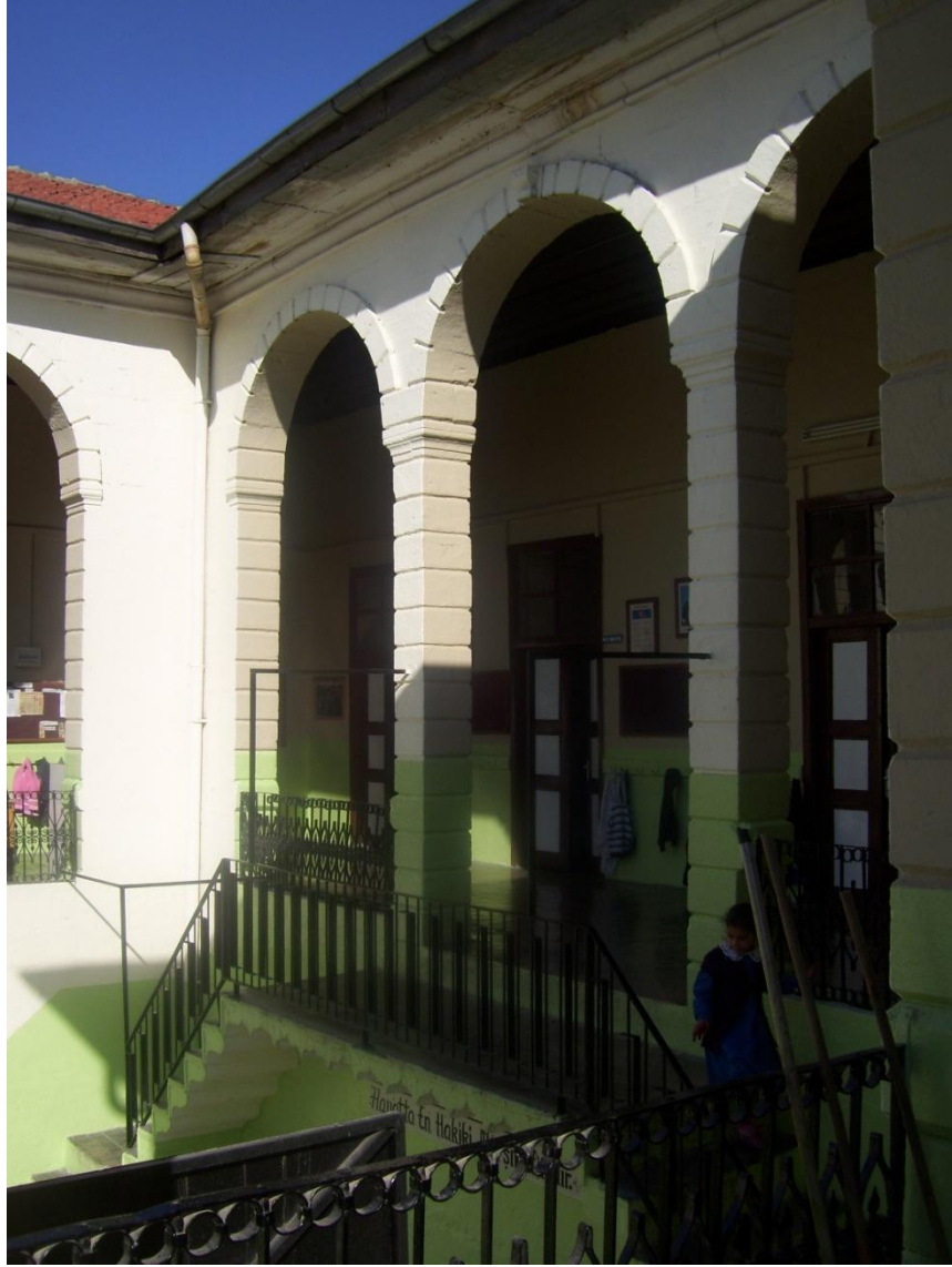
Şekil 4. 43 Kurtuluş İlköğretim Okulu birinci kata çıkan basamaklar, koridor ve sütunlar, (Şanlıurfa, Nisan 2011)
