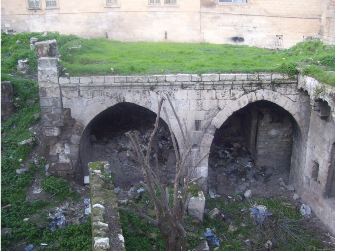
Şekil 6. 101 1K-02 Nolu damın görünümü ve bitkilenmeler, zeminde yer alan ZK-04 ve ZK-05 nolu mekânların girişi, (Şanlıurfa, Nisan 2009)
