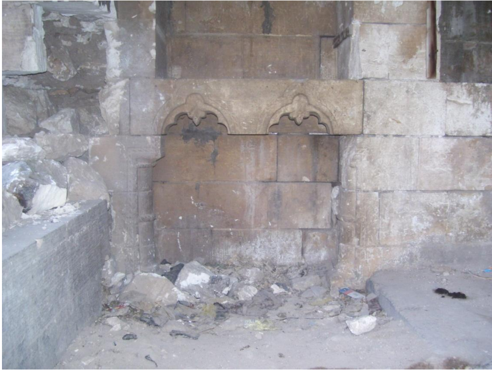
Şekil 5. 67 Abacılar Evi, Köşk mekanında yer alan testilik, (Şanlıurfa, Nisan 2009)
