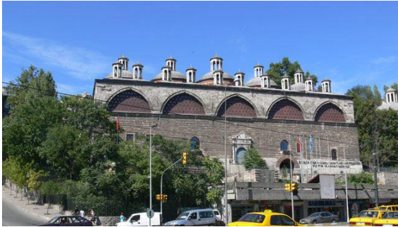
Şekil 2. 45 Dönüşüm sonrası yapının genel görünümü [13]
