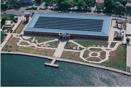
Şekil 2. 40 Dönüşüm sonrası yapının genel görünümü [16]
