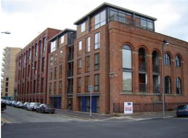
Şekil 2. 14 Yapının dönüşüm sonrası genel görünümü [8]
