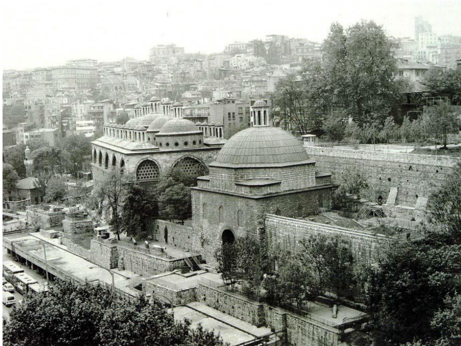
Şekil 2. 43 Dönüşüm öncesi yapının genel görünümü [13]
