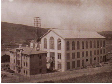
Şekil 2. 24 Yapının dönüşüm öncesi görünümü [2]
