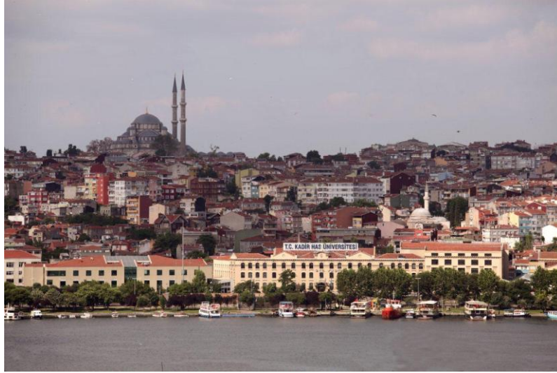
Şekil 2. 31 Dönüşüm sonrası yapının genel görünümü
