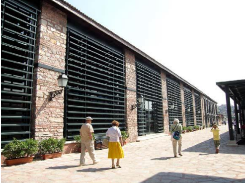
Şekil 2. 53 Dönüşüm sonrası yapının genel görünümü [2]
