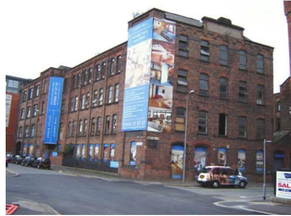
Şekil 2. 18 Yapının dönüşüm sonrası genel görünümü [8]
