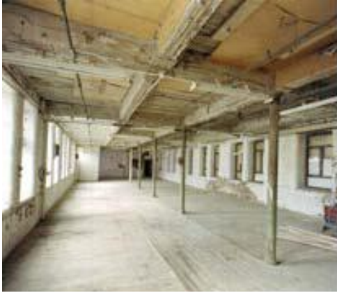
Şekil 2. 17 Yapının dönüşüm öncesi iç mekan görünümü [8]
