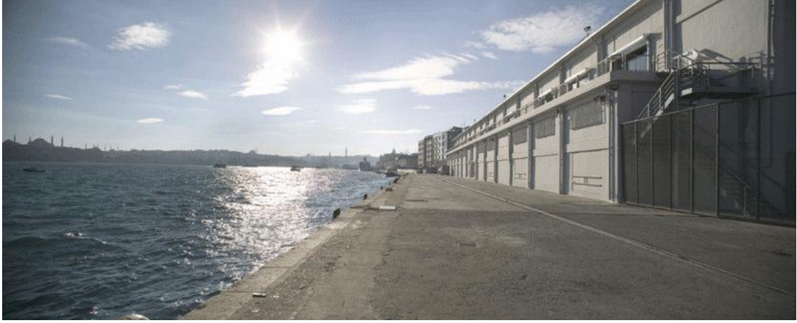
Şekil 2. 47 Dönüşüm sonrası yapının genel görünümü [18]
