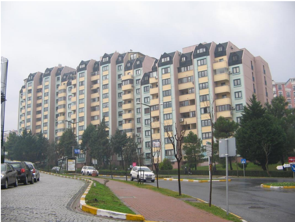
Şekil 5. 48 Funda 06 yapı adasının Ahmet Taner Kışlalı Bulvarı'ndan görünüşü
