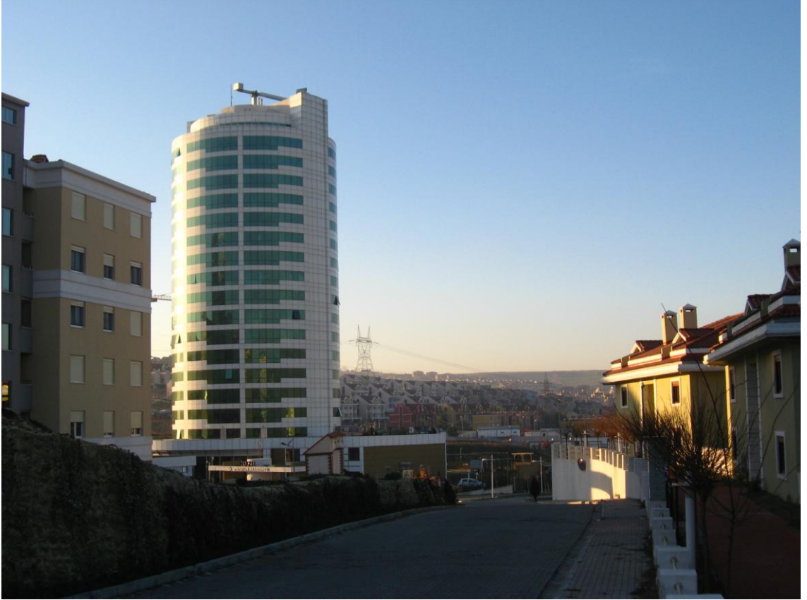
Şekil 5. 114 Spradon Residence'ın görünüşü
