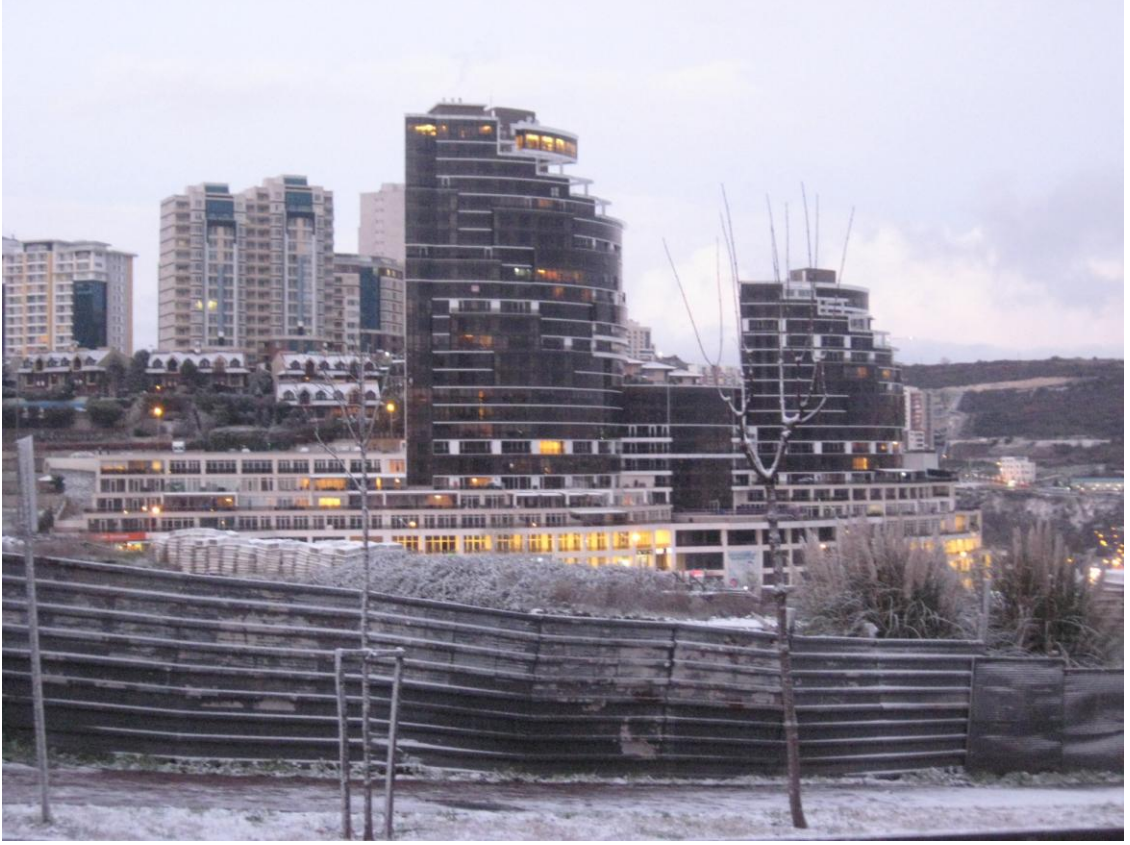
Şekil 5. 136 Loca'nın Süzer Bulvarı'ndan görünüşü
