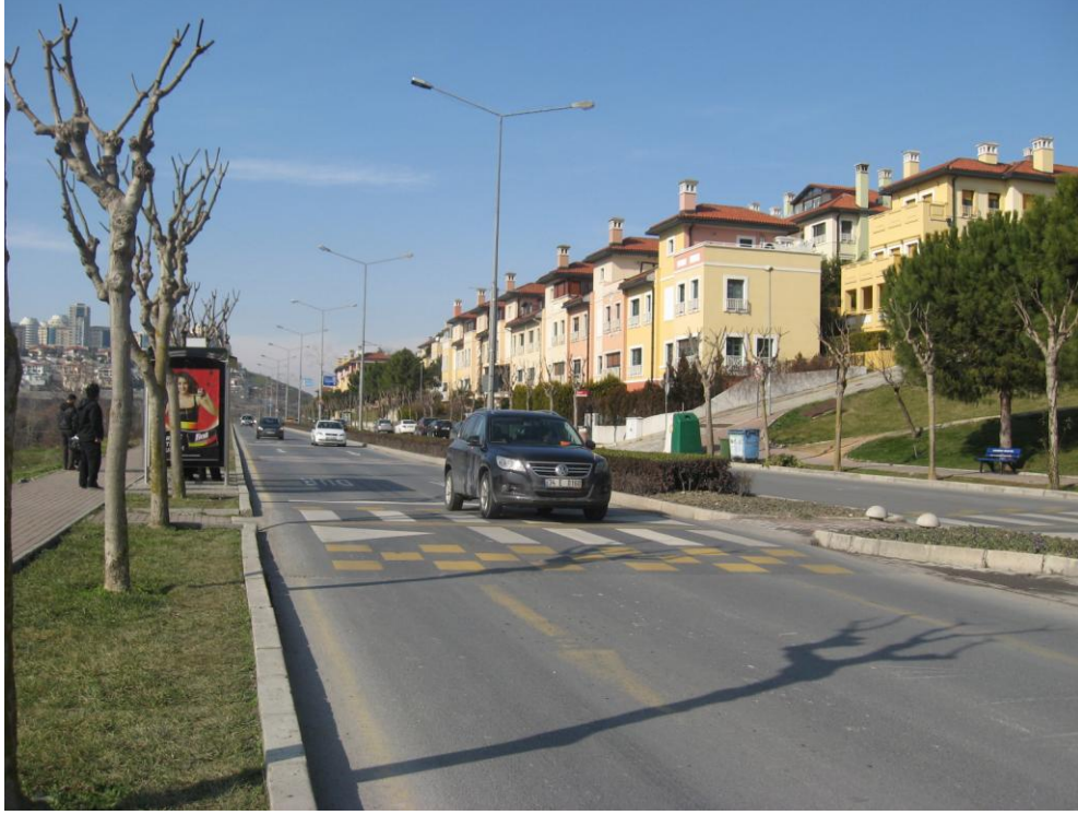
Şekil 5. 5 Bahçeşehir'i TEM Otoyolu'na bağlayan, Vali Recep Yazıcıoğlu Caddesi
