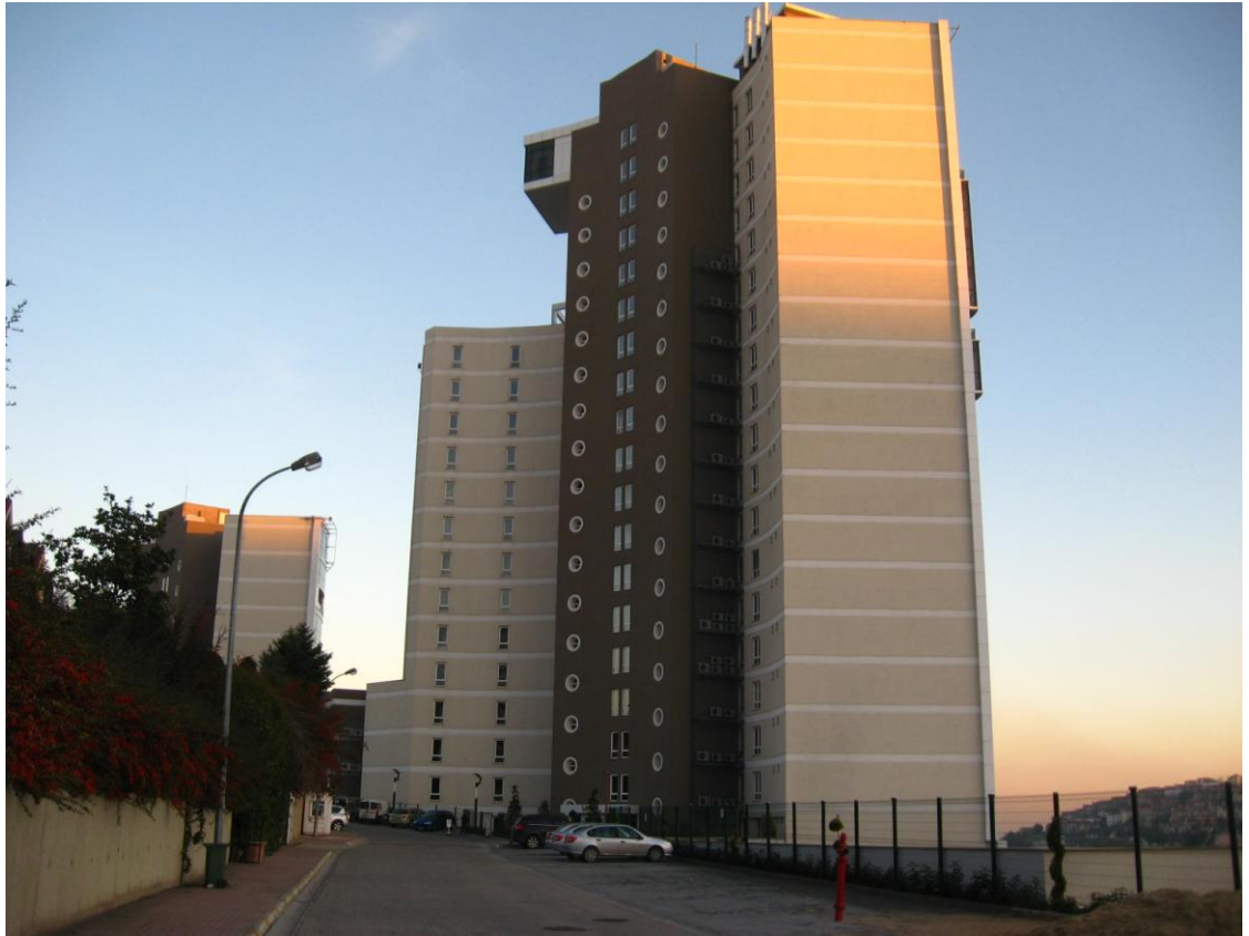
Şekil 5. 137 Loca'nın arka cephesi ve Posta Caddesi ile ilişkisi
