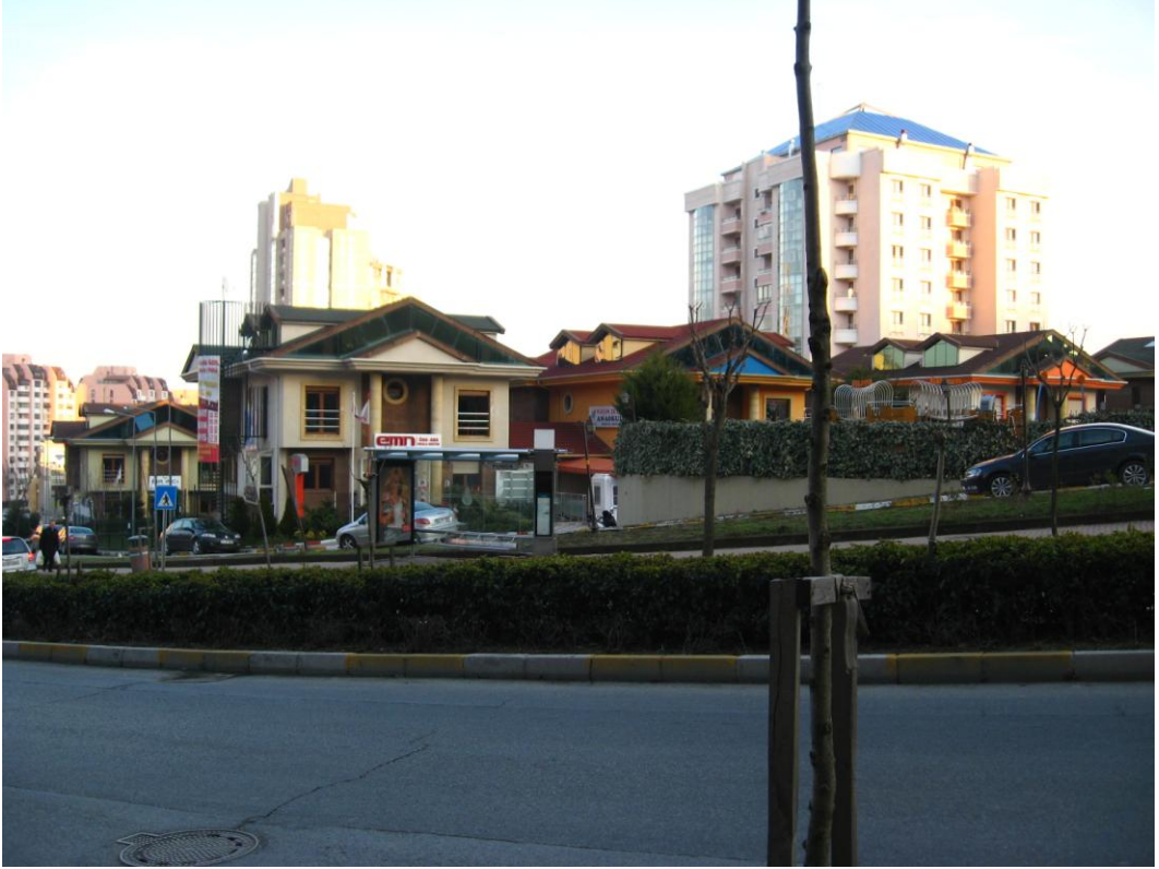
Şekil 5. 66 Ticari merkez/1 no.lu yapı adasının Ahmet Taner Kışlalı Bulvarı'ndan görünüşü
