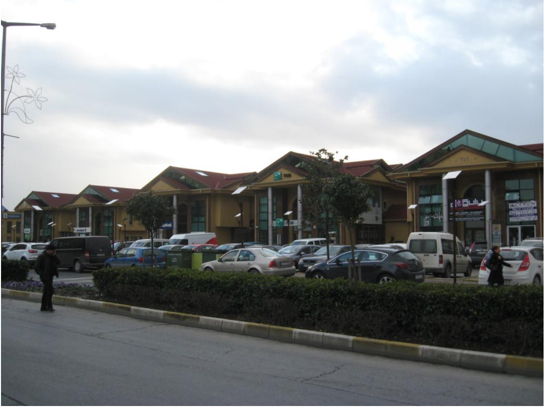
Şekil 5. 71 3 no.'lu yapı adasından görünüm
