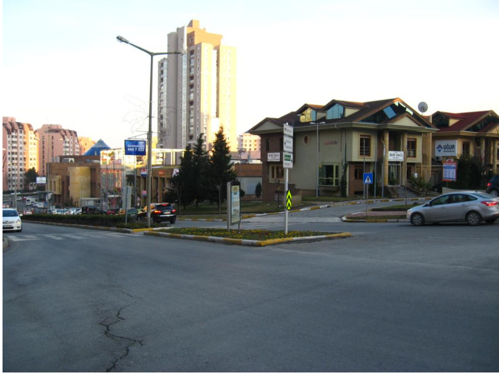
Şekil 5. 67 1 no.'lu yapı adasından görünüm
