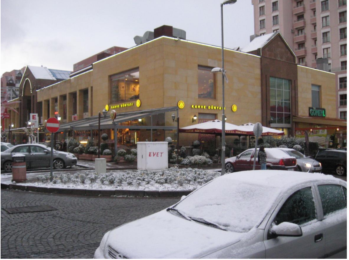
Şekil 5. 73 3 no.'lu yapı adasının güneybatısından görünüm
