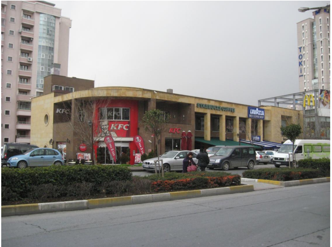
Şekil 5. 72 3 no.'lu yapı adasının Süzer Bulvarı'ndan görünüşü
