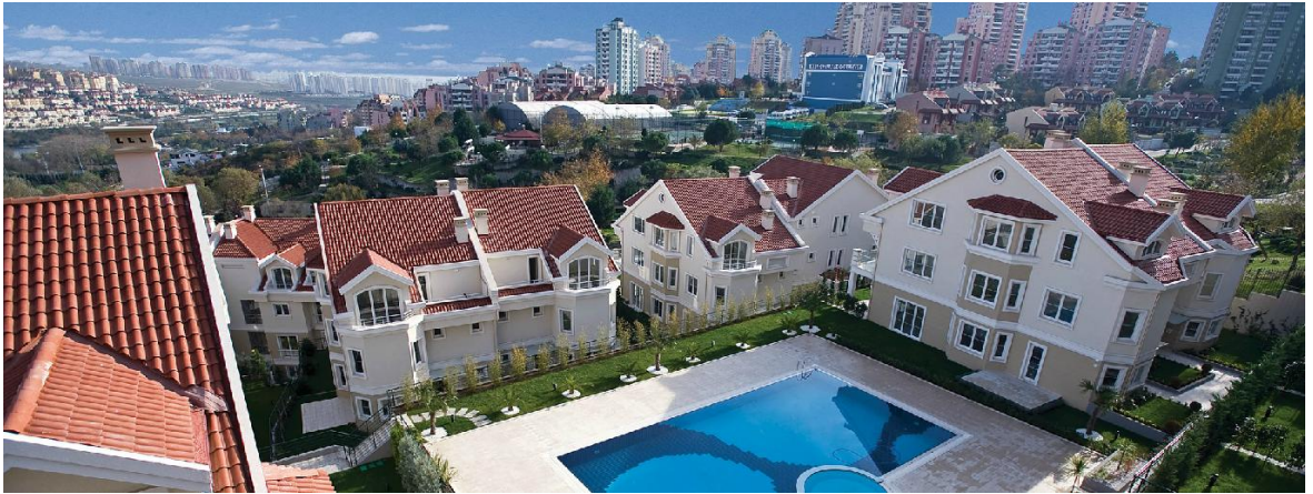
Şekil 5. 82 Saklı Bahçe Konakları'nın iç bahçesinden görüntü [47]
