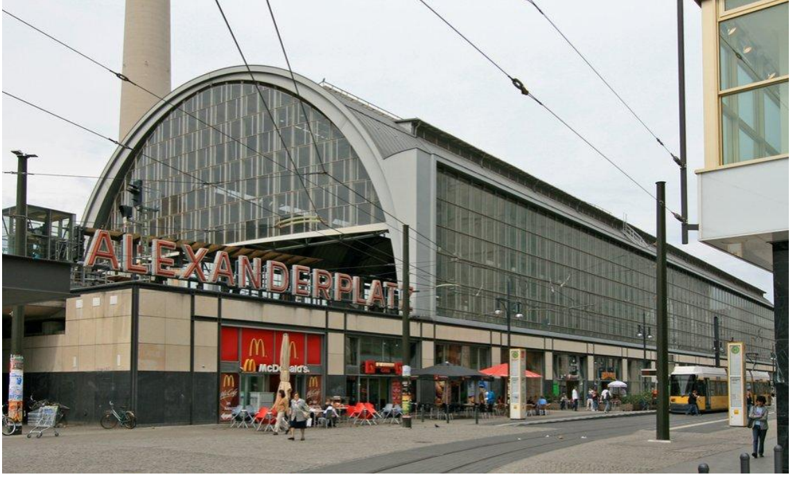
Şekil 5. 9 Alexanderplatz S-Bahn İstasyonu [79]
