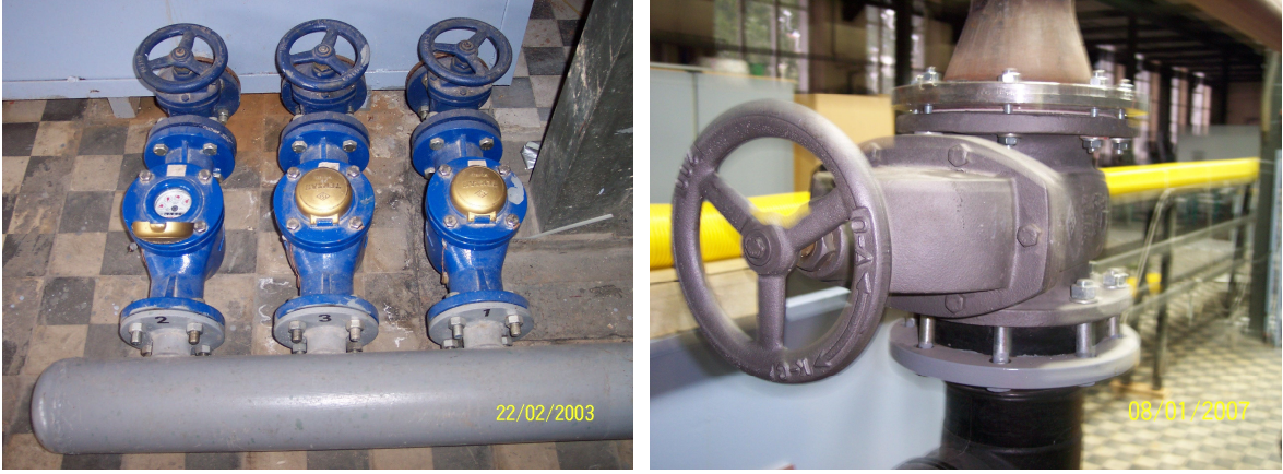
Şekil 4.3 Su sayaçları, kollektör ve debi ayar vanası resmi
