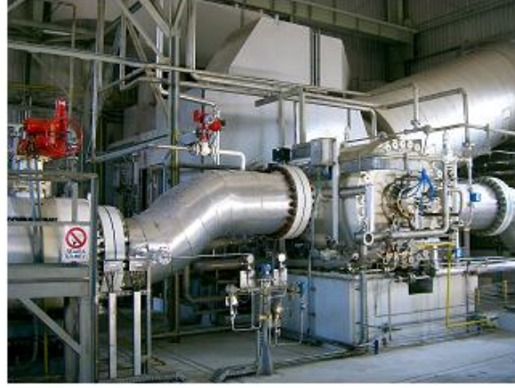
Şekil 3.1 Gaz türbini ve kompresör [21]
