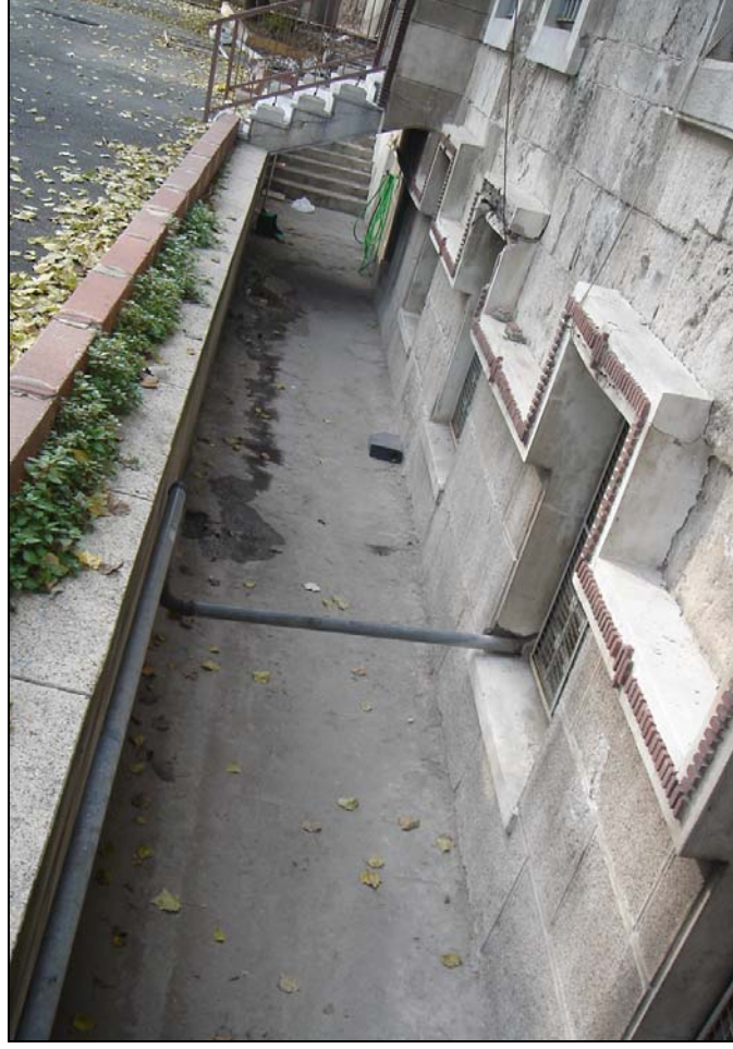
Şekil 15 Bodrum kat pencereleri ve önlerinde bulunan kuranglez
