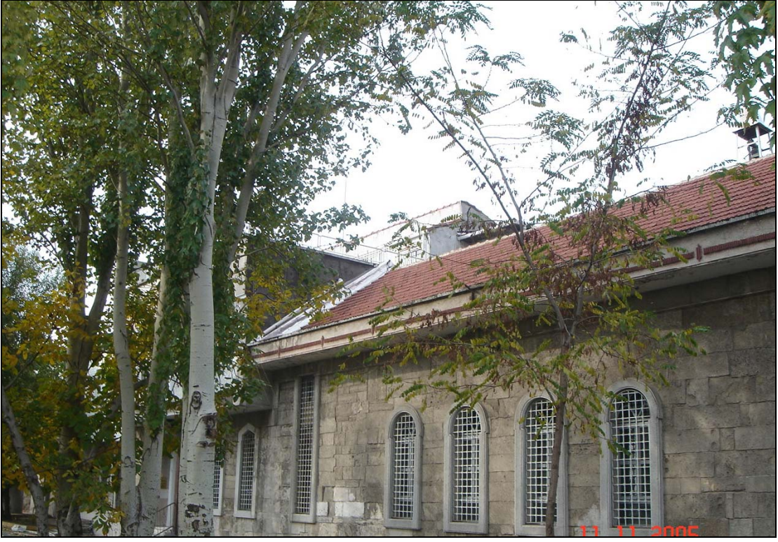
Şekil 3 Kilise ana mekanının pencereleri
