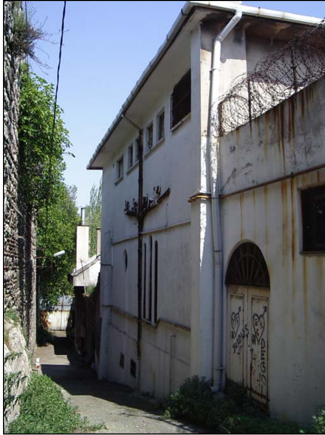
Şekil 20 Kilisenin batısına eklenmiş yapının arka cephesi
