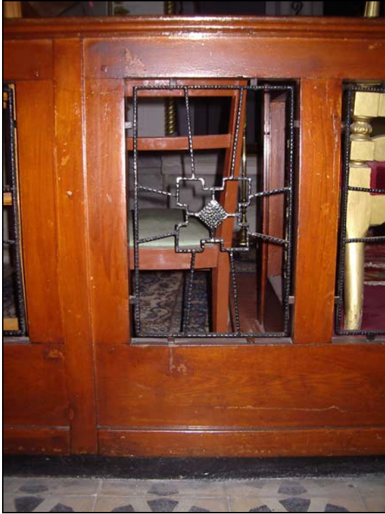
Şekil 48 Absidin önünde bulunan ahşap korkuluk
