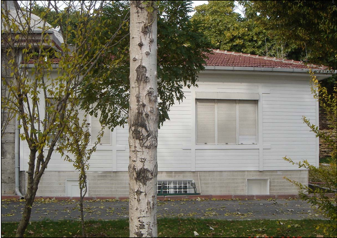
Şekil 8 Ana yapının doğusuna eklenmiş bina
