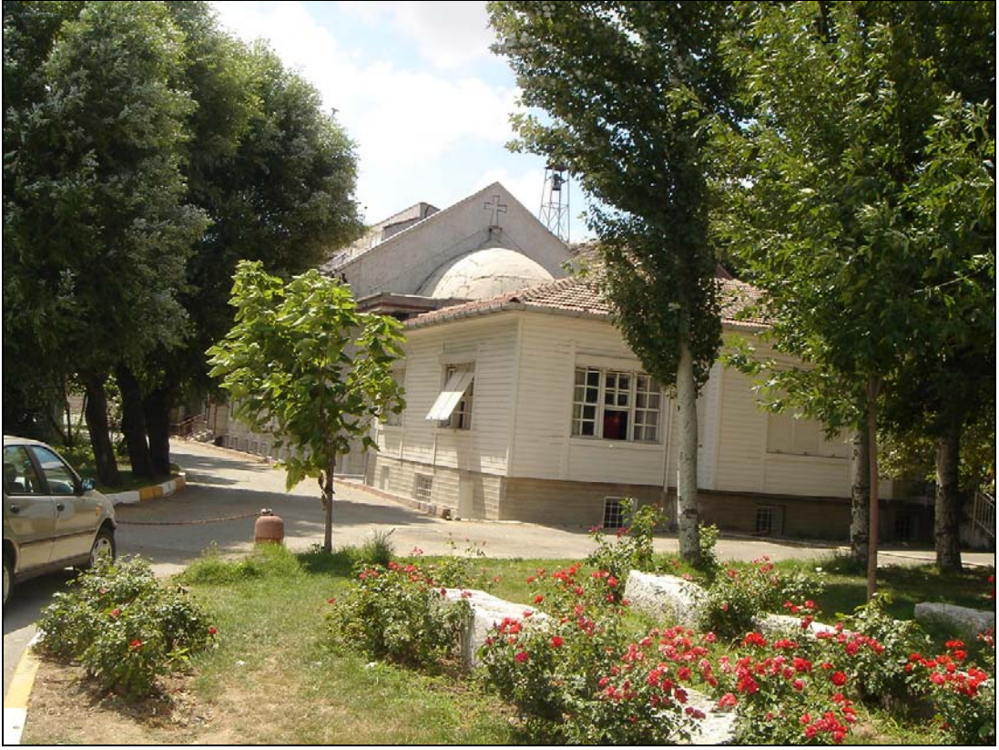
Şekil 1 Kiliseye güneydoğudan bakış
