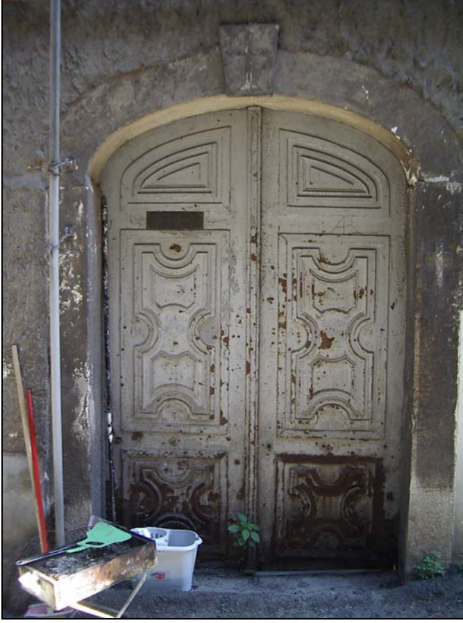
Şekil 21 Dışarıdan avlu kapısına bakış
