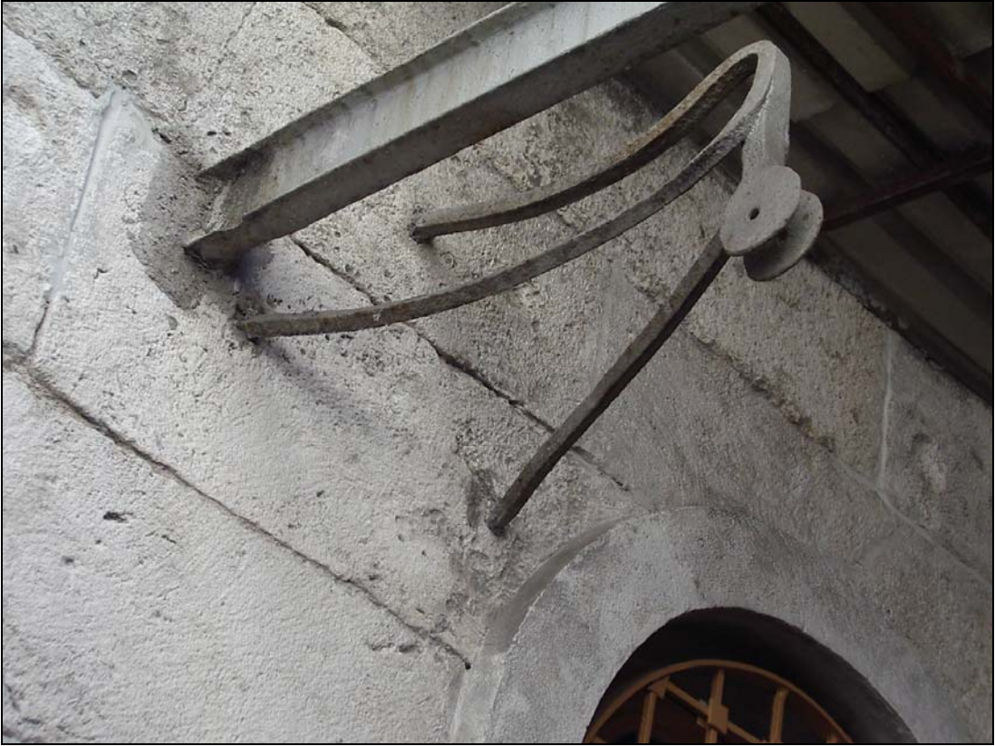
Şekil 26 Kuyudan su çekmeyi sağlayan mekanizma
