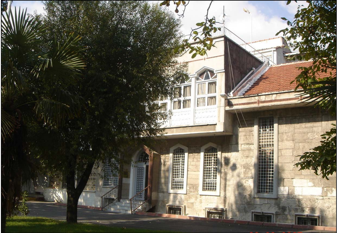
Şekil 4 Güney cepheden görünüş
