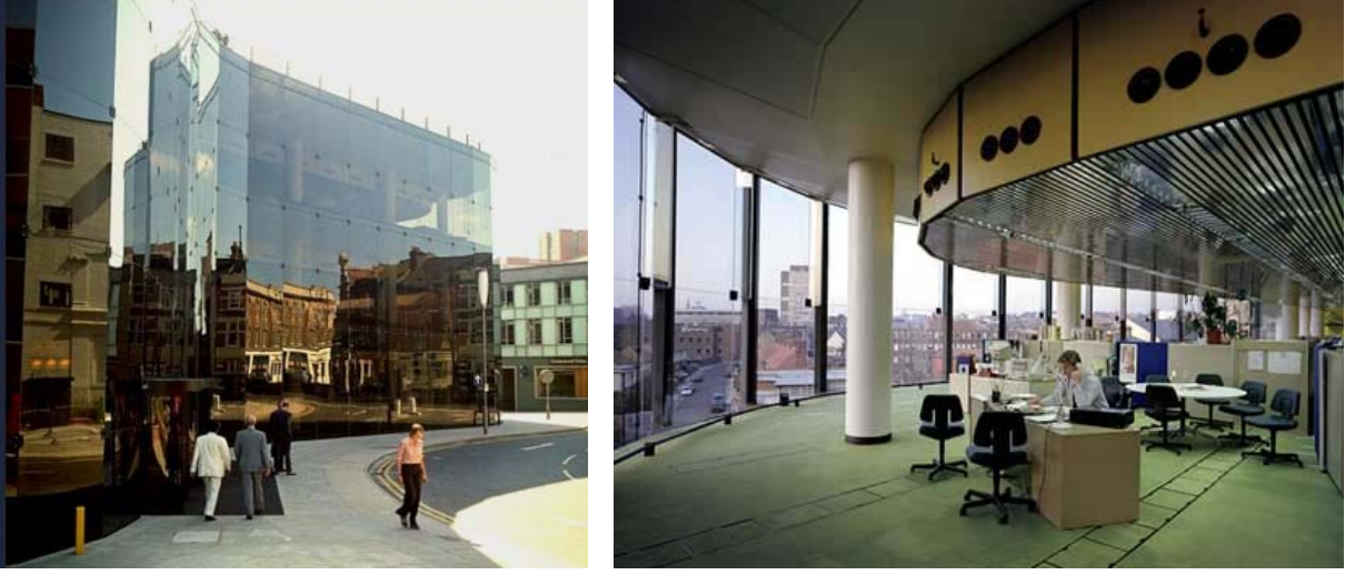
Şekil 4.1.1.9 Willis Faber & Dumas Ofis Binası, Norman Foster, 1970
