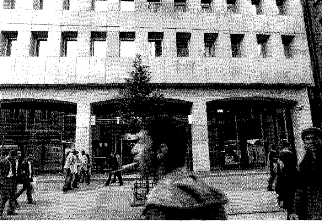
Resim 5.6. Tünel'e doğru giderken sağ kolda cephesi yenilenmiş bir bina.(fot: Ö.Orhun)
