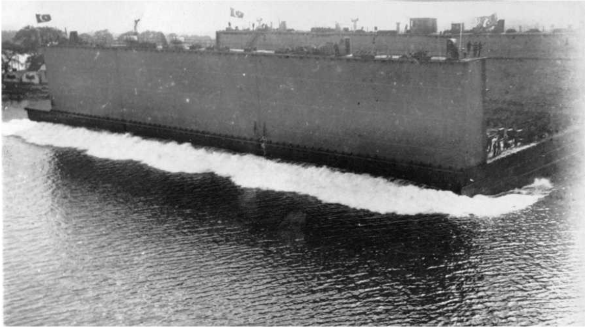
Şekil 7: Havuz İkinci Blok Denize İndirilişi (30 Ekim 1926)
