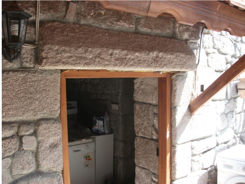
Kapı taş lento detayı
