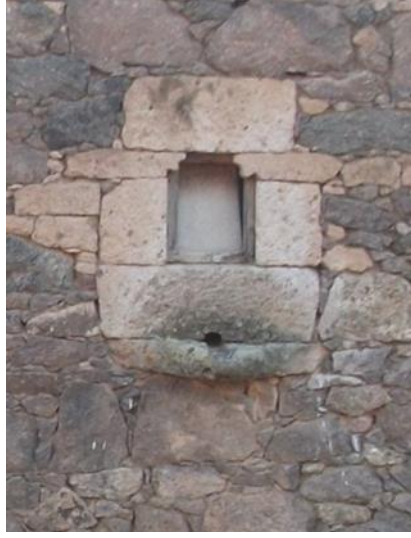
Şekil 4.25 Mehmet Gündüz ve Cahit Yılmaz evleri mazgal detayı
