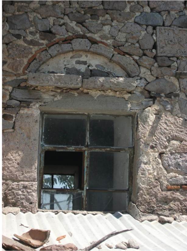
Pencere üstü kemer detayı
