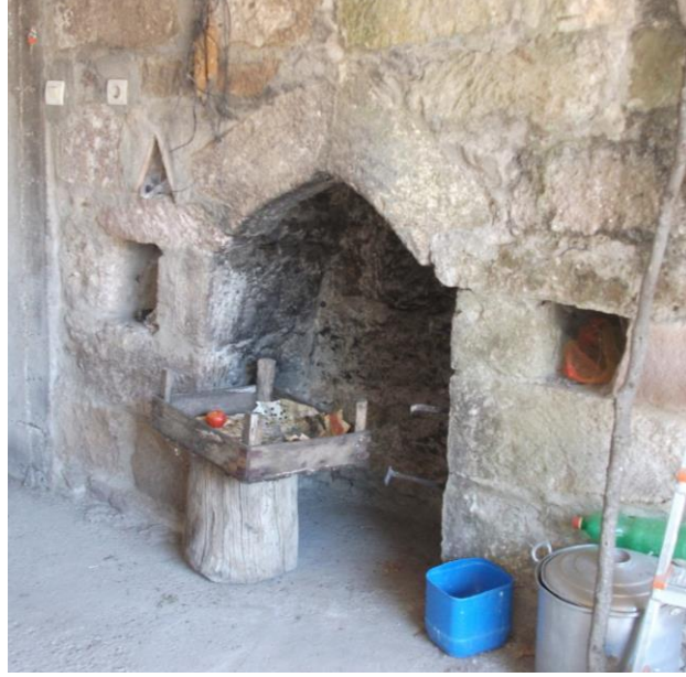
Şekil 3.7 Balabanlı Köyü'nden bahçeden ocak detayı
