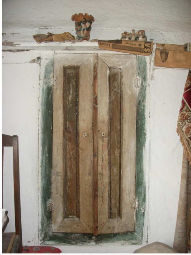
Deve hanı pencere iç görünüşü
