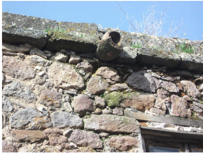
Şekil 3.296 Çüldürmek (çörten) detayı
