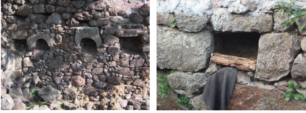
Şekil 3.8 Bahçe duvarlarındaki niş örnekleri
