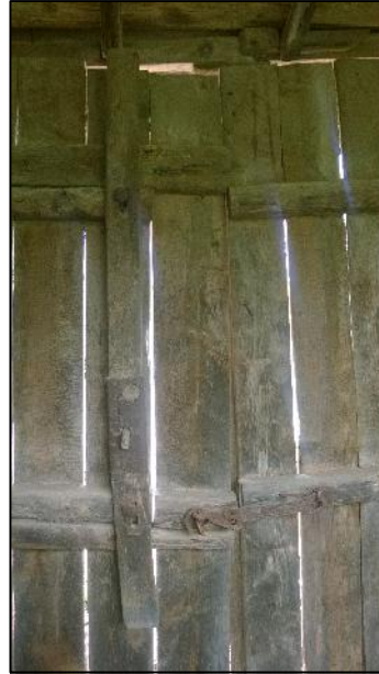
Bahçe kapısı kilit detayı
