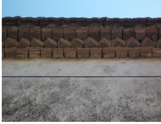
Şekil 4.18 Ali Kemal Yıldız evi saçak detayı
