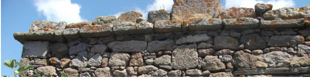
Şekil 3.293 Düz taşlardan elde edilen saçak detayı (katalog 21)
