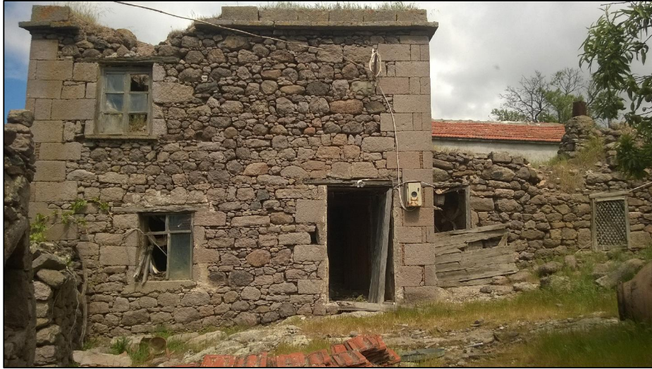
Şekil 3.252 110 no'lu ev genel görünüm
