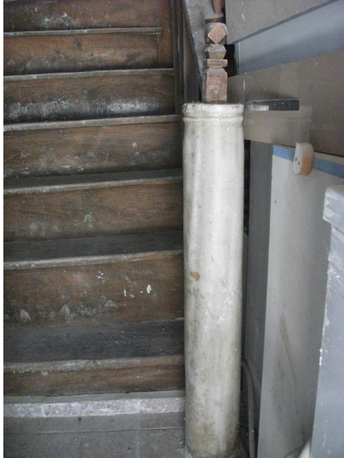
Devşirme taş merdiven korkuluęu detayı
