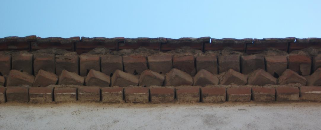
Şekil 3.293 Düz taşlardan elde edilen saçak detayı (katalog 21)
