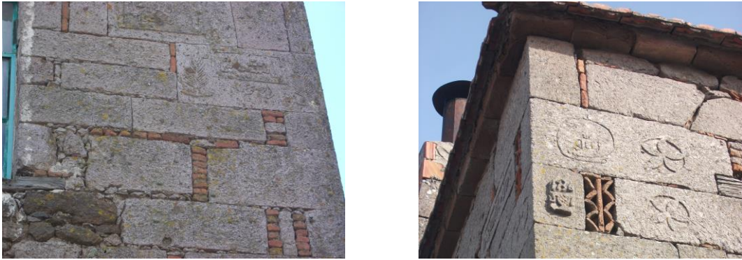
Şekil 3.285 Kırmızı tuğla ve kiremitten yapılan cephe süslemeleri (katalog 13)
