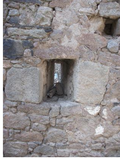
Şekil 4.25 Mehmet Gündüz ve Cahit Yılmaz evleri mazgal detayı
