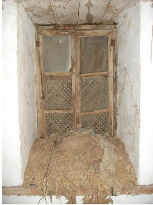
Güneş kırıcı ve kepenk
