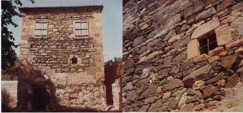
Şekil 4.25 Mehmet Gündüz ve Cahit Yılmaz evleri mazgal detayı
