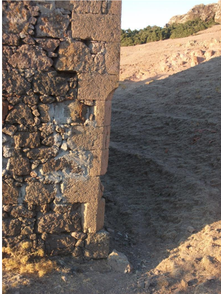
Şekil 3.288 Koyunevi Köyü'nden pahlanmış dirsek taşları (katalog 35)
