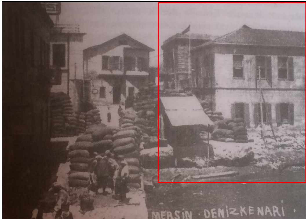
Şekil 3. 62 Mersin Posta Telgraf Binası, 1930 [38]
