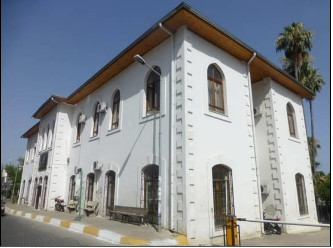
Şekil 3. 20 Anamur Hükümet Konağı, 2014
