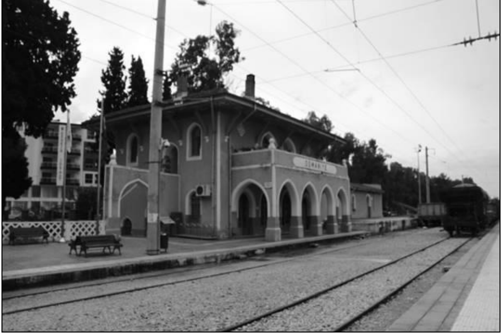
Şekil 3. 148 Osmaniye İstasyon Binası, 2015
