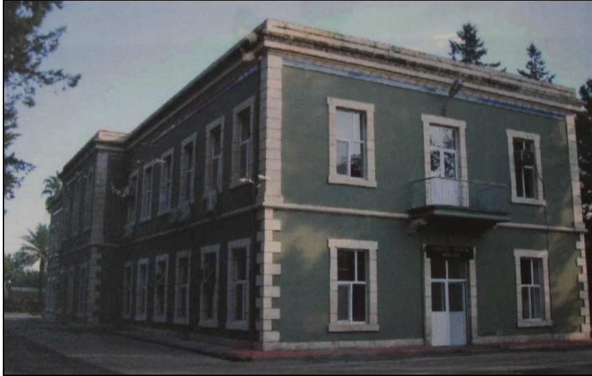
Şekil 3. 160 Adana Askeri Kışla Binası, 2007 [91]
