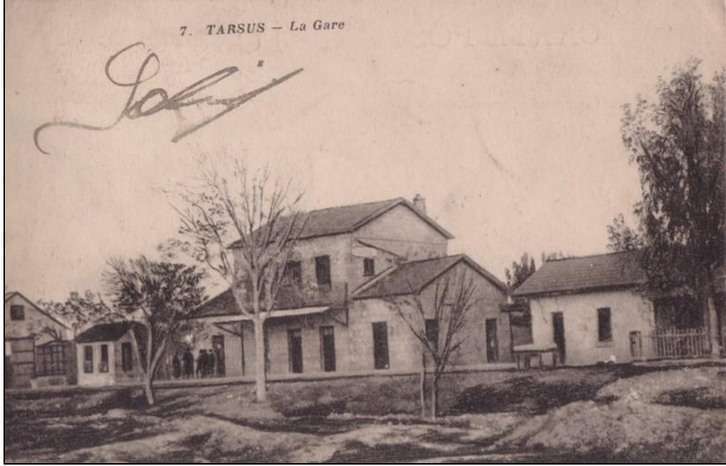
Şekil 3. 154 Tarsus İstasyon Binası 1
