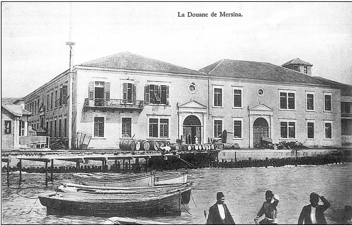
Şekil 3. 58 Mersin Gümrük Binası güney cephesi [24]
