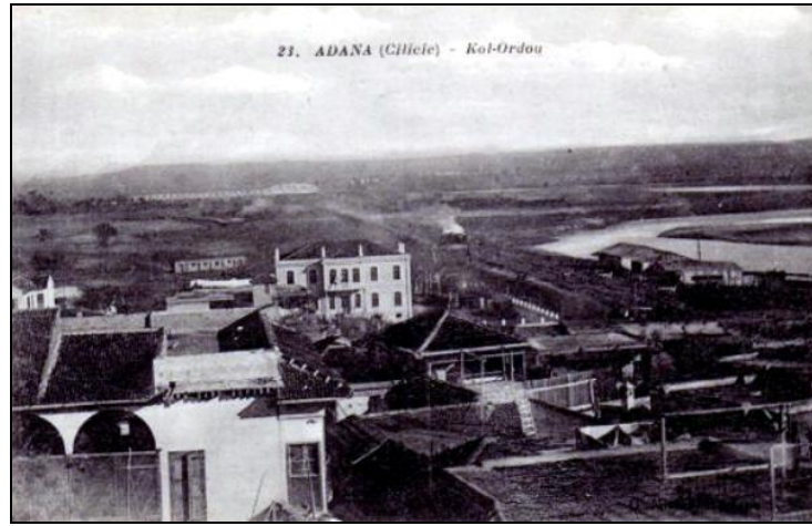
Şekil 3. 157 Adana Kolordu Binası, 1920 [89]
