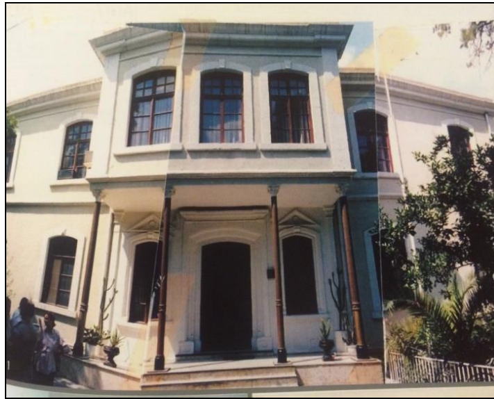
Şekil 3. 158 Adana Kolordu Binası [59]
