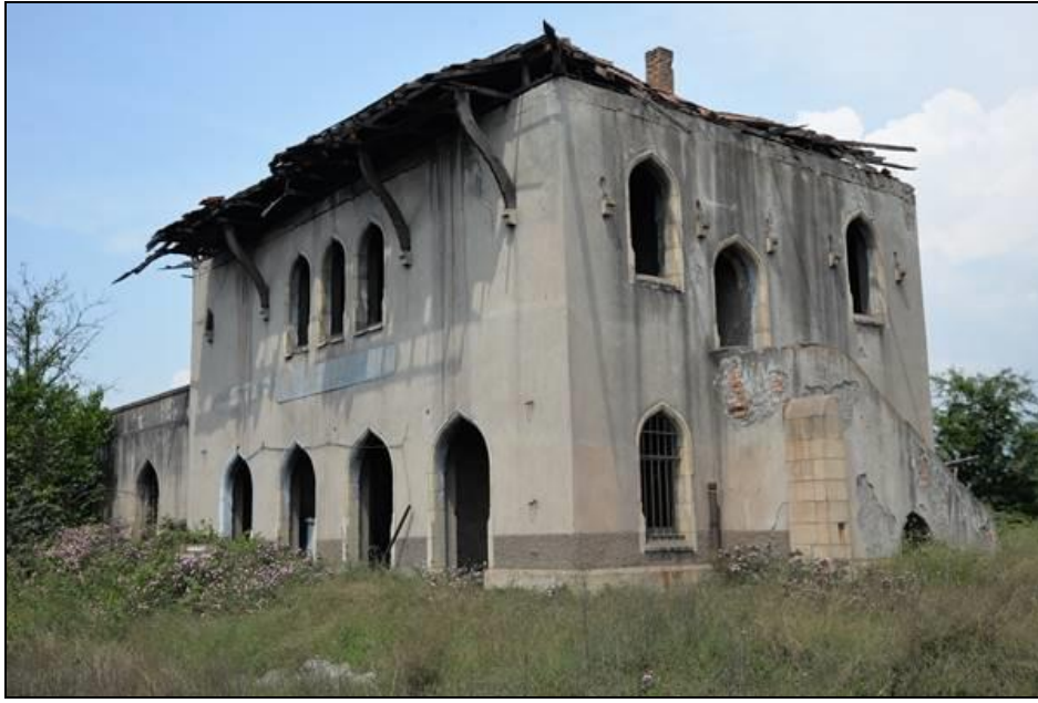
Şekil 3. 150 Payas İstasyon Binası, 2015
