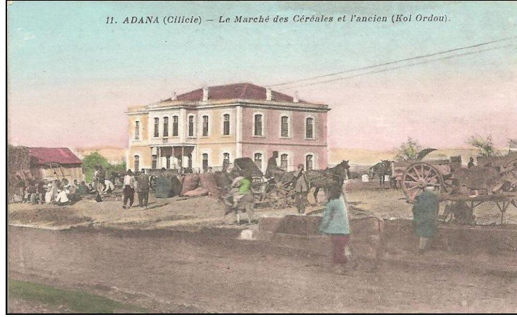
Şekil 3. 156 Adana Kolordu Binası [18]
