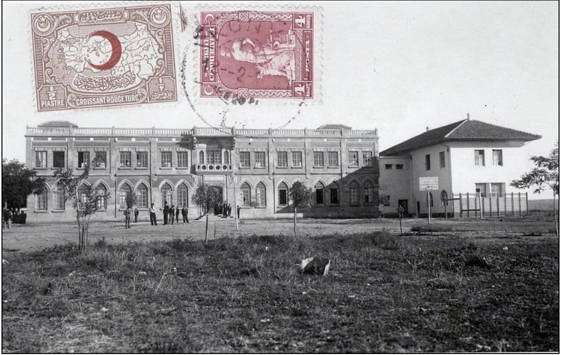
Şekil 3. 85 Adana Darüleytamı'nın kütüphane-yatakhane-yemekhane binası 1
