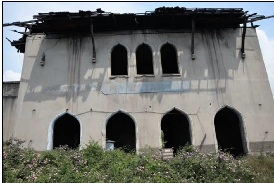
Şekil 3. 151 Payas İstasyon Binası, 2015
