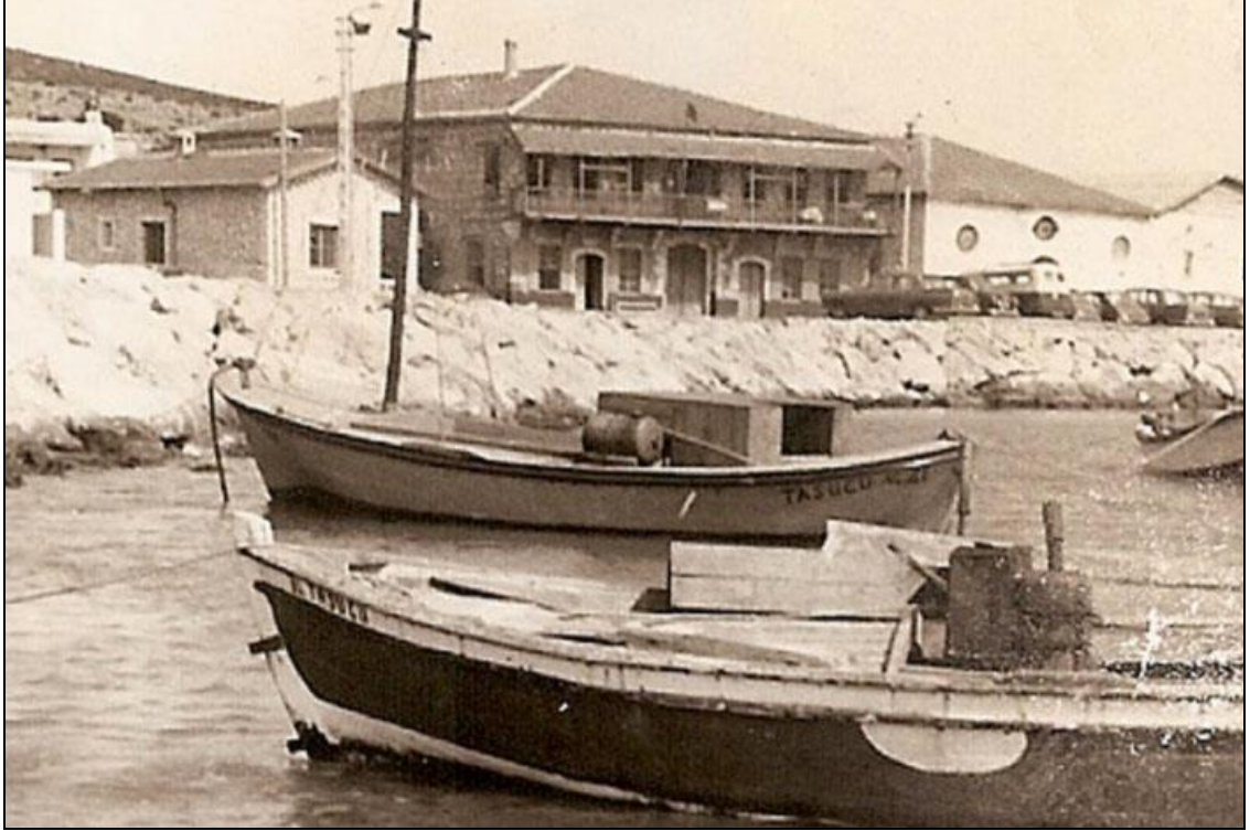
Şekil 3. 50 Taşucu Gümrük Binası 1
