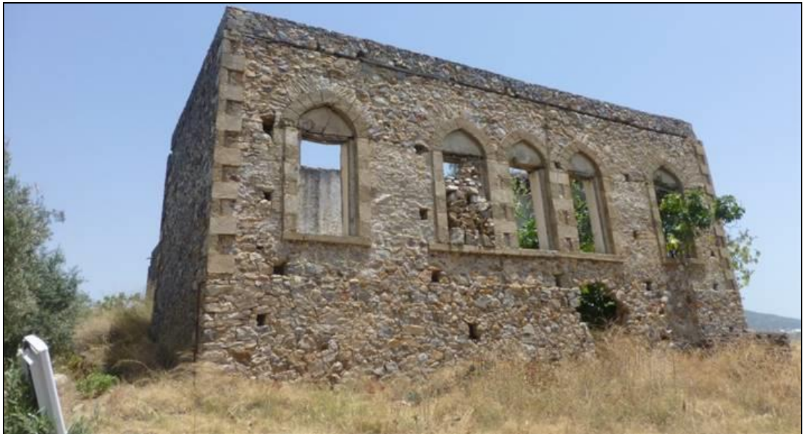
Şekil 3. 119 Anamur Ferizler Köy Okulu Sol Yan Cephe, 2014
