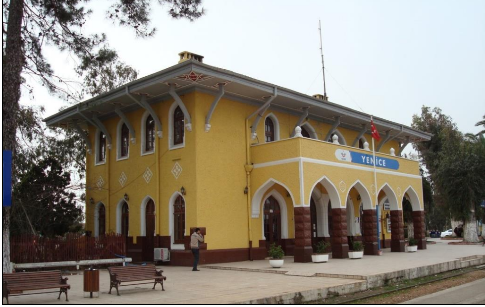
Şekil 3. 136 Adana Yenice İstasyon Binası, 2014
