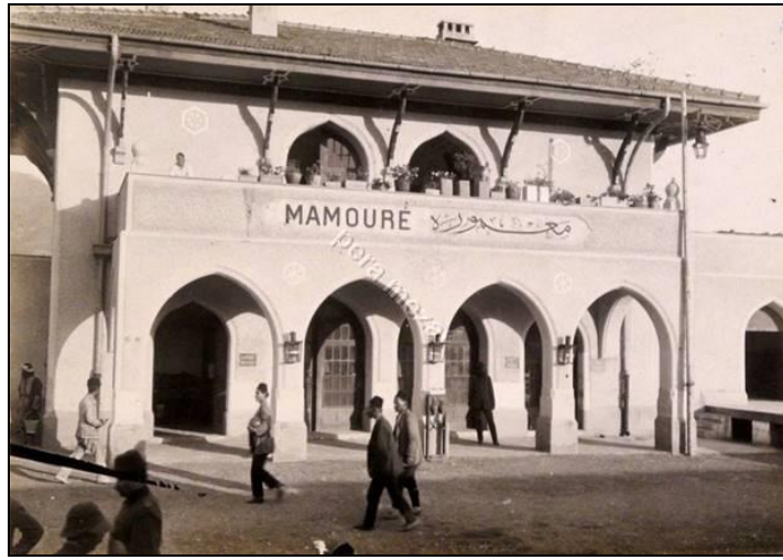
Şekil 3. 146 Mamure İstasyon Binası 1
