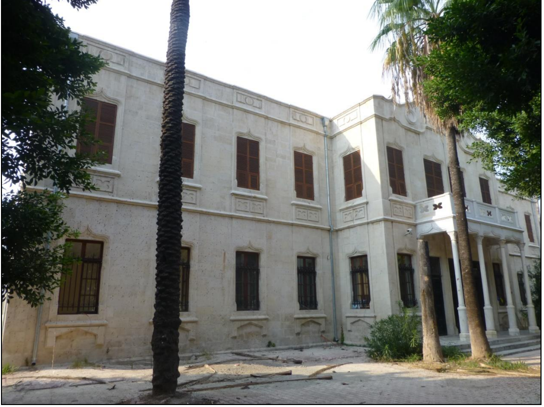
Şekil 3. 12 Mersin Hükümet Konağı, 2014
