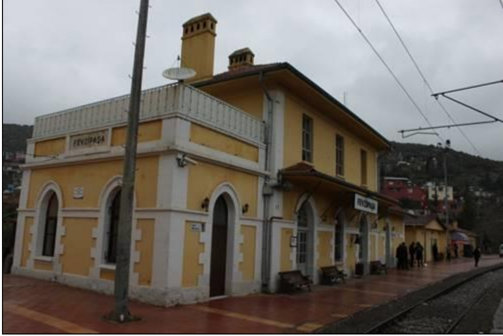
Şekil 3. 153 Fevzipaşa İstasyon Binası, 2015
