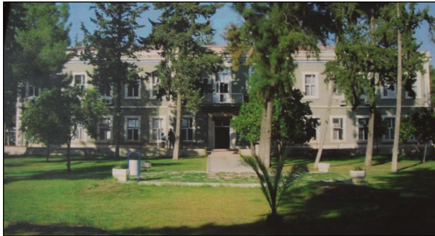
Şekil 3. 161 Adana Askeri Kışla Binası, 2007 [91]
