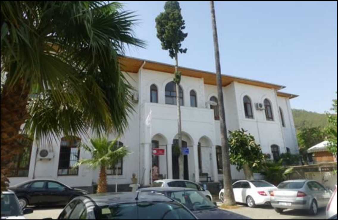
Şekil 3. 21 Anamur Hükümet Konağı, 2014
