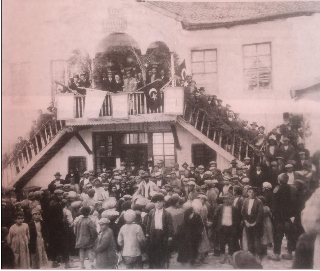
Şekil 3. 48 Ermenek Belediye Binası, 1934 [49]
