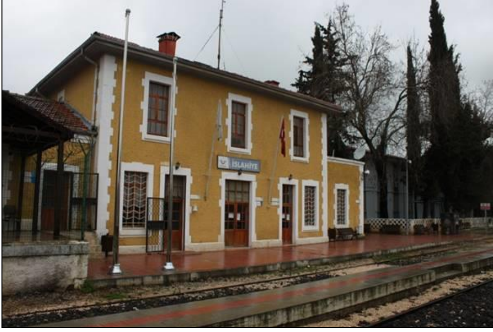
Şekil 3. 152 İslahiye İstasyon Binası, 2015
