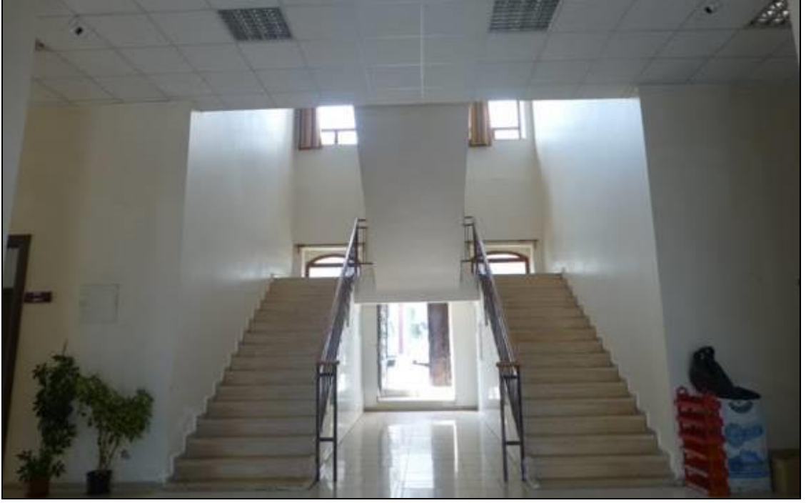
Şekil 3. 22 Anamur Hükümet Konağı, 2014
