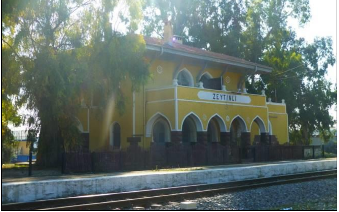
Şekil 3. 135 Adana Zeytinli İstasyon Binası, 2014
