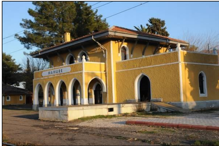
Şekil 3. 147 Mamure İstasyon Binası
