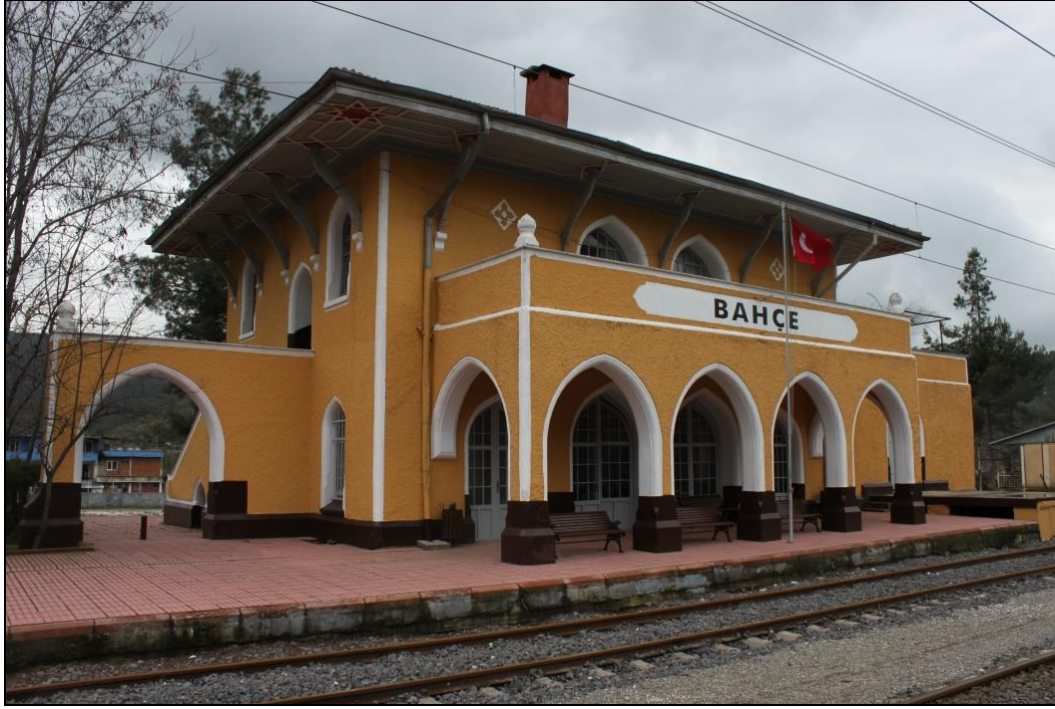
Şekil 3. 144 Bahçe İstasyon Binası, 2015
