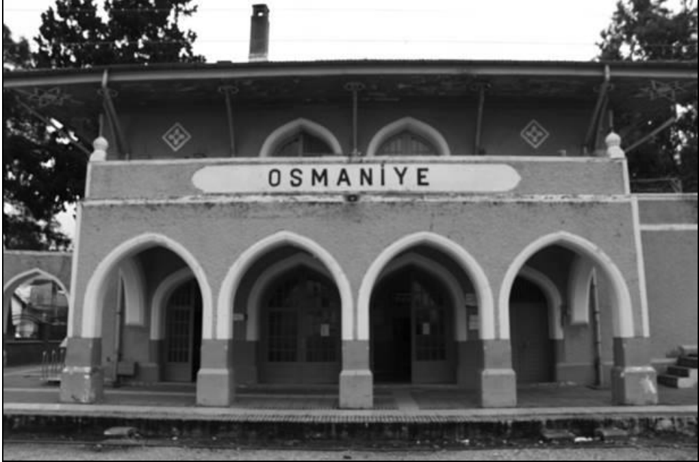
Şekil 3. 149 Osmaniye İstasyon Binası, 2015
