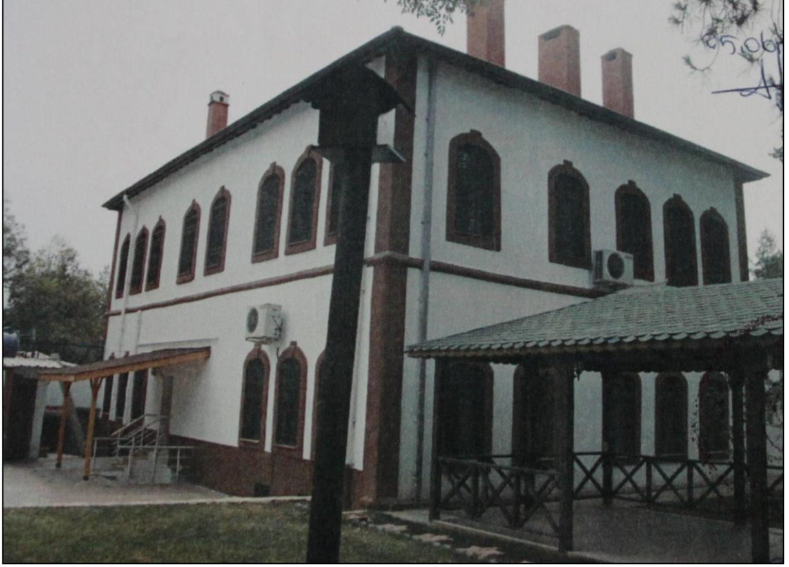
Şekil 3. 24 Hassa Hükümet Konağı, 2014 [40]
