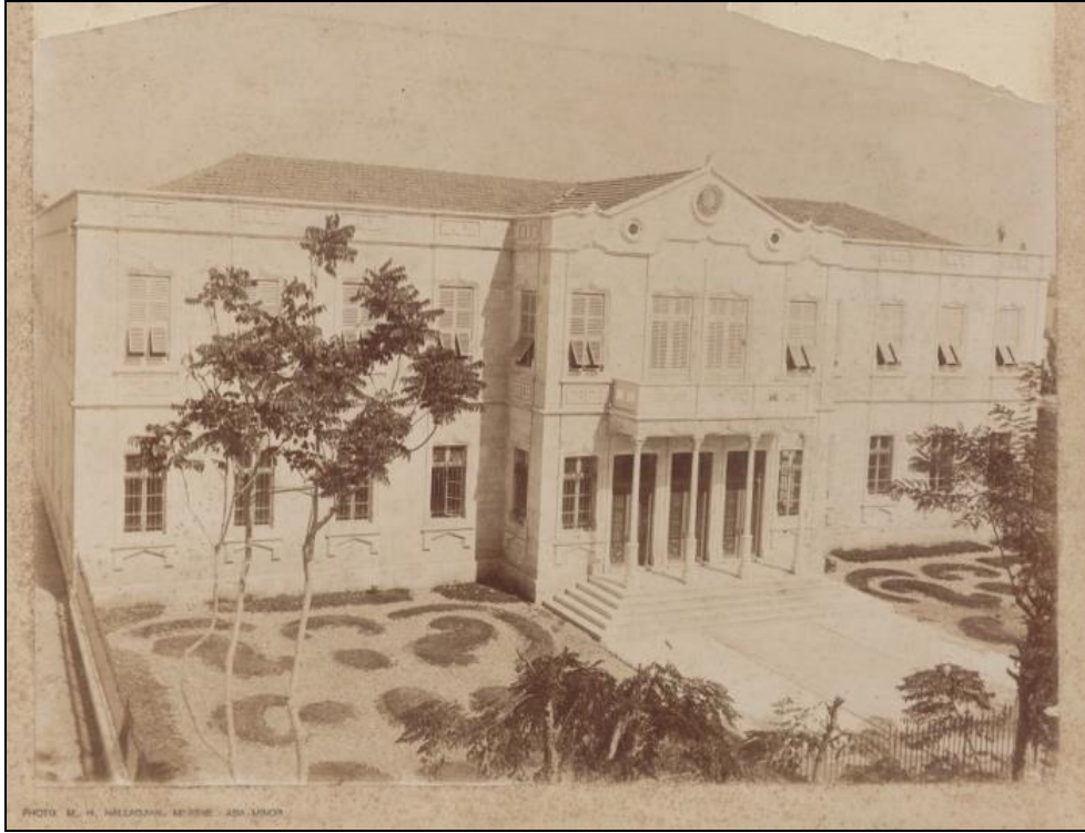
Şekil 3. 10 Mersin Hükümet Konağı 1
