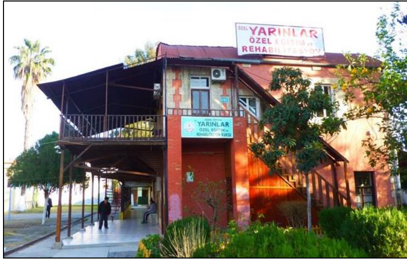
Şekil 3. 134 Adana Eski İstasyon Binası, 2014
