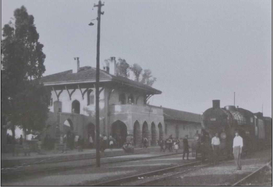
Şekil 3. 142 Ceyhan İstasyon Binası 1
