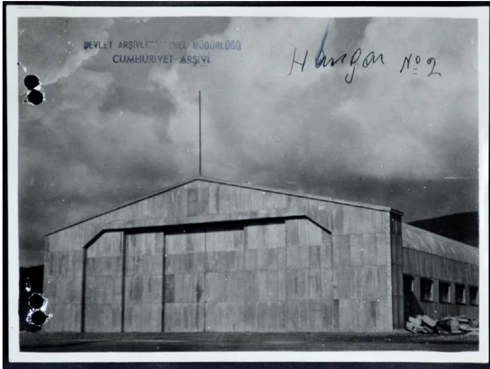
Şekil 4.141 AEI hangar no:2 binası [296]
