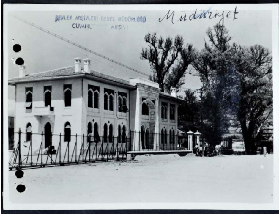
Şekil 4.132 AEI müdüriyet / ana terminal binası görünüşü [296]
