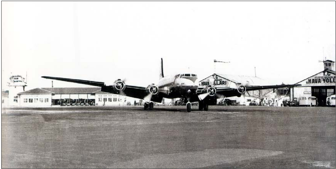
Şekil 4.196 1942 yılında inşa edilen Yeşilköy Terminal Binası ve 1926 yılında inşa edilen hangarlar. Yeşilköy Hava Meydanı, 1950-1951 [169]
