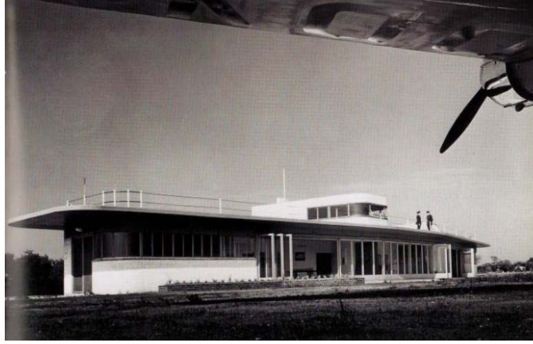
Şekil 2.126 Ramsgate Aerodrome, 1936-37; bina ve uçağın mükemmel harmonisi, tasarım: David Pleydell-Bouverie [73]
