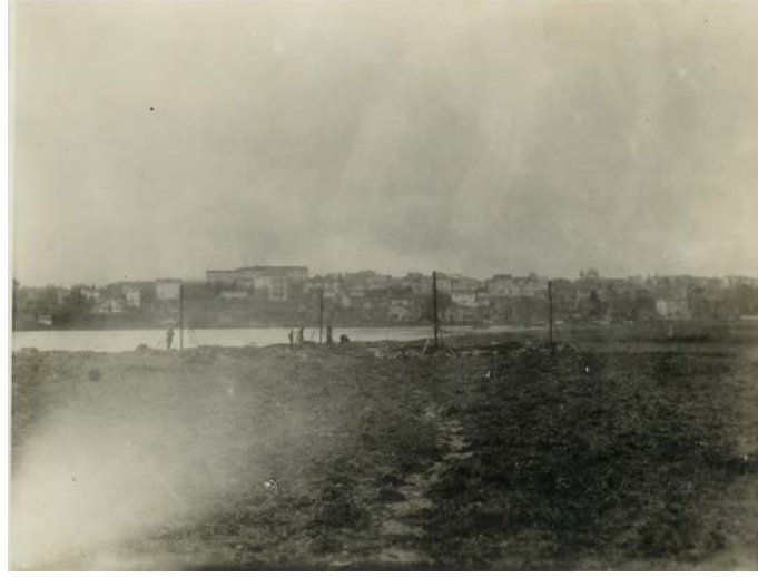
Şekil 4.226 Vecihi Hürkuş'un Kadıköy İstanbul'daki hangar yapısının yapımındaki dört direk [325]
