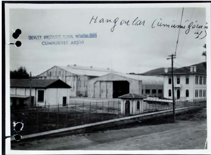
Şekil 4.139 AEI hangarları, genel görünüş [296]
