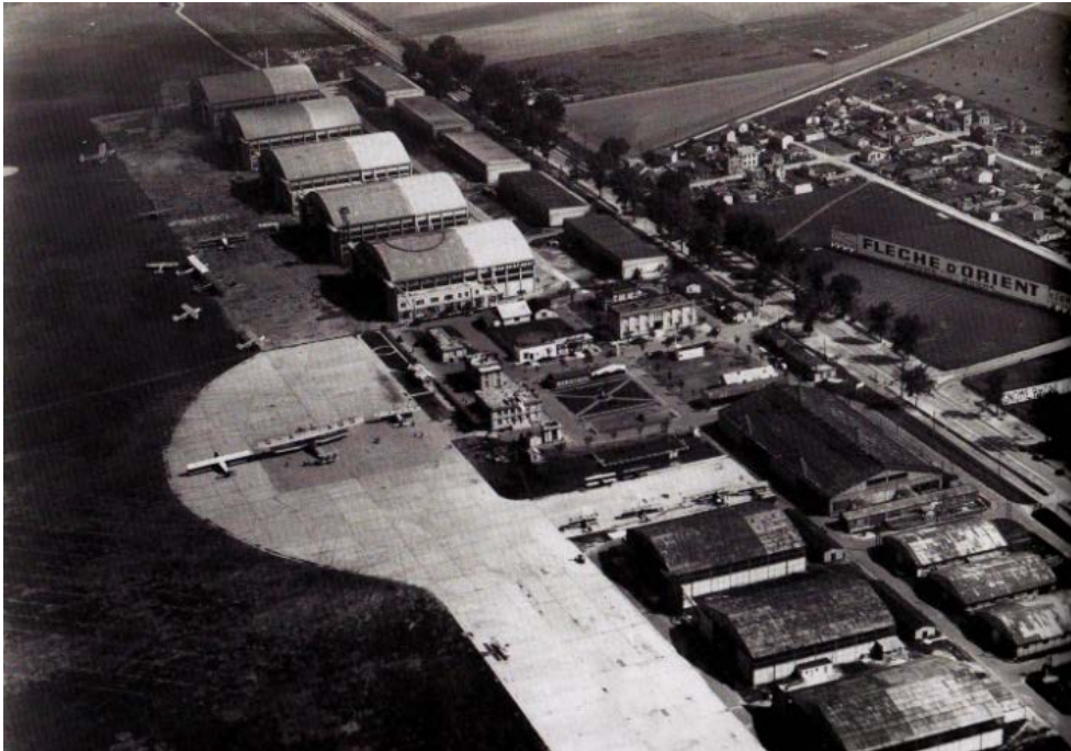
Şekil 2.114 Terminal nerede? Paris Le Bourget, 1920'lerde çevresindeki küçük binalardan oluşuyordu [73]
