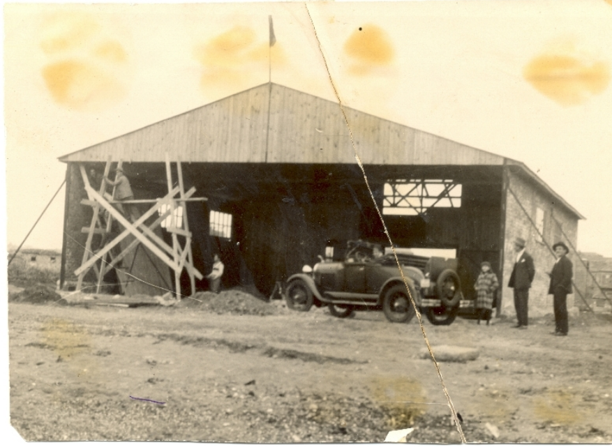
Şekil 4.227 Vecihi Hürkuş'un Kadıköy İstanbul'daki hangarın yapım sırasında [325]
