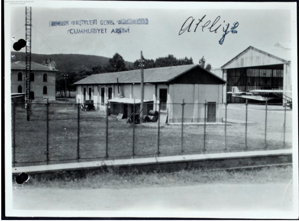
Şekil 4.152 Muhtelif servislerin bulunduğu binanın görünüşü [296]
