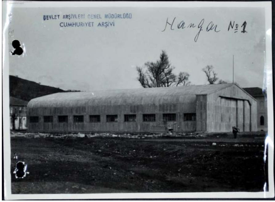
Şekil 4.140 AEI hangar no:1 binası [296]
