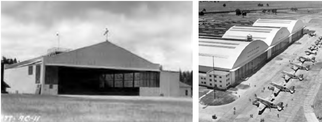
Şekil 2.75 ve Şekil 2.76 Fort Lewis'de inşa edilen hangar, Washington, 1930 [121]; Üç-kemerli hangar, McClellan, geç 1930'lar [121]
