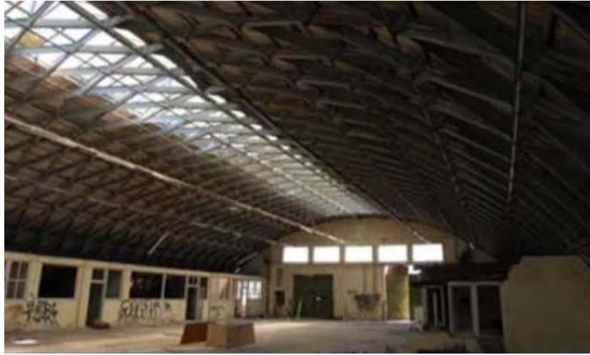
Şekil 4.96 Junkalorhalle, Dessau, Almanya, 1929'da yapılmıştır; resimde 2008'deki durumu görülmektedir [139]
