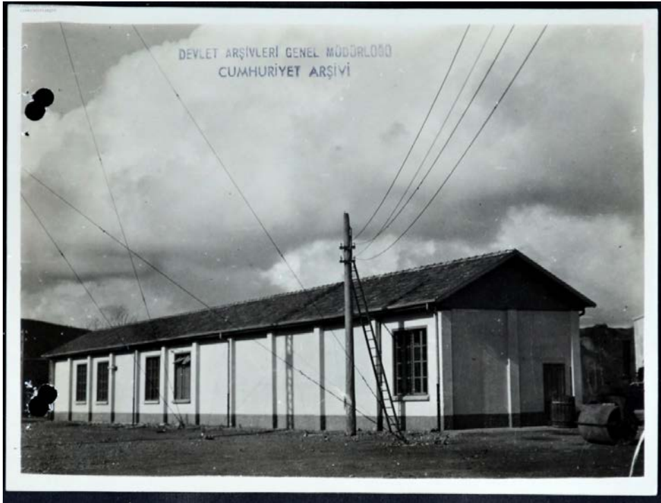
Şekil 4.153 Muhtelif servislerin bulunduğu binanın görünüşü [296]
