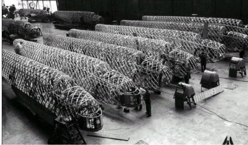
Şekil 2.87 Vickers'ın Wellington üretim hattı, 1940. Uçak gövdelerinin kafesli yapısı açıkça görülmektedir [132]
