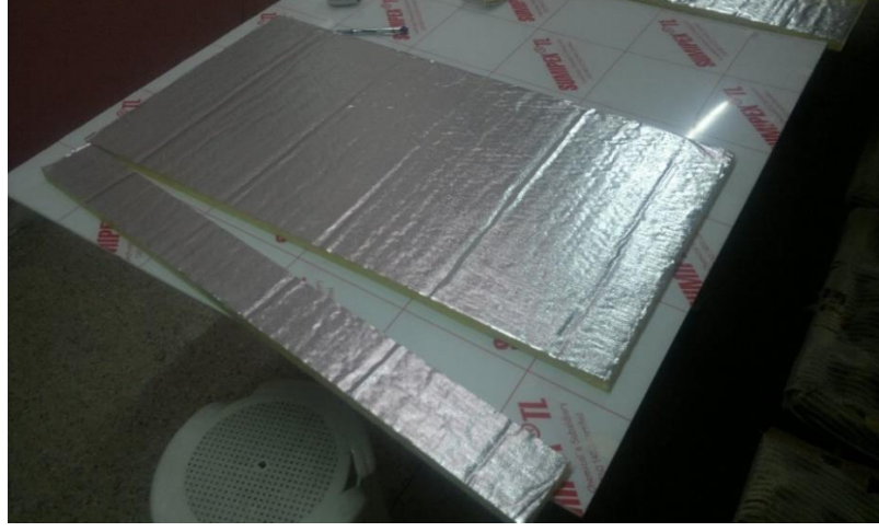
Şekil 3.10 Cam Yününün uygun ölçülerde kesilmesi işlemi
