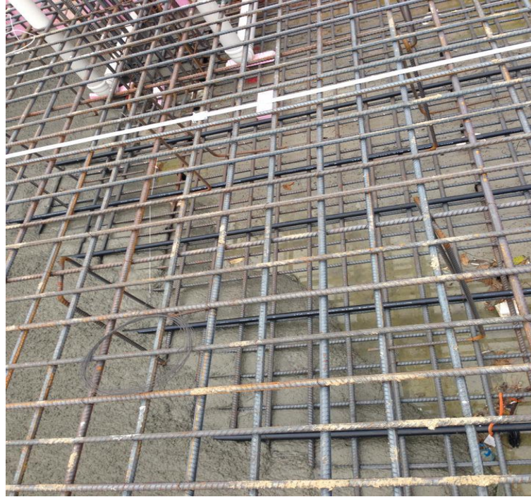
Şekil 5. 14 Donatılı beton atılırken boruların görünümü
