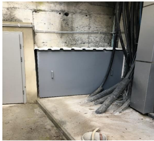
Şekil 5. 26 Kolektörlerin etrafının sac levhalarla kapatılması
