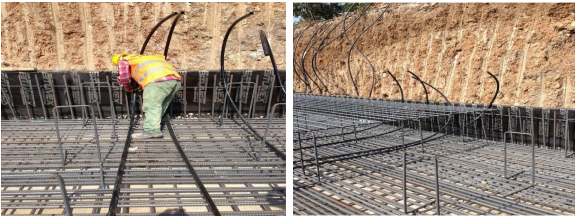
Şekil 5. 11 Toprak hattına ait ısıl çift yerleşimi
