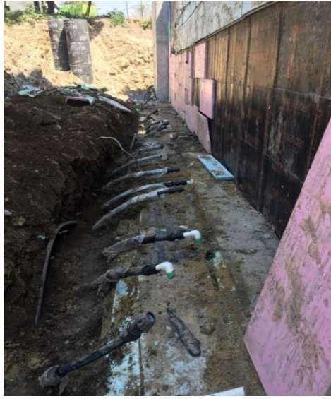
Şekil 5. 19 Bina ana giriş kapısının olduğu bölümde Toprak ve Beton hatlarının görünümü
