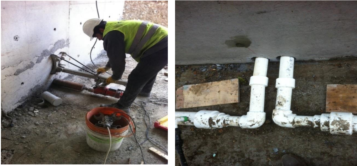
Şekil 5. 18 Karot delinmesi ve boruların bina içine alınması
