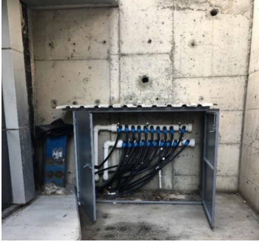
Şekil 5. 26 Kolektörlerin etrafının sac levhalarla kapatılması
