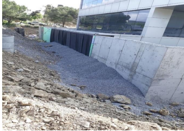
Şekil 5. 22 Bina ana giriş kapısının olduğu bölümde Toprak ve Beton hatlarının üzerlerinin küçük çaplı mekanik malzeme kapatılması
