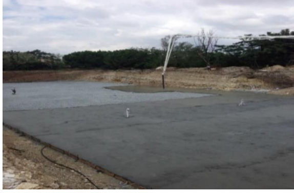
Şekil 5. 10 Grobeton dökülürken alanın görünümü
