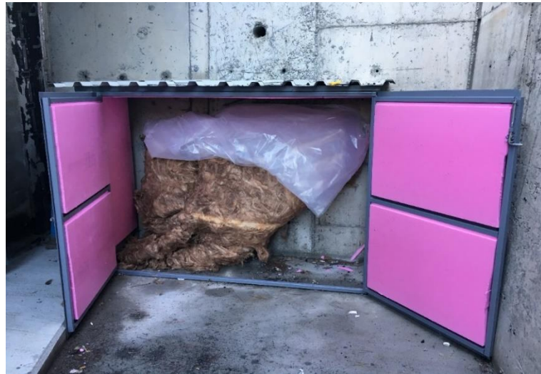
Şekil 5. 27 Kolektörlere ait izolasyon çalışmasının görünümü
