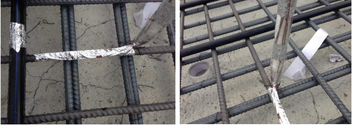
Şekil 5. 13 Beton hattı uygulamasında ısı çiftlerin bağlanması
