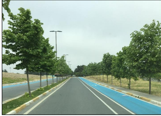
Şekil 3.21 Davutpaşa Kampüsü kaldırım ve araç yolu
