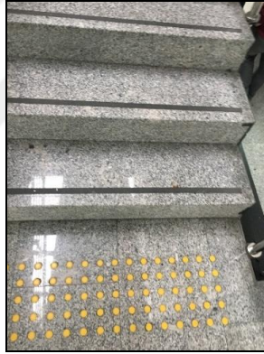
Şekil 3.36 Elektrik Elektronik Fakültesi merdiven başlangıcı
