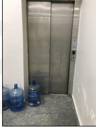
Şekil 3.47 Yemekhane Binası asansör
