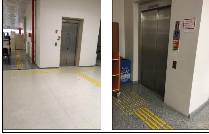
Şekil 3.44 Kütüphane Binası asansör
