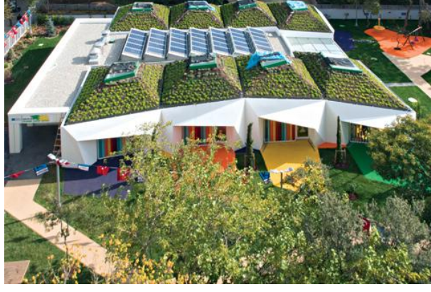
Şekil 2. 20 Bahriye Üçok Anaokulu çatı görünümü
