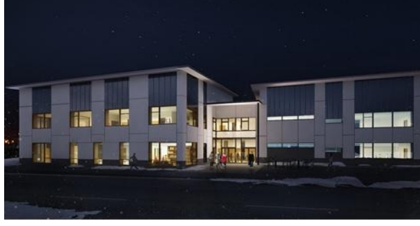
Şekil 2. 10 Klagshamn School cephe düzeni görünümü
