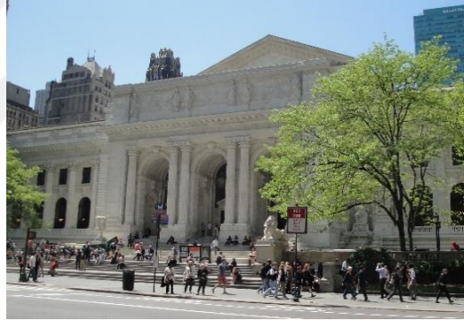
Şekil 3. 23 New York Halk Kütüphanesi binasının ön cephesi (Anonim, 2011)
