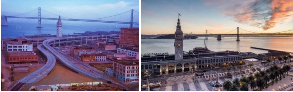
Şekil 2. 7 San Francisco Embarcadero Otoyolu inşa edildiği dönemde oluşan köprü altı mekânları ve fiziksel kopukluklar (Futurecapetown, 2012)
