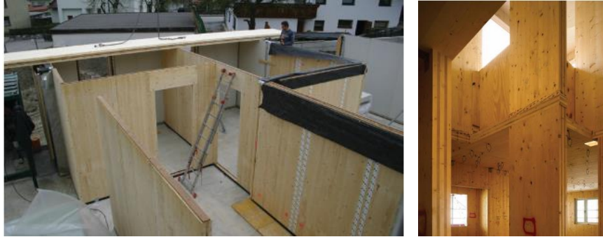
Şekil 3.1 CLT paneller ile platform çerçeve sistemin oluşturulması [1,106]
