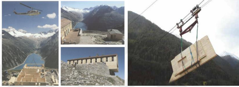
Şekil 2.16 CLT panellerin helikopter ve teleferik ile taşınması [2,85]
