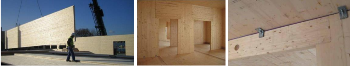
Şekil 3.3 Tek parça ve parçalı CLT duvar panelleri [2,106]
