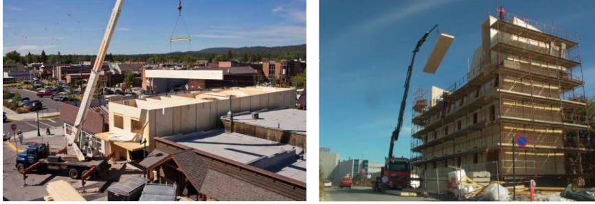
Şekil 2.3 CLT panellerin vinç ile uygulama yerine taşınması [2, 26]
