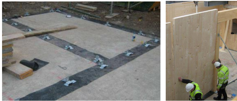
Şekil 3.2 CLT duvar panellerinin yerleşimi ve yalıtım uygulaması [106]
