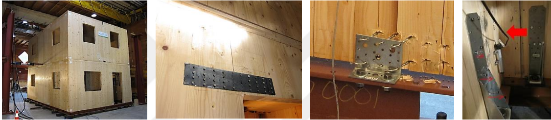
Şekil 4.35 CLT panel yapı ve birleşimlerindeki hasar oluşumları [166]
