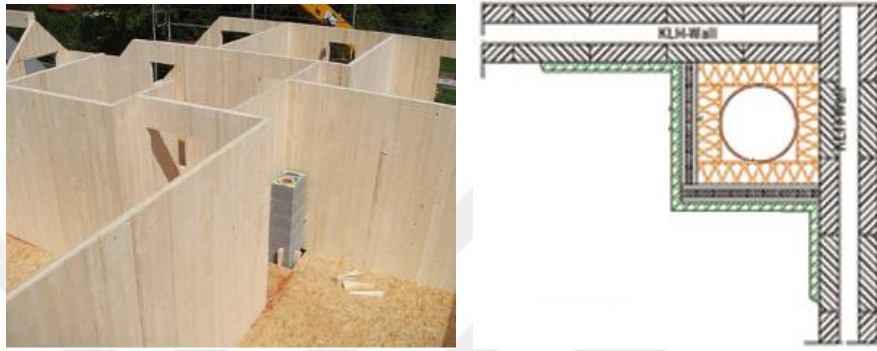
Şekil 3.8 CLT paneller ile tesisat boşluklarının oluşturulması [12,109]
