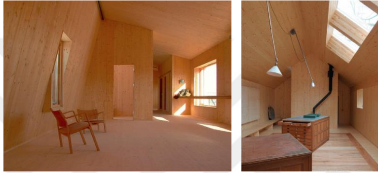
Şekil 2.14 İç ortamdaki CLT duvar ve döşeme elemanlarının görünümü [26]
