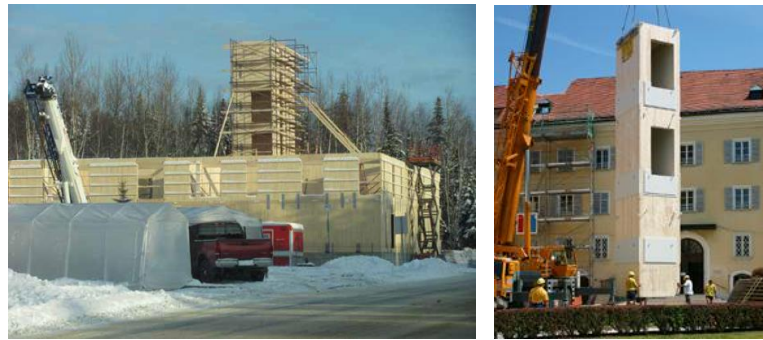
Şekil 3.7 CLT paneller ile üretilen asansör boşlukları [2,109]
