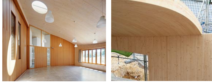
Şekil 3.18 CLT paneller ile eğrisel çatı uygulaması [109]
