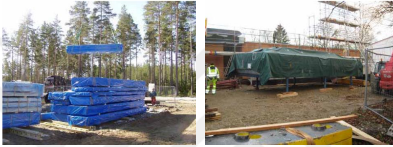
Şekil 3.29 CLT panellerin dış ortam koşullarından korunması [2]
