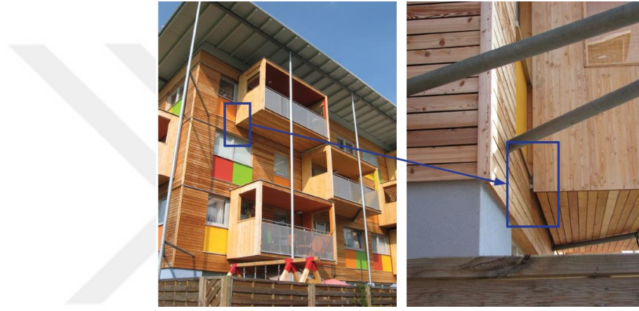
Şekil 3.11 CLT panel yapı sistemi ile balkon oluşturulması [1]
