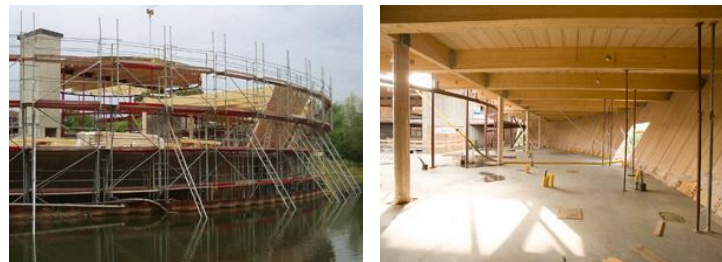
Şekil 3.5 CLT paneller ile eğimli duvar oluşturma [109]
