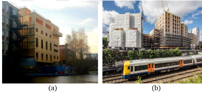
Şekil 2.5 Londra'da çok katlı CLT panel yapı örnekleri [26, 34]
