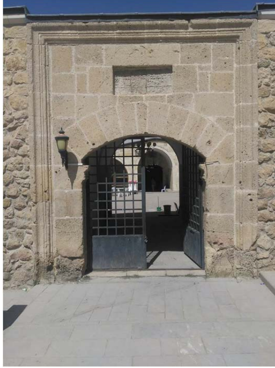
Şekil 3.126 Hekimhan ribat yapısının avlulu bölümü taç kapısı fotoğrafı (Arapoğlu, 2018)
