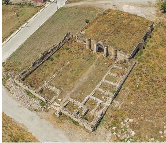
Şekil 3.140 Çardak ribatı genel görünüm fotoğrafı (Divarçı, 2017)
