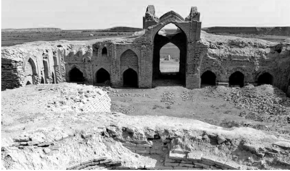
Şekil 3.90 Daye Hatun Kervansarayı (ribat) iç avludan giriş bölümünü gösteren fotoğraf (Muradov, 2009).
