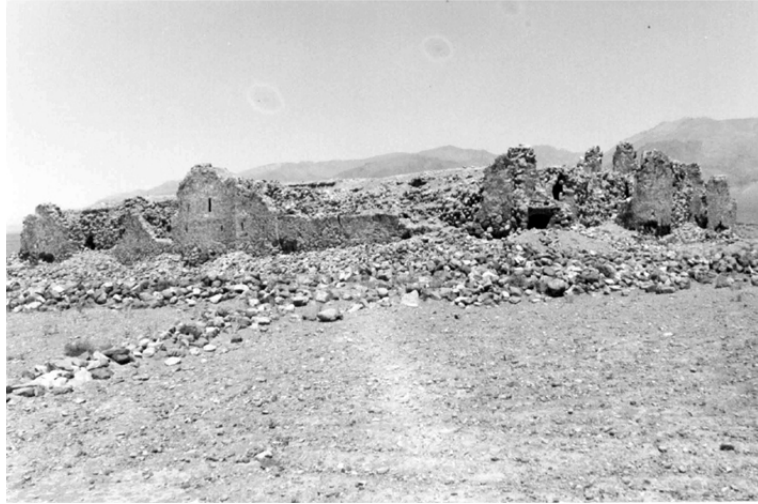
Şekil 3.102 Ribat-ı Qilli güneybatı cephesi fotoğrafı (O’Kane, 1982)
