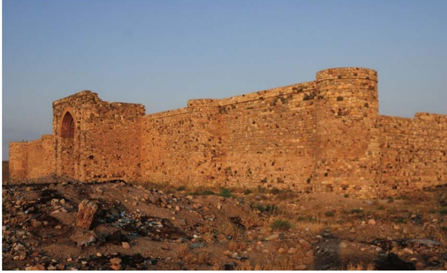
Şekil 3.80 Ribat-ı Anuşirvan giriş cephesi fotoğrafı (Anonim, www.selcuklumarasi.com, 2018) 1
