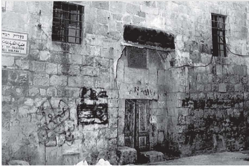
Şekil 3.22 Bayram Çavuş ribatı restorasyon çalışmaları öncesi çekilen kuzey cephesi fotoğrafı (Natsheh, 2011) 1
