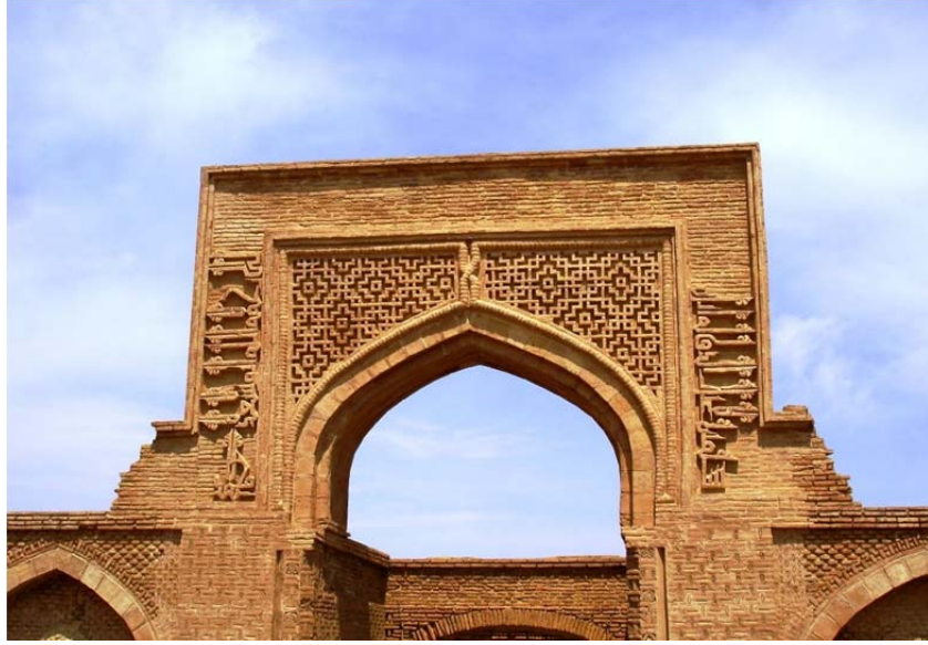
Şekil 3.87 Ribat-i Şerif kemerli taç kapısı fotoğrafı (Taaghi, 2018)
