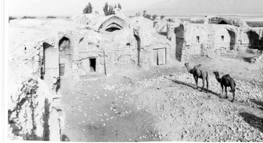
Şekil 3.100 Ribat-ı Ishq avlunun güney eyvanındaki mekânı gösteren fotoğraf (O’Kane, 1982)
