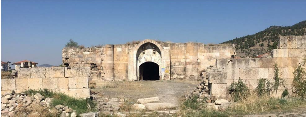
Şekil 3.142 Çardak ribatı kapalı bölümü giriş cephesini gösteren fotoğraf (Arapoğlu, 2019)
