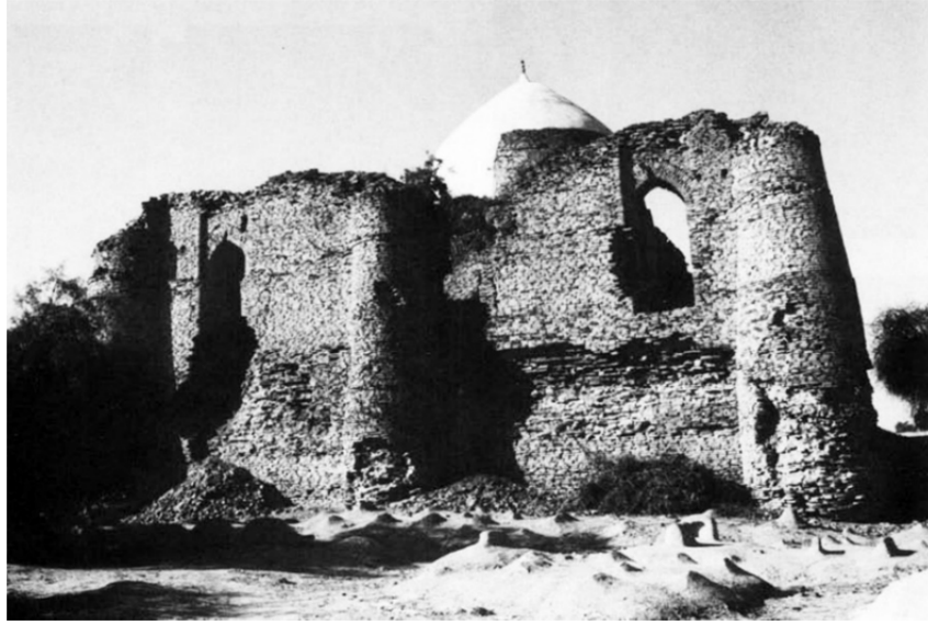
Şekil 3.94 Ribat-ı Ali bin Karmakh giriş cephesi fotoğrafı (Edwards, 1991).
