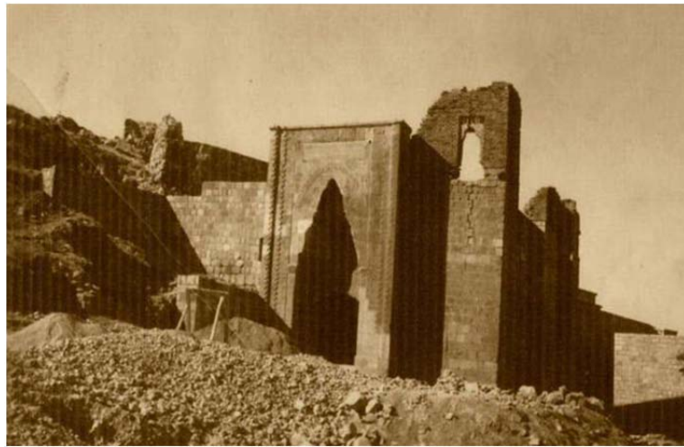
Şekil 3.121 Ashab-ı Khef ribatı giriş cephesi fotoğrafı (VGM Gaziantep Vakıflar Bölge Müdürlüğü Arşivi, 1940)
