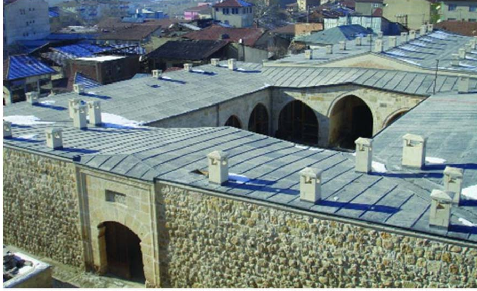
Şekil 3.128 Hekimhan ribatı güney cephesi fotoğrafı (malatya.bel.tr, 2018)
