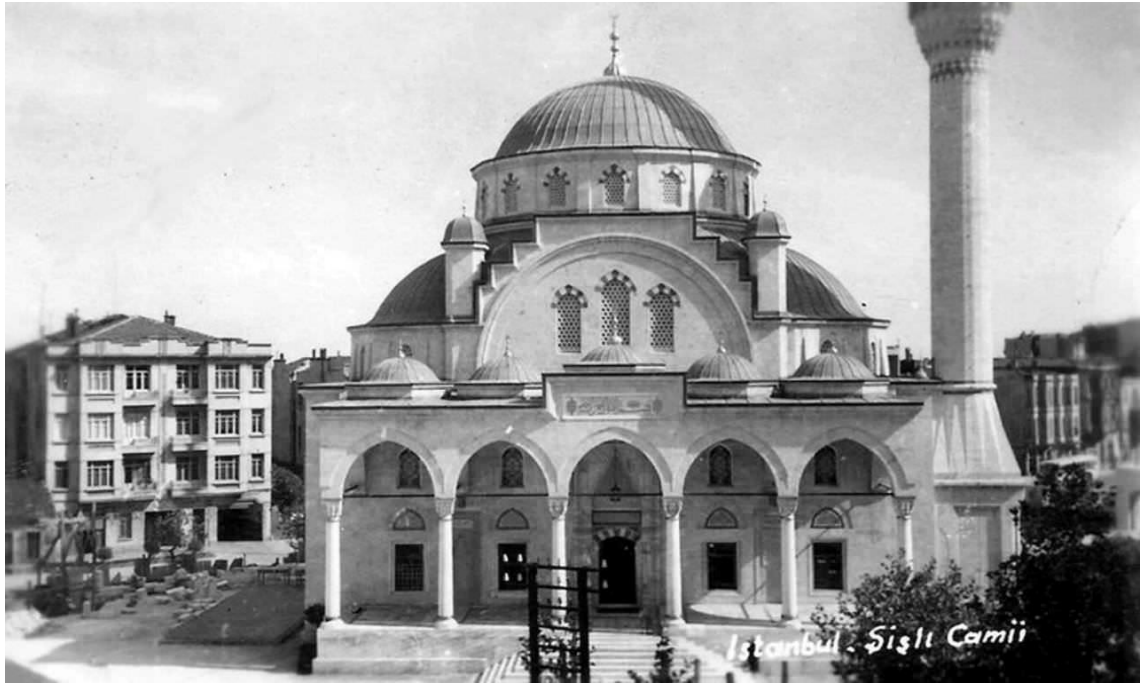
Şekil 2.5 Şişli Camii, İstanbul, 1945-1953
