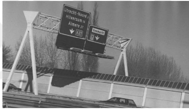
Şekil 2.3 A27 otoyolunda yer alan FVGE'nin alt dizisinin yol işaretleri tarafından gölgenmesi [60]
