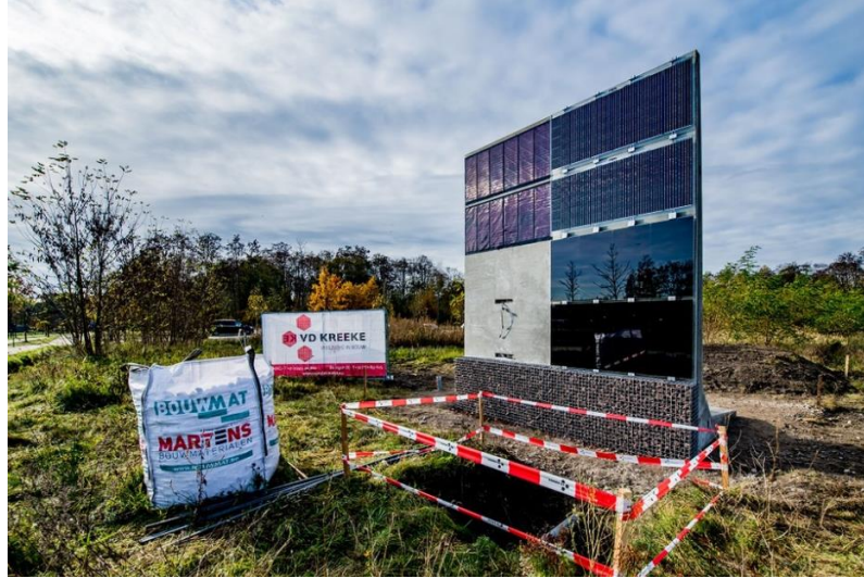
Şekil 2.13 Rolling Solar Fotovoltaik entegre edilen gürültü engelinin ilk kısmının kurulumu [140]
