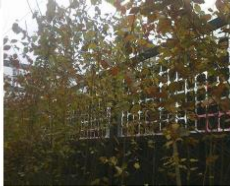
Şekil 2.7 Almanya Münsingen'de yer alan FVGE uygulamasının bitkiler nedeniyle gölgelenmesi
