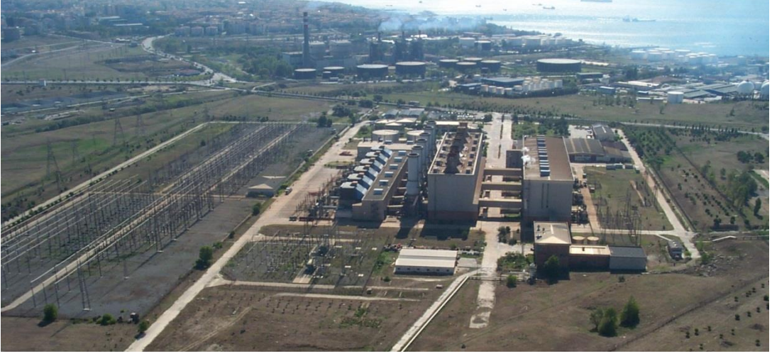
Şekil 4.6 Ambarlı doğalgaz kombine çevrim santrali
