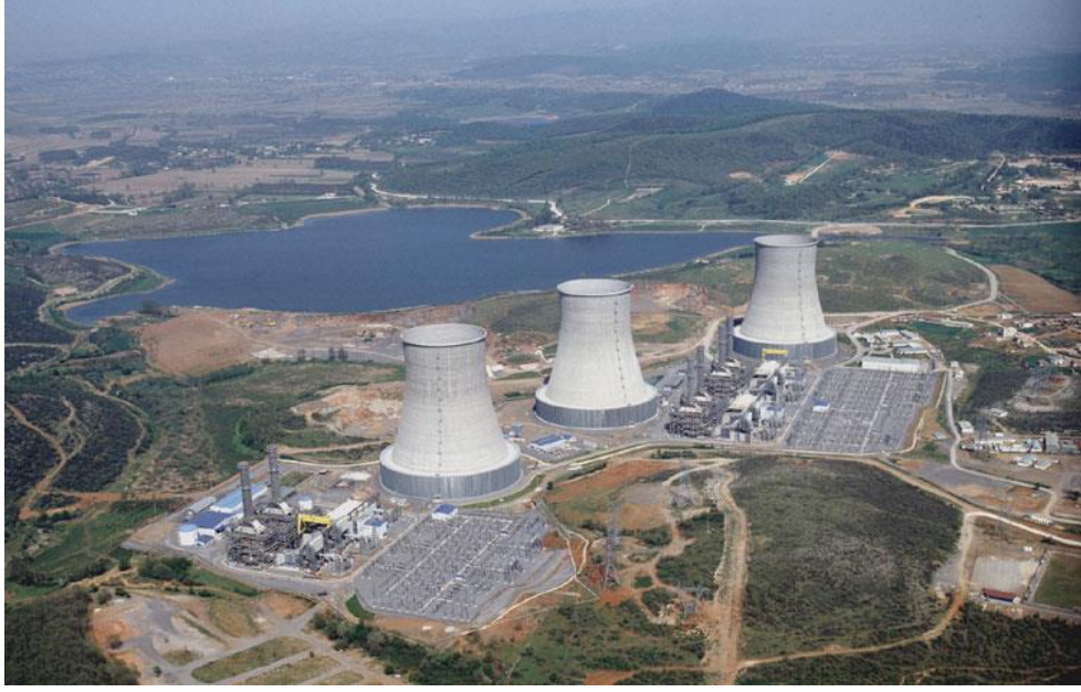
Şekil 4.9 ENKA Adapazarı doğalgaz yakıtlı kombine çevrim santrali
