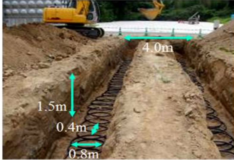
Hatve çapı 0,80 m, hatveler arası mesafe sırasıyla 0,40 m, 0,60 m ve 0,80 metredir.
