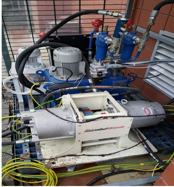
Şekil 5. 19 Test düzeneği yerleşimi bitmiş hali
