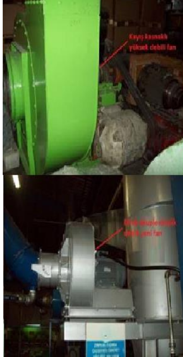
Şekil 6.10 Raspa makinesi fanının değiştirilmesi
