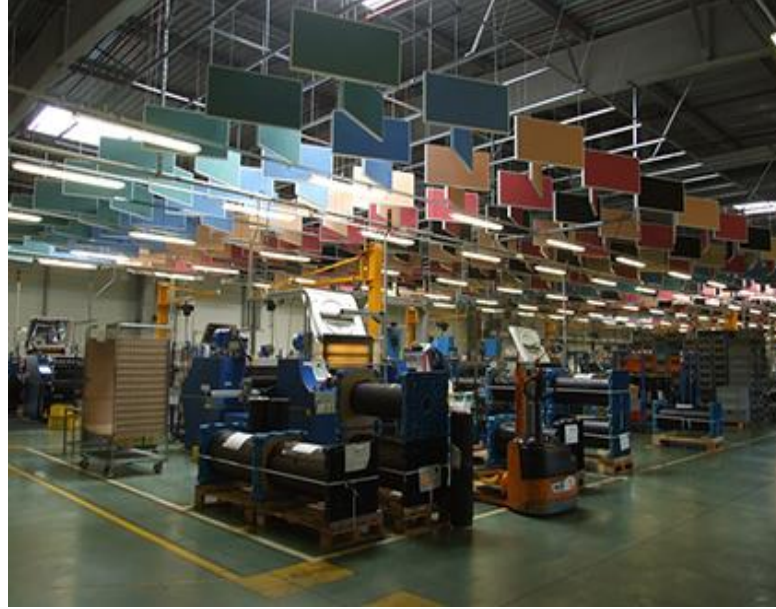
Şekil 6.22 Mekanik işlem bölümü akustik baffle uygulaması
