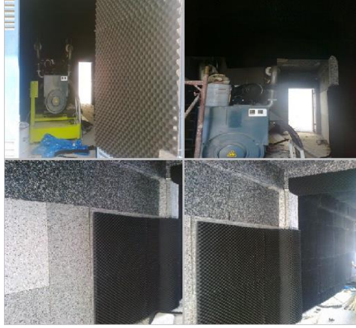
Şekil 5.13 Radyal fan kabini duvar ve ses yalıtım uygulaması
