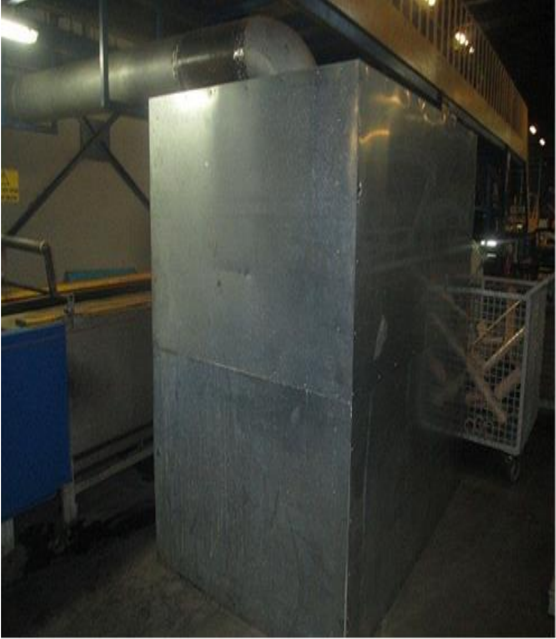
Şekil 6.11 Ekstrüder hattı blower fanına izolasyon kabini yapılması
