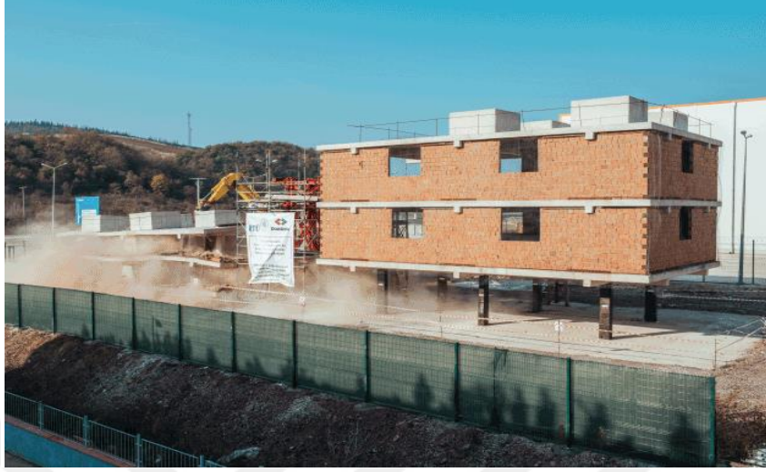
Şekil 1.3 Yıkılan bina ve FRP ile güçlendirilip ayakta kalan bina
