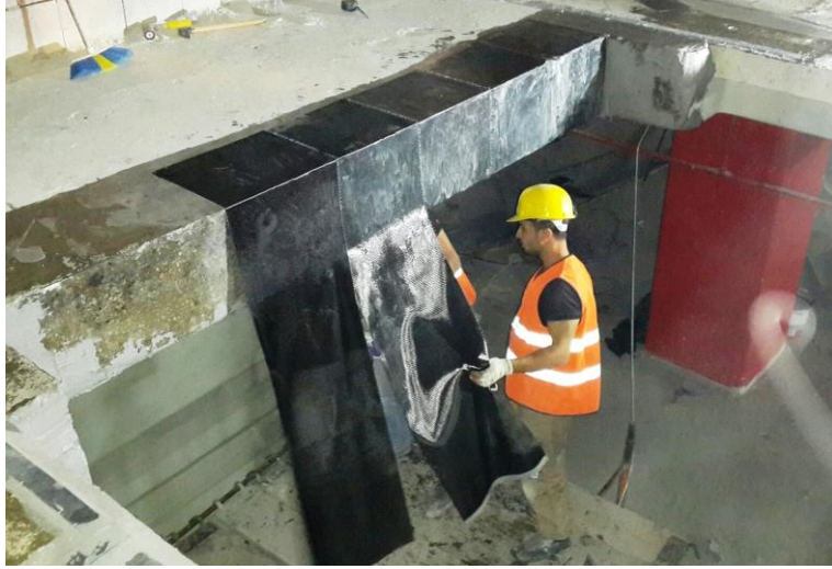
Şekil 1.2 Karbon lifli polimer kompozitin uygulanması [4]
