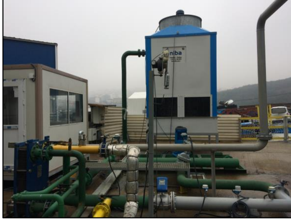
Şekil 5.1 Soğutma Kulesi Test Düzenegi
