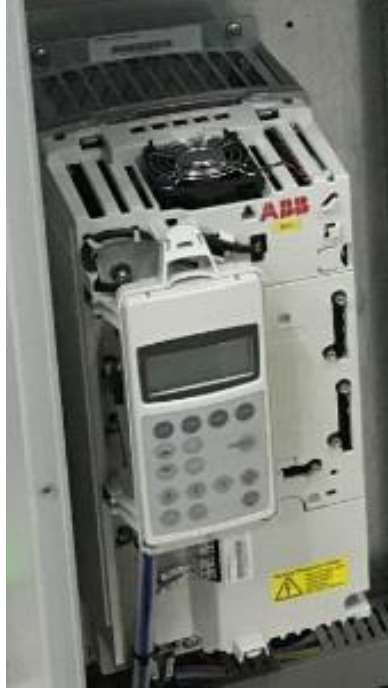
Şekil 4. 12 Motor sürücüsü
