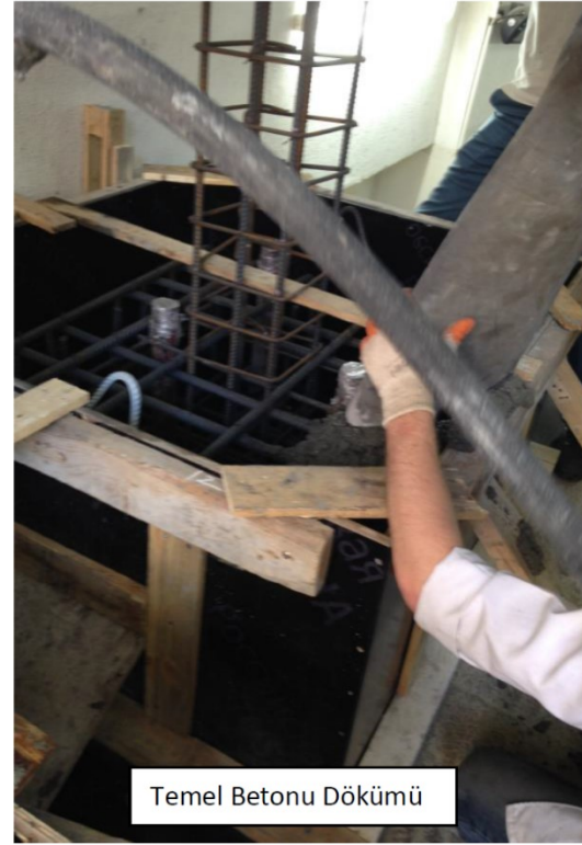
Şekil 2.3 S351008-S352008-S353508 kolonlara ait imalat fotoğrafları
