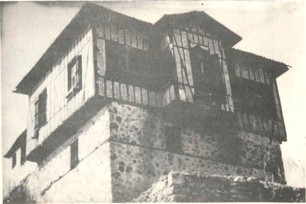
r.21 ZEMİN KAT YÜKSEKLİĞİNDEKİ KÂGİR YIĞMA TEMEL ÜZERİNE, İŞLENMİŞ AĞAÇ İSKELET YAPI KURULUŞU -Ankara bağevi-
