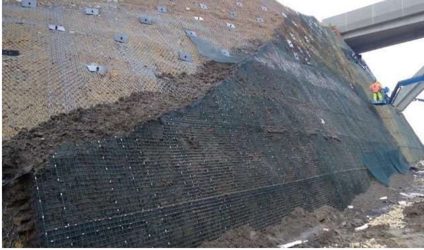
Şekil 2.11 Püskürtme beton kaplamalı duvar
