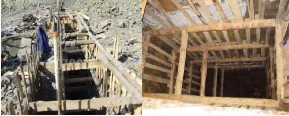
Şekil 2.9 Kuyu perde duvar
