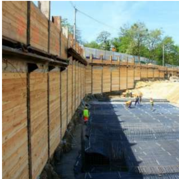
Şekil 2.13 Ahşap kaplamalı Berlin duvarı
