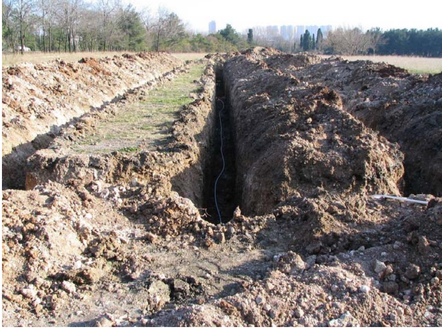
řekil 6.1 Toprak ısı deęiřtiricisinin yerleřimi
