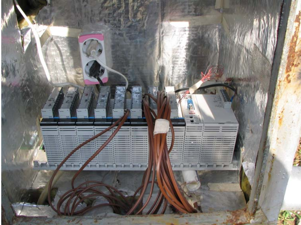
Şekil 6.8 PLC ve ısı çiftlerinin bağlantısı
